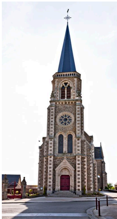
Vue d'ensemble depuis l'ouest. Phot. Yves Guillotin IVR52_20155300114NUCA
