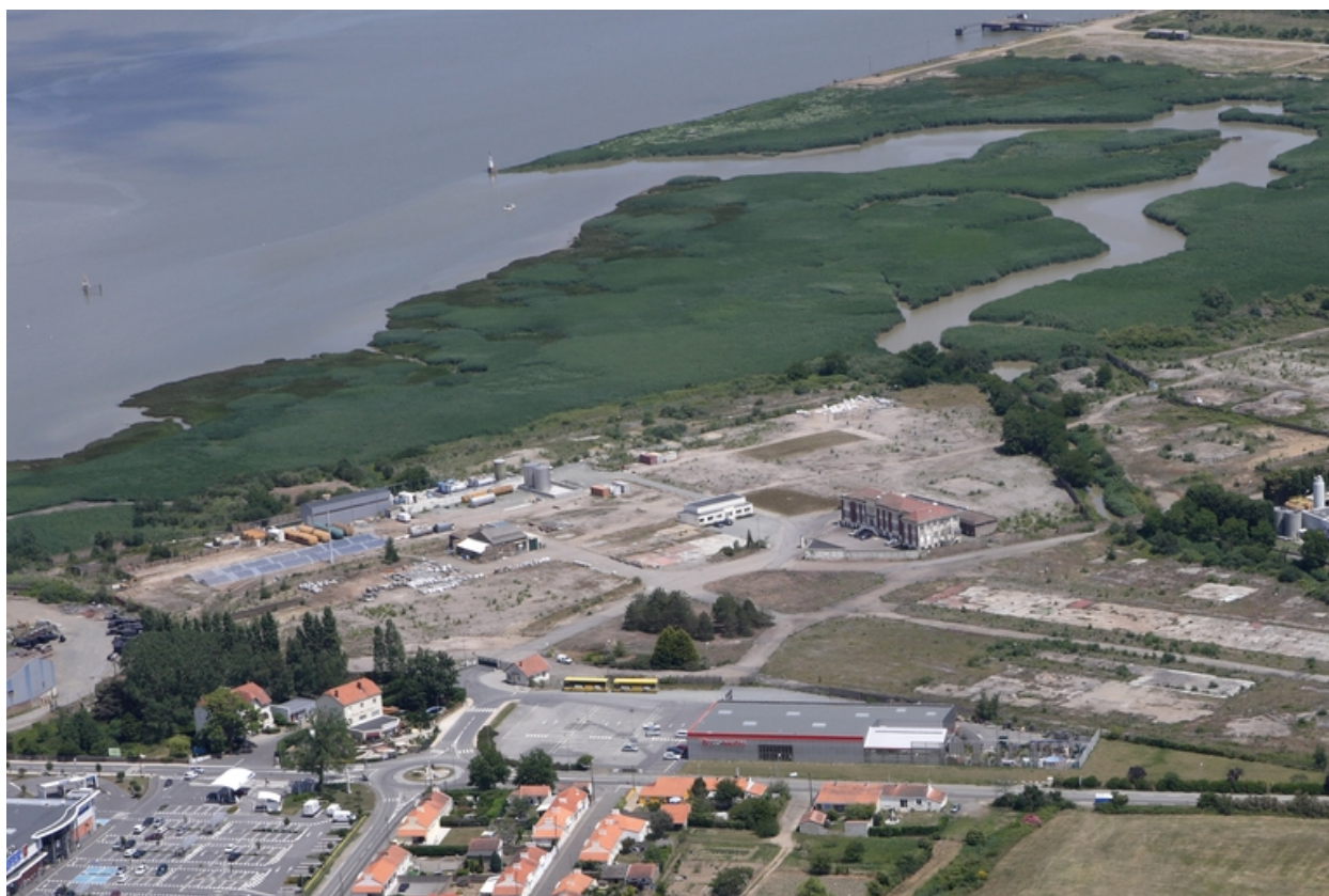
Vue aérienne de l'ancien site industriel Kuhlmann en 2010.
