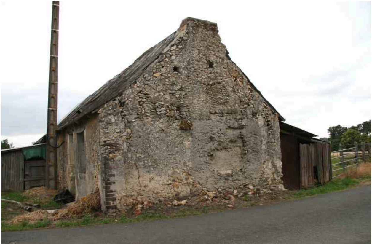
Pignon de la maison.
