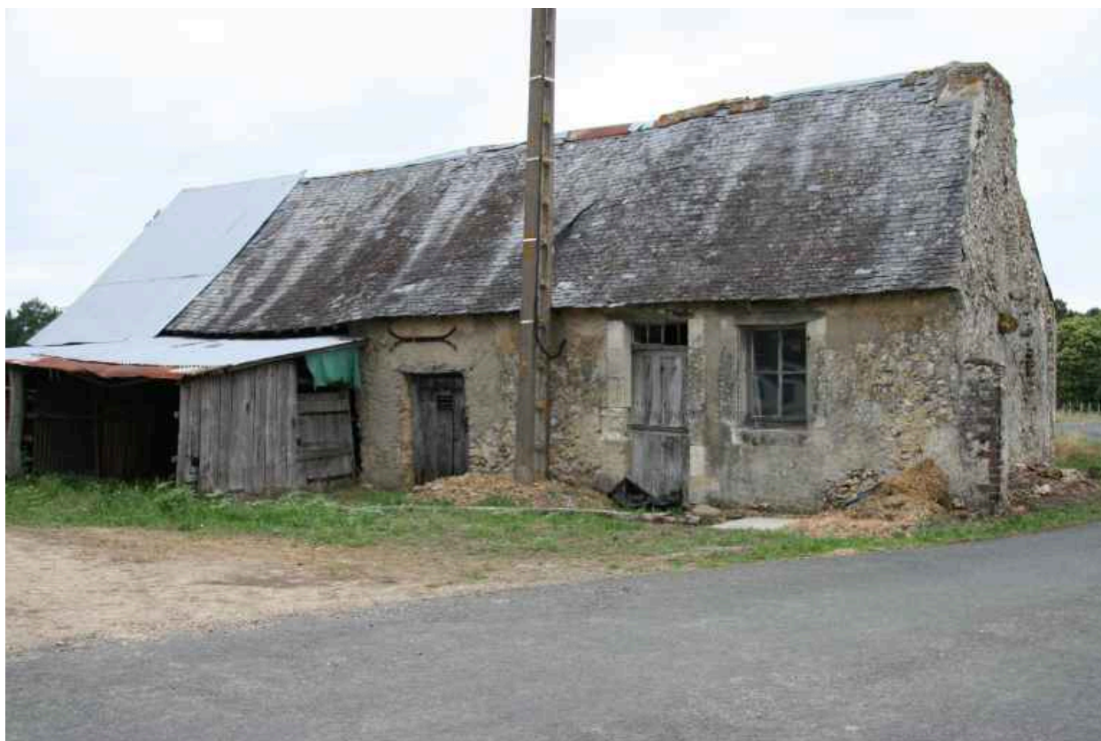
Vue de volume de la maison.
