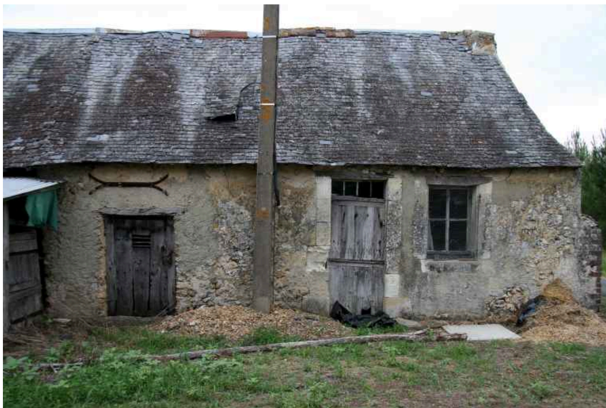
Façade antérieure sur la cour.
