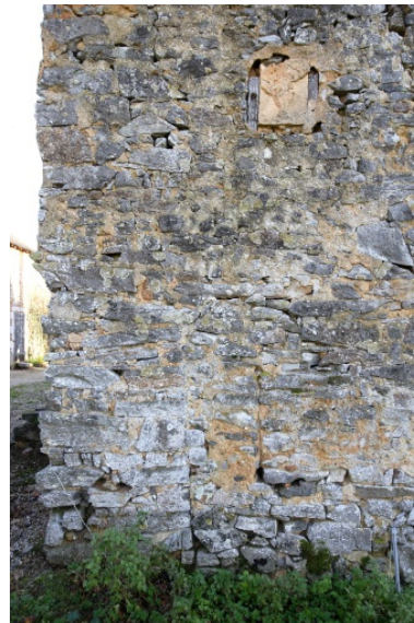
Détail du pignon nord-ouest du logis, réutilisant le mur-gouttereau de l'ancien logis double. Phot. François Lasa IVR52_20065302834NUCA
