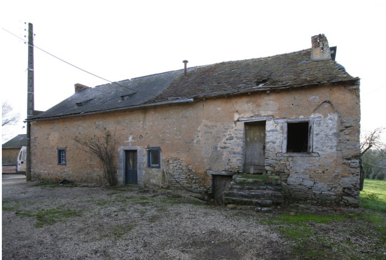
Le logis vu depuis le nord-est.
