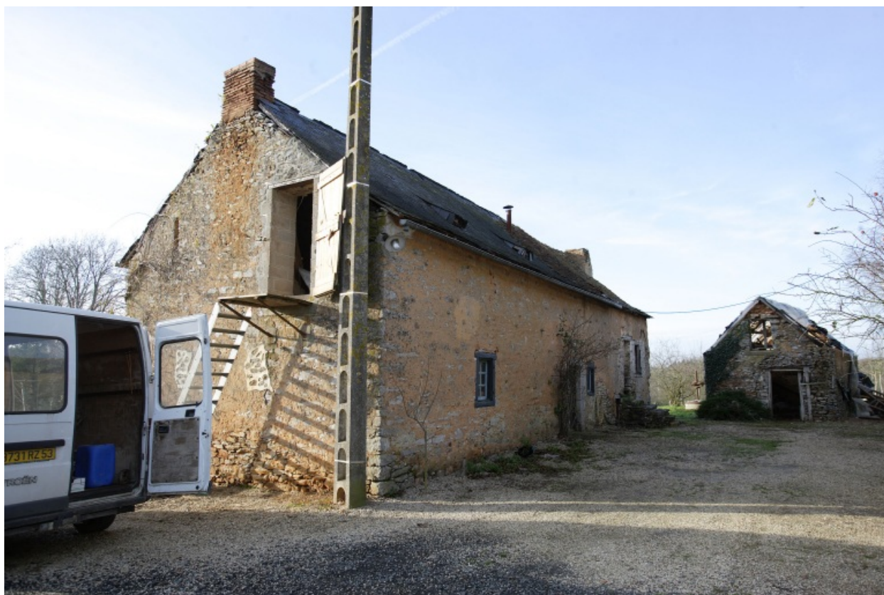
Le logis vu depuis l'est.
