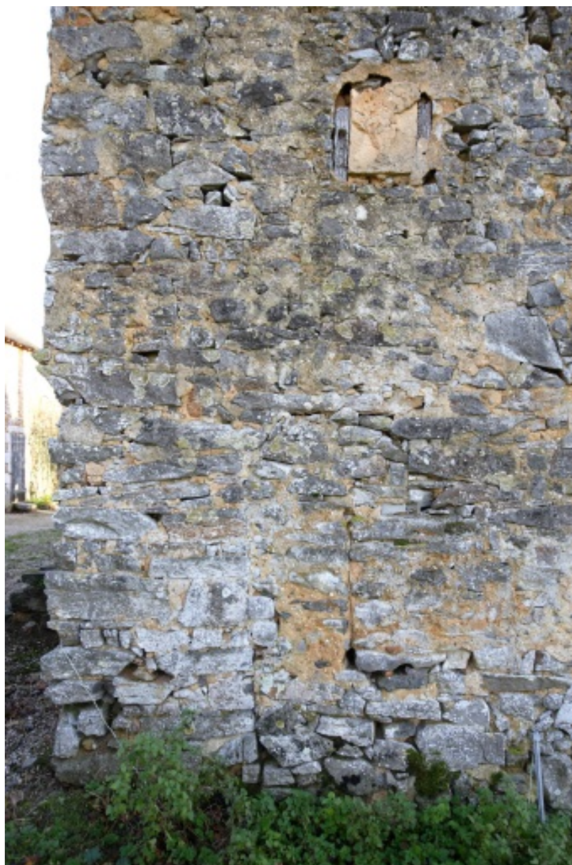
Détail du pignon nord-ouest du logis, réutilisant le mur-gouttereau de l'ancien logis double.
