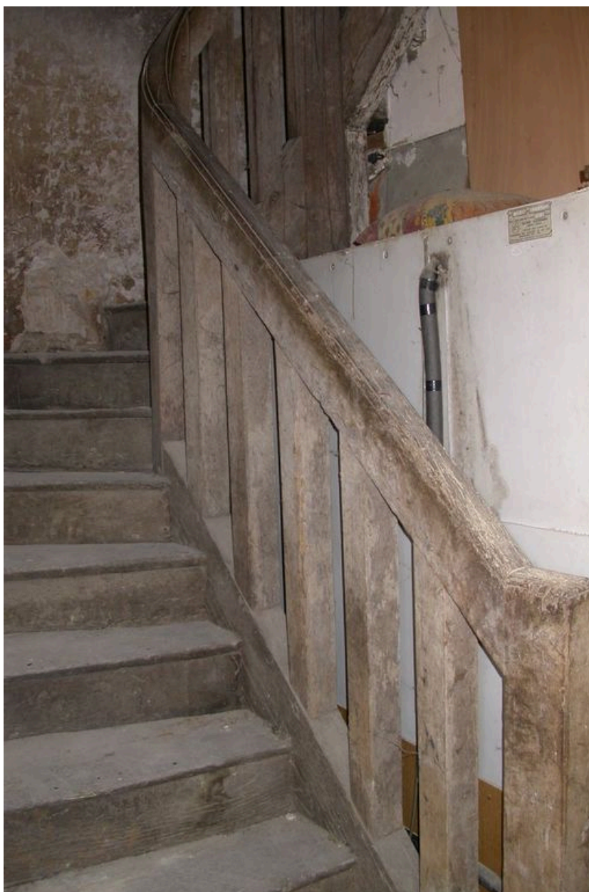
Vieux bâtiment : escalier dans œuvre, en bois.
