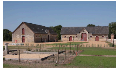
Les dépendances construites au milieu du XIXe siècle. Phot. Jean-Baptiste Darrasse IVR52_20097200464NUCA
