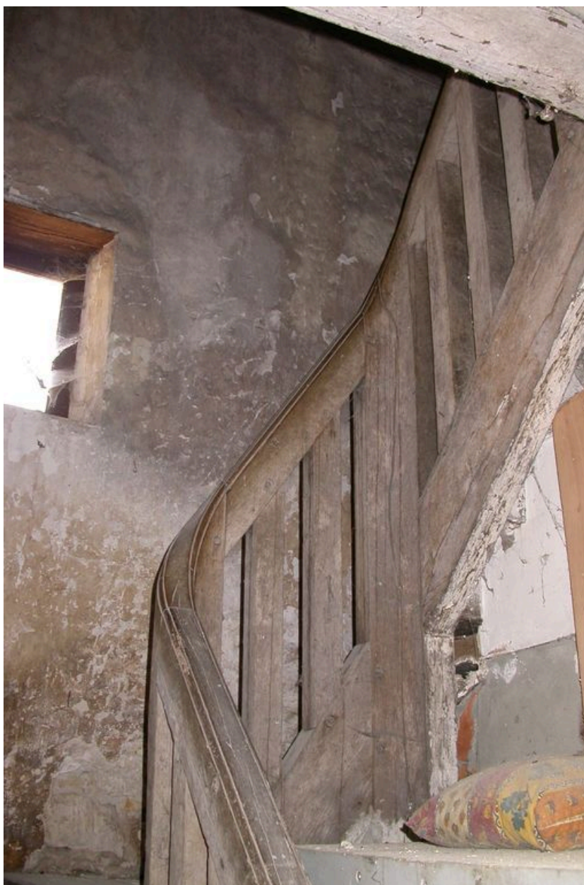
Vieux bâtiment, escalier dans œuvre tournant.
