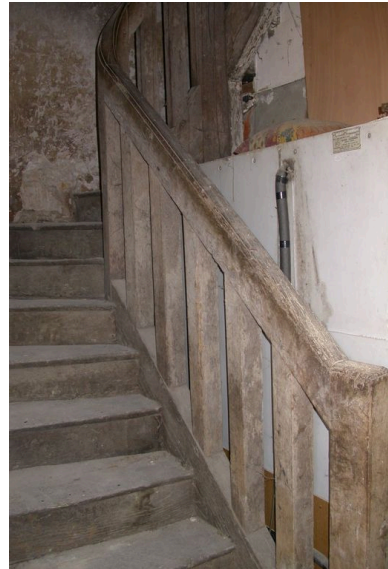
Vieux bâtiment : escalier dans œuvre, en bois. Phot. Christine Toulhier IVR52_20147201549NUCA
