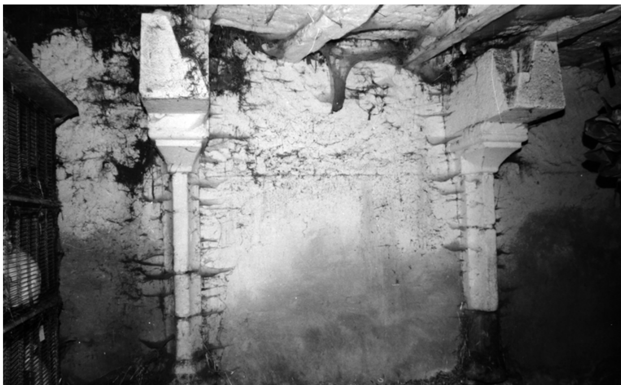
Vue de la cheminée du logis, 1990.
