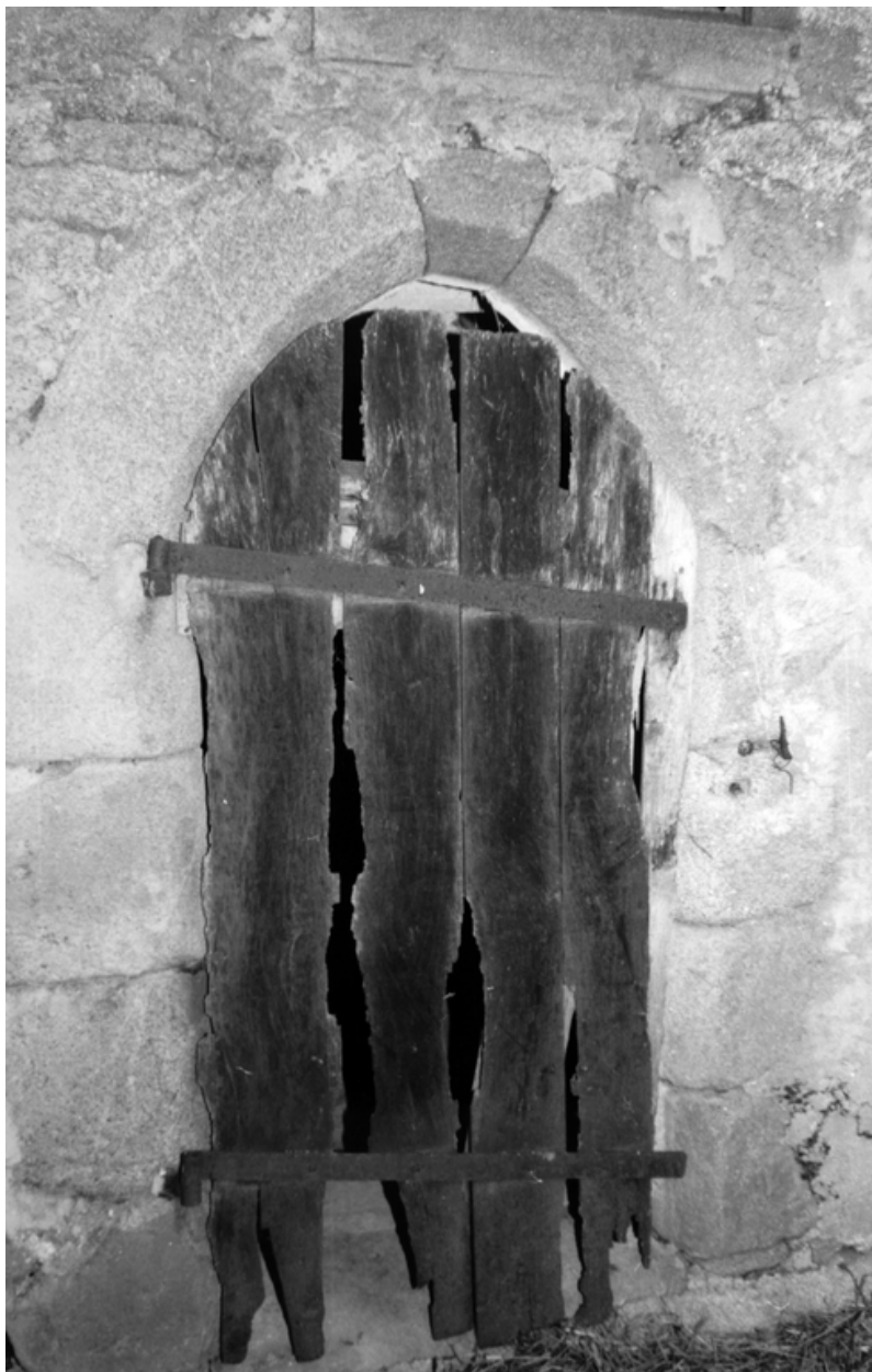
Détail de la porte de l'étable, 1990.
