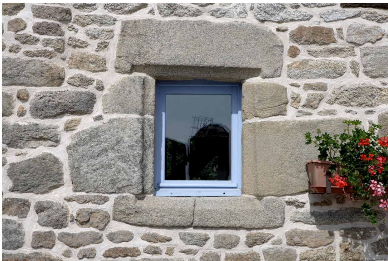
Logis. Façade est. Détail du jour.
