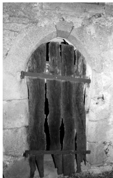
Détail de la porte de l'étable, 1990. Phot. Denis Pillet IVR52_20094401433NUC
