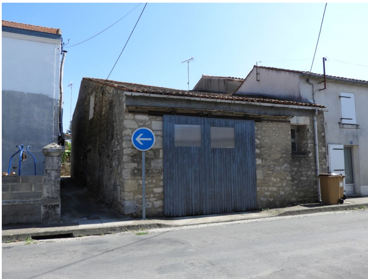
La remise à l'arrière de la maison, rue Nationale, vue depuis le nord-ouest.
