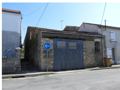
La remise à l'arrière de la maison, rue Nationale, vue depuis le nord-ouest. Phot. Yannis Suire IVR52_20198500053NUCA
