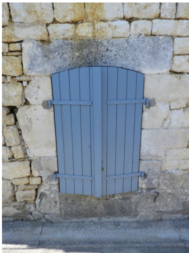
Une des baies du rez-de-chaussée, avec linteau en arc segmentaire. Phot. Yannis Suire IVR52_20198500064NUCA
