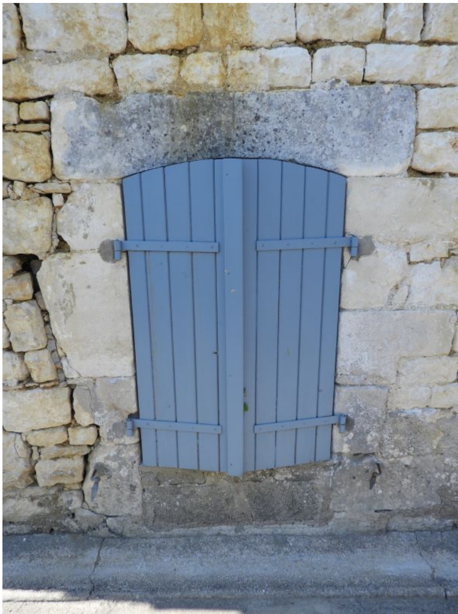
Une des baies du rez-de-chaussée, avec linteau en arc segmentaire.
