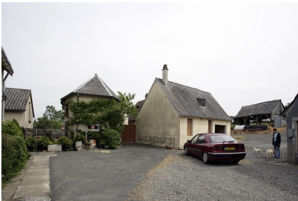
A gauche, l'étable-grange vue depuis l'ouest.
