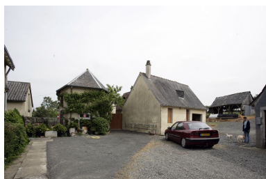
A gauche, l'étable-grange vue depuis l'ouest. Phot. François Lasa IVR52_20075302207NUCA
