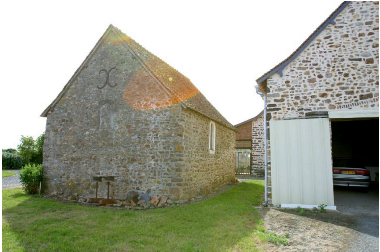
Vue depuis l'est : chevet, élévation nord.
