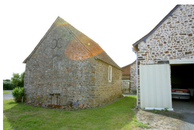
Vue depuis l'est : chevet, élévation nord. Phot. François Lasa IVR52_20035302234NUCA
