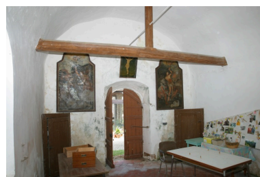
Vue intérieure depuis l'est. Phot. François Lasa IVR52_20035302298NUCA
