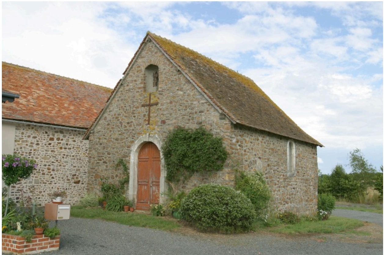
Vue depuis l'ouest : façade, élévation sud.
