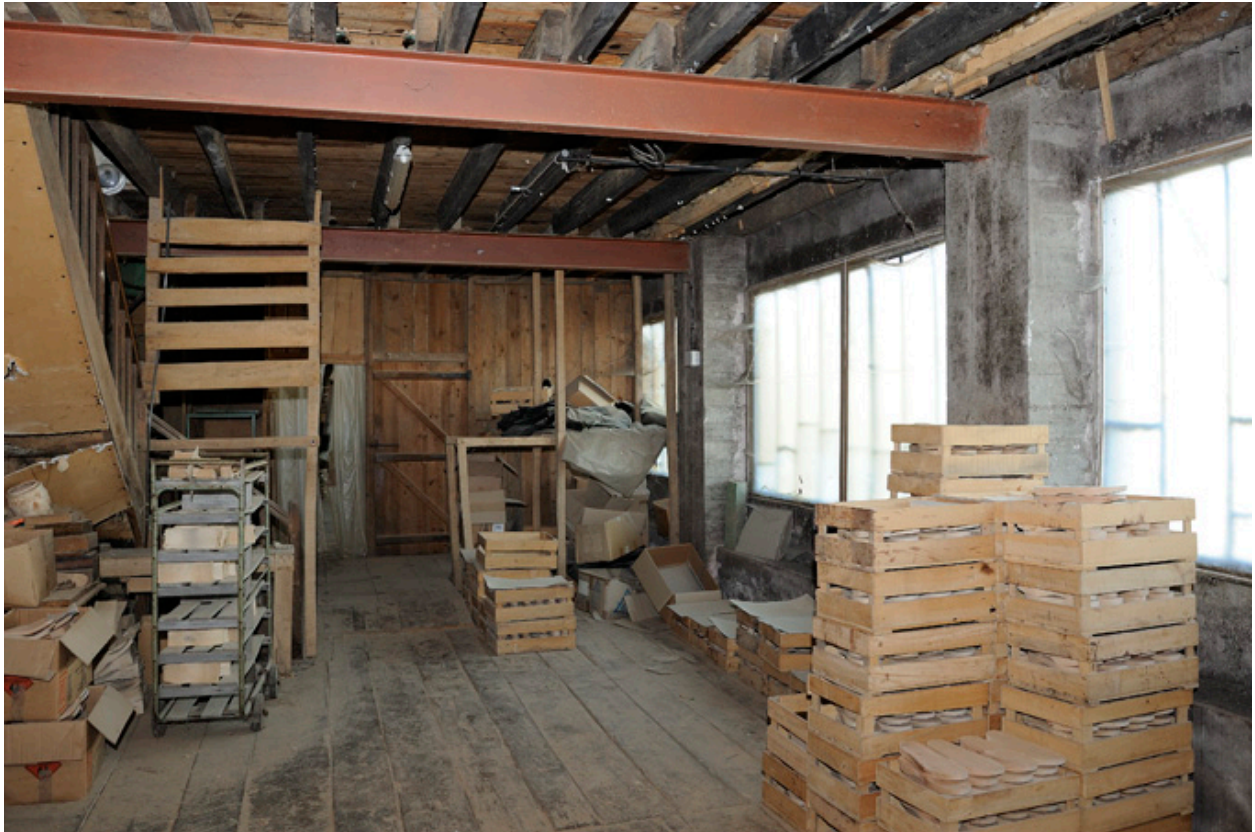
Vue intérieure du bâtiment situé au 1 rue Bardeau : 2e étage consacré au stockage.
