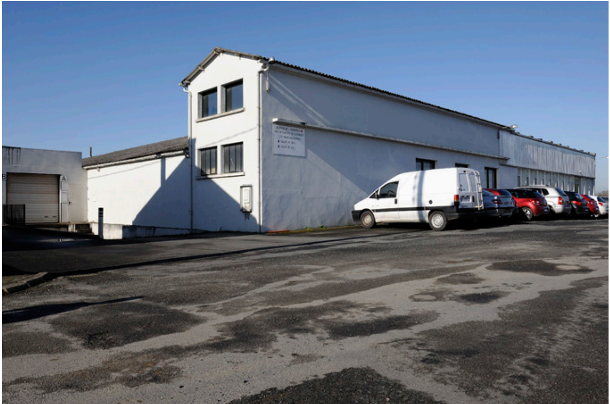
Vue générale du bâtiment de la saboterie Audouin, situé au 4 rue des Amourettes.
