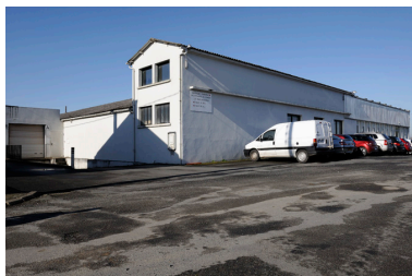
Vue générale du bâtiment de la saboterie Audouin, situé au 4 rue des Amourettes. Phot. Bruno Rousseau IVR52_20114900434NUCA
