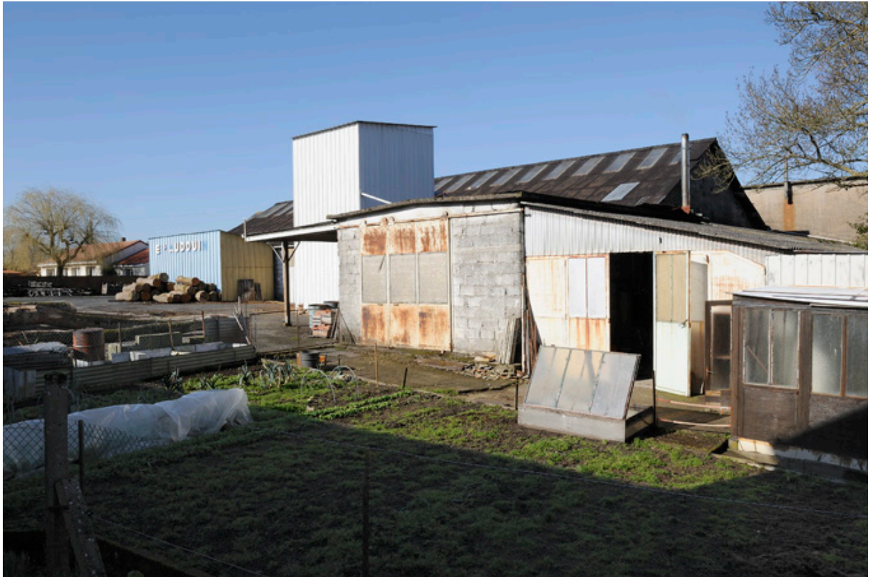
Bâtiment de l'entreprise Audouin, situé au 1 rue Bardeau.
