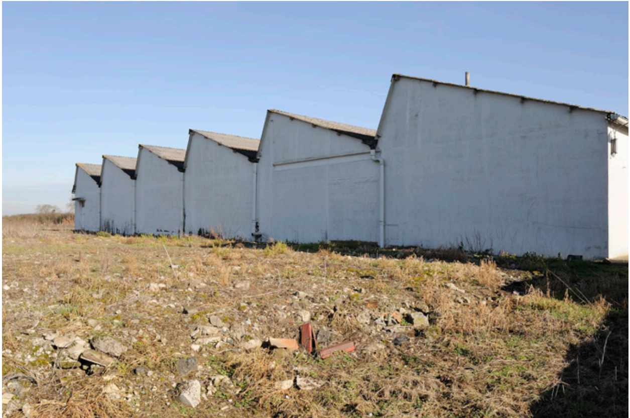
Façade sud-ouest du bâtiment, situé au 4 rue des Amourettes.
