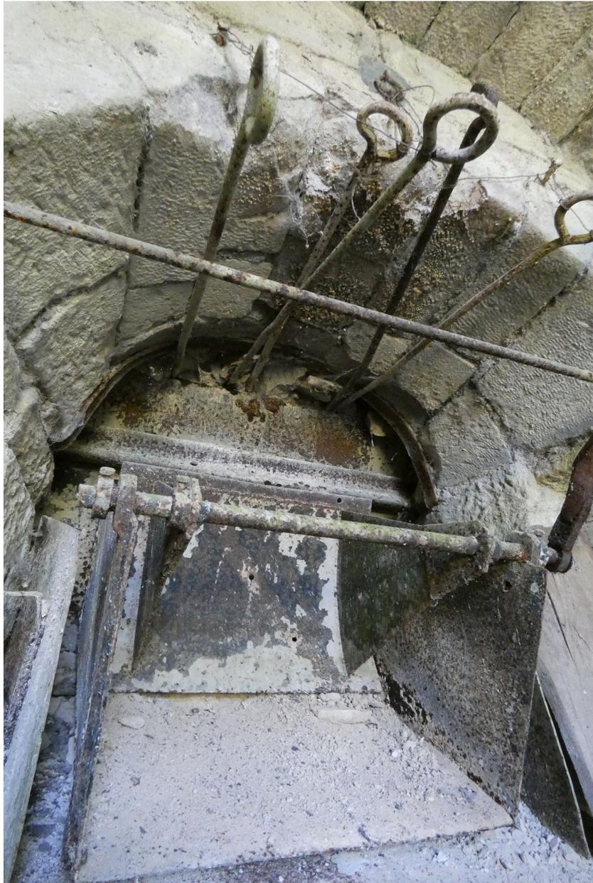
Trappe de défournement et son mécanisme.
