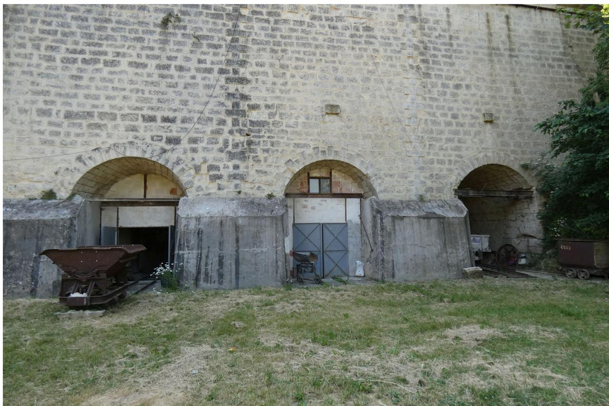
Ouvertures à la base des fours pour le défournement de la chaux vive et son évacuation par wagonnets.
