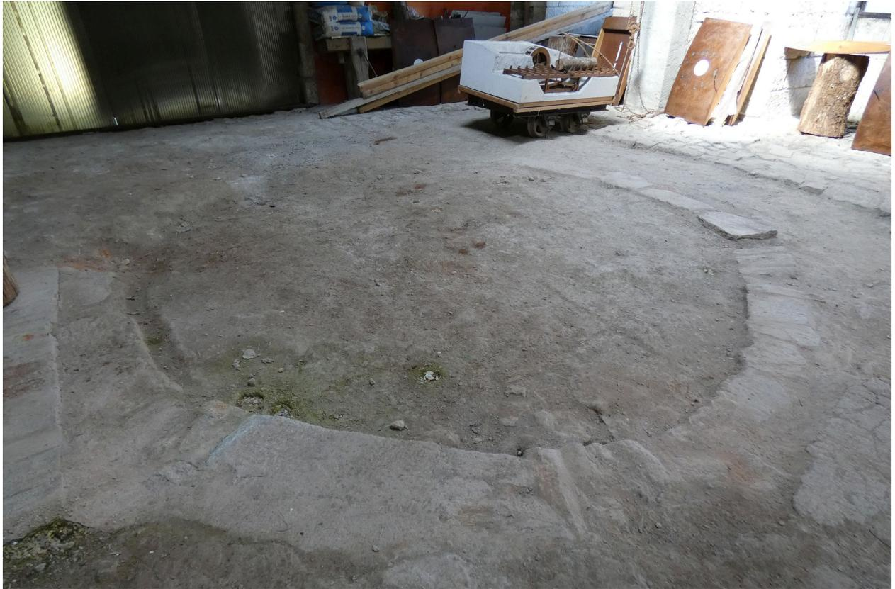
Gueulard ou emplacement de la partie supérieure, cylindrique, d'un des fours, démantelée.
