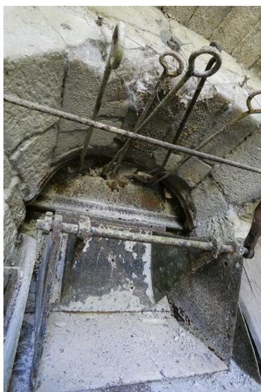
Trappe de défournement et son mécanisme.
