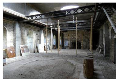
Le niveau supérieur du bâtiment des fours, avec au premier plan, l'emplacement de l'ancienne partie supérieure d'un four, et à l'arrière-plan, la partie supérieure d'un four conservée.
