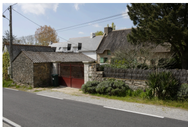
Vue d'ensemble depuis le sud-est. Phot. Denis Pillet IVR52_20084401438NUCA
