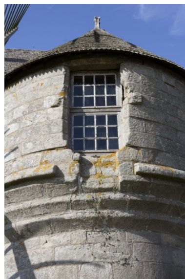
Moulin de Crémeur. Porte haute sud-est avec les vestiges des corbeaux du travaillet. Phot. Denis Pillet IVR52_20074401531NUCA
