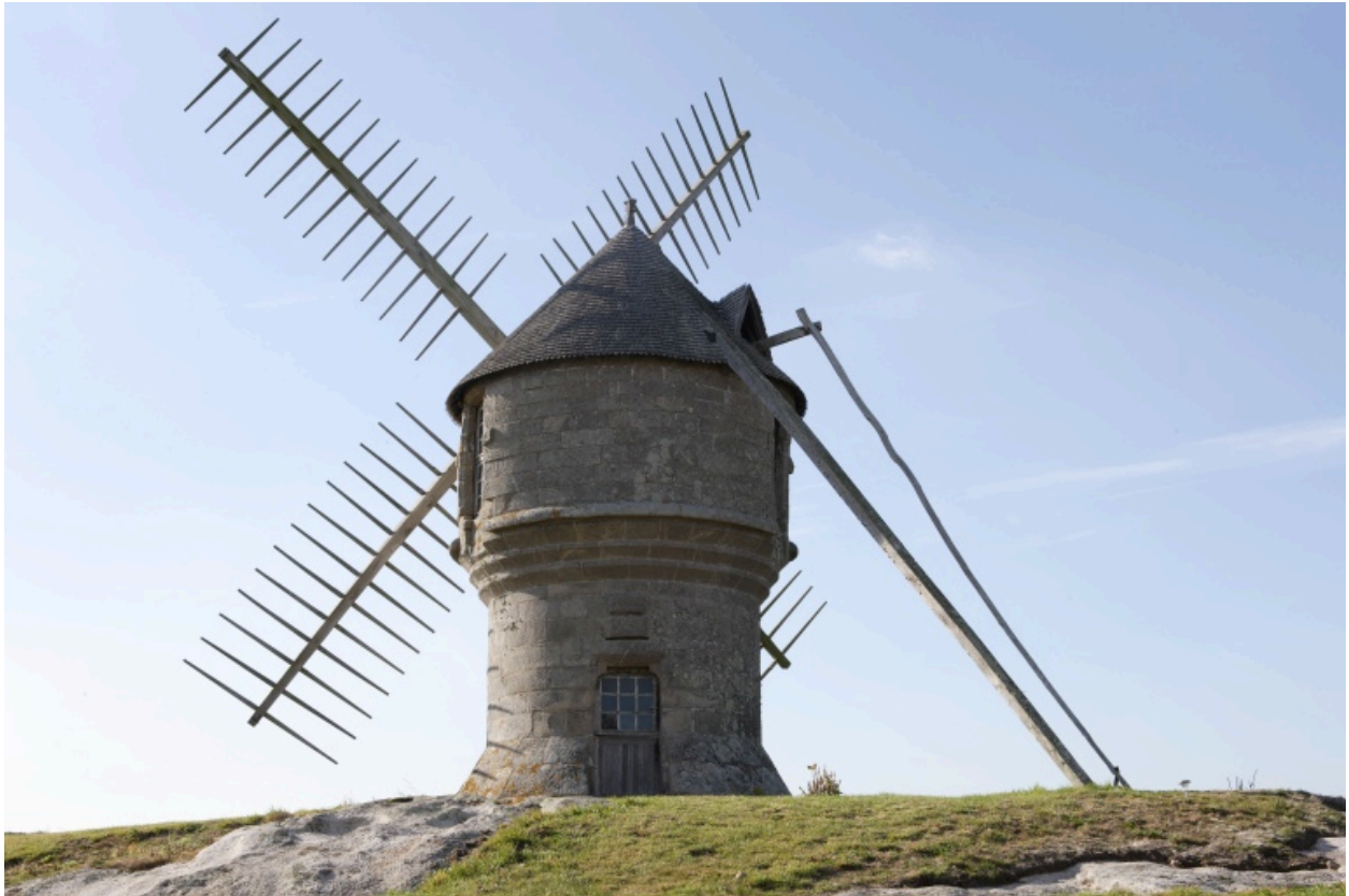
Moulin de Crémeur (restauré en 1972). Vue d'ensemble. Il est équipé d'ailes à voiles ; à droite le guivre servant à faire virer la coiffe et la perche du frein.
