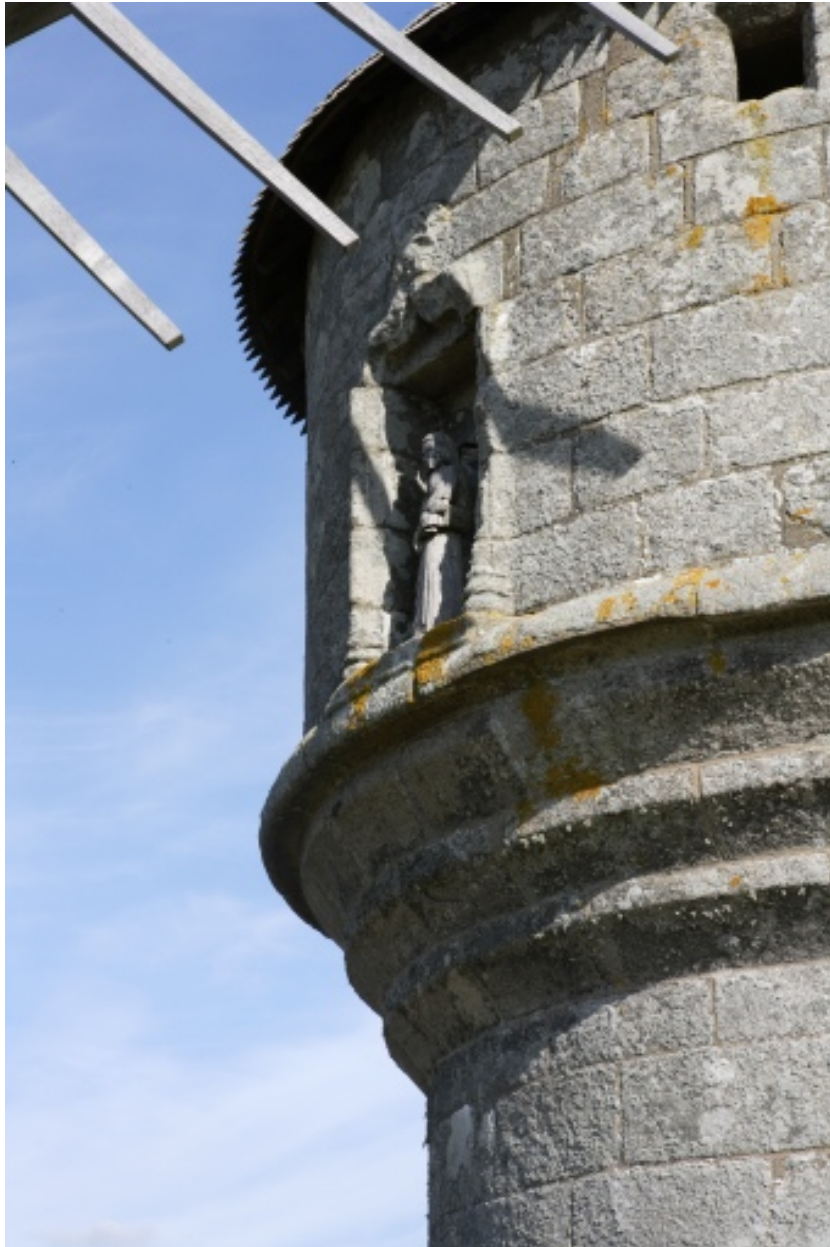
Moulin de Crémeur. Détail de la mouluration de l'encorbellement.
