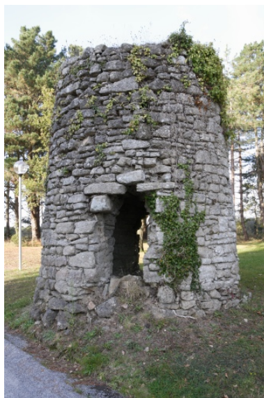
Moulin turquois de Tréveday. La tourelle, vue d'ensemble. Phot. Denis Pillet IVR52_20074401572NUCA
