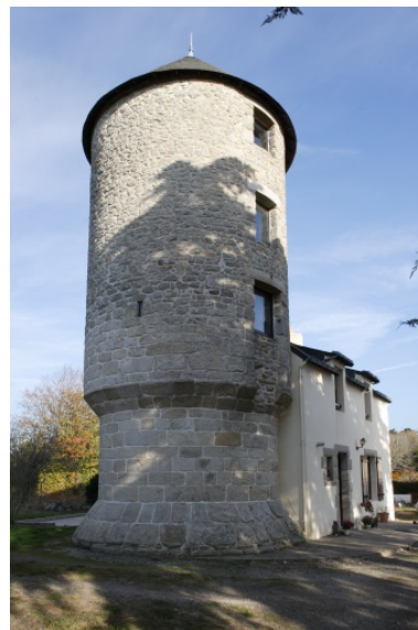
Moulin de Careil. Vue d'ensemble. Phot. Denis Pillet IVR52_20074401562NUCA
