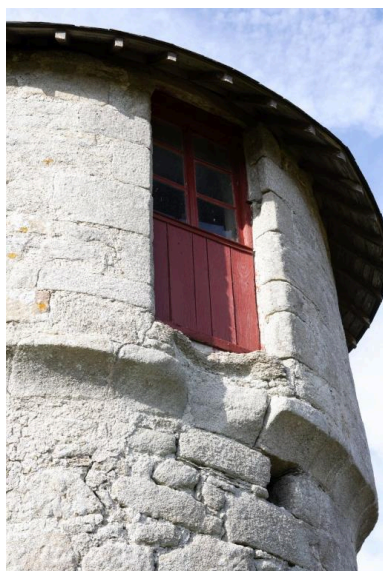
Moulin de Drézeux. Détail de l'encorbellement et de l'une des portes hautes. Phot. Denis Pillet IVR52_20074401550NUCA
