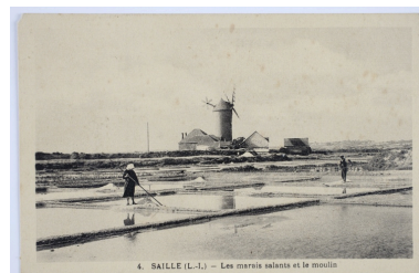
Moulin de Saillé. Vue du moulin équipé de ses ailes Berton et de son moulinet d'orientation. Phot. Denis (reproduction) Pillet IVR52_20074401842NUCA
