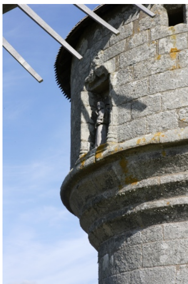
Moulin de Crémeur. Détail de la mouluration de l'encorbellement. Phot. Denis Pillet IVR52_20074401519NUCA
