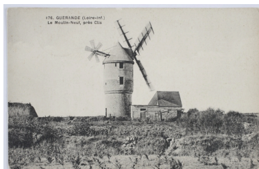
Le Moulin-Neuf, près de Clis. Vue d'ensemble du moulin. Photographie, carte postale, [s. n.], [1er quart XXe siècle]. Phot. Denis (reproduction) Pillet IVR52_20074401870NUCA
