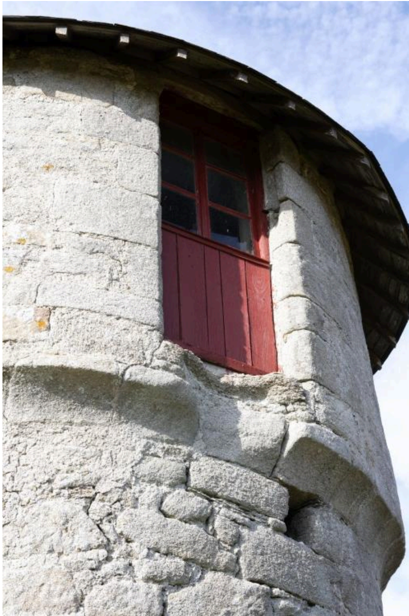
Moulin de Drézeux. Détail de l'encorbellement et de l'une des portes hautes.
