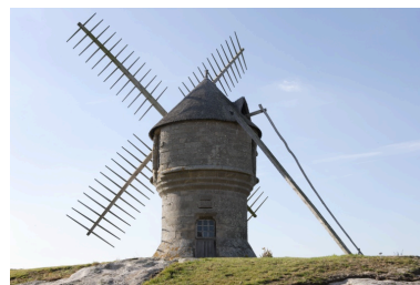
Moulin de Crémeur (restauré en 1972). Vue d'ensemble. Il est équipé d'ailes à voiles ; à droite le guivre servant à faire virer la coiffe et la perche du frein. Phot. Denis Pillet IVR52_20074401522NUCA
