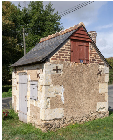
Vue d'ensemble. Phot. Jeanne Minier IVR52_20257200438NUCA
