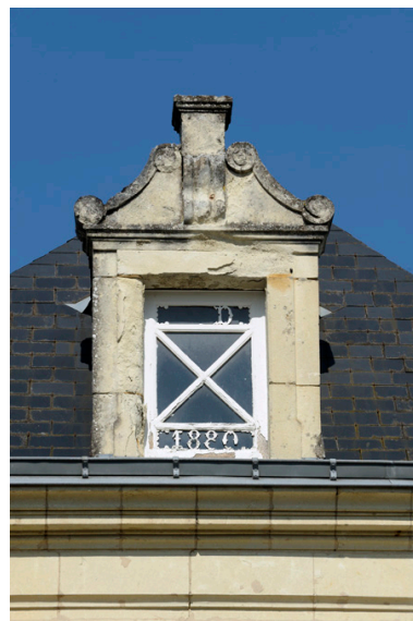
Détail de la lucarne du corps de logis de 1880 (1, rue des Coteaux). Phot. Bruno Rousseau, Phot. Youenn Communeau IVR52_20124901154NUCA
