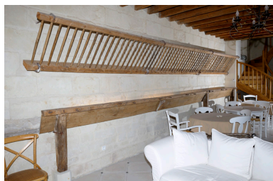
Mangeoires et râteliers des anciennes étables à chevaux (30, rue de la Socraie). Phot. Bruno Rousseau, Phot. Youenn Communeau IVR52_20124901155NUCA
