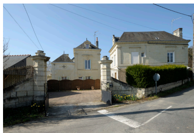
Vue générale. Phot. Bruno Rousseau, Phot. Youenn Communeau IVR52_20124901152NUCA
