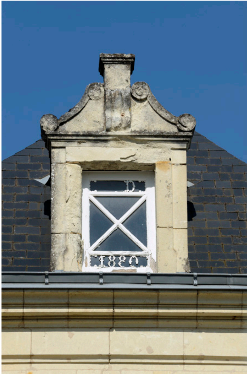
Détail de la lucarne du corps de logis de 1880 (1, rue des Coteaux).
