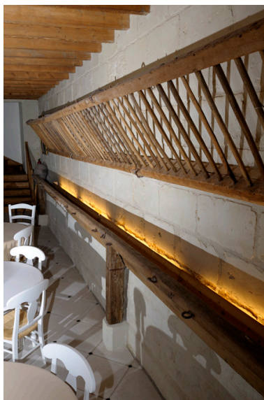
Mangeoires et râteliers des anciennes étables à chevaux (30, rue de la Socraie). Phot. Bruno Rousseau, Phot. Youenn Communeau IVR52_20124901156NUCA
