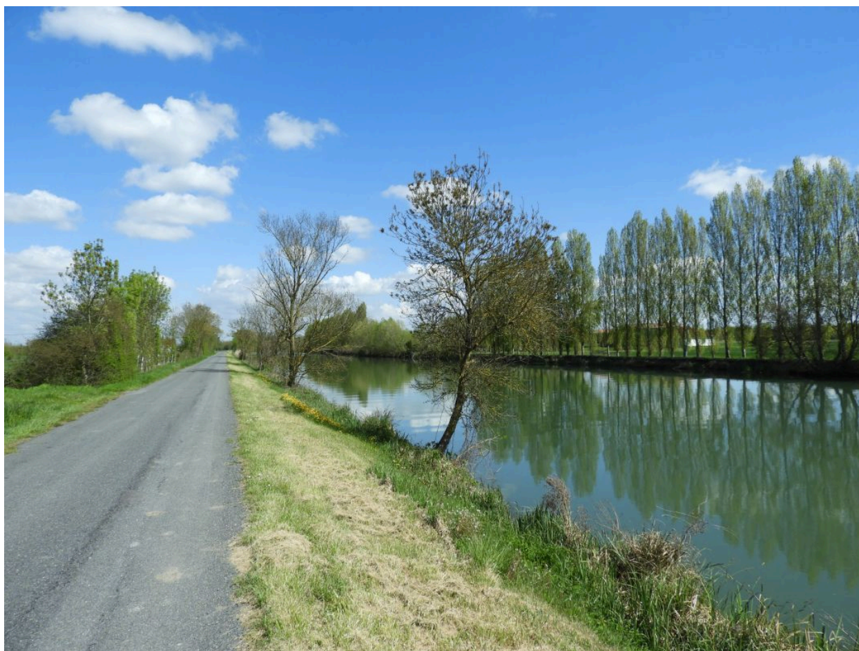
Le canal du Sablon et son chemin de halage rive droite, vus en direction de l'est.
