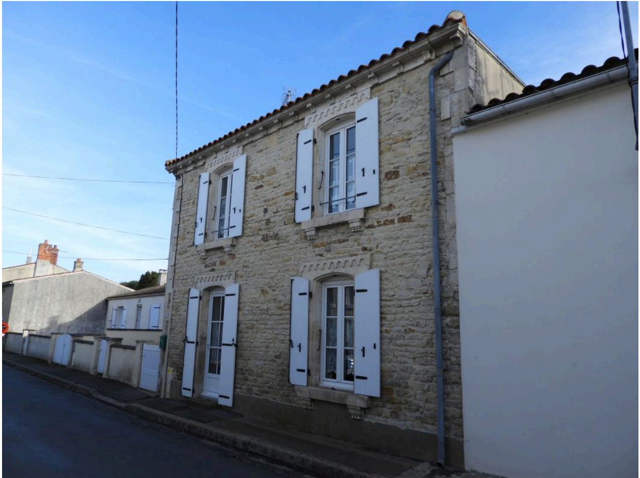
La maison vue depuis le nord-ouest.
