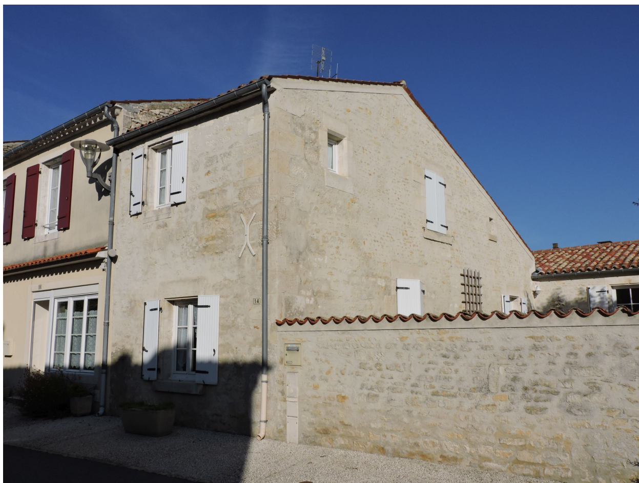
Vue depuis le sud-est.
