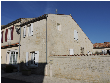
Vue depuis le sud-est.
