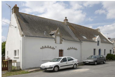
Vue d'ensemble depuis le sud-est. Phot. Denis Pillet IVR52_20104401049NUCA
