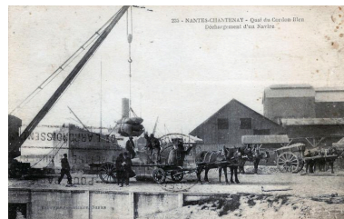
Quai du Cordon Bleu, déchargement d'un navire sur un tombereau : la traction hippomobile perdue jusqu'au milieu du 20e siècle, carte postale, sans date. Phot. Denis (reproduction) Pillet IVR52_20134400850NUCA
