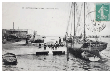
Quai du Cordon Bleu, début du XXe siècle. Phot. Denis Pillet IVR52_20124400254NUCA
