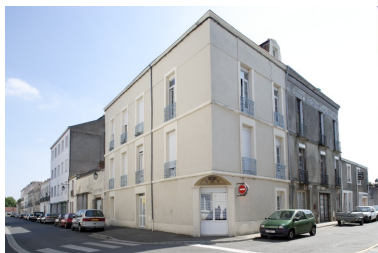
Vue d'ensemble depuis la rue Pierre-Jubau, 2005. Phot. Denis Pillet
