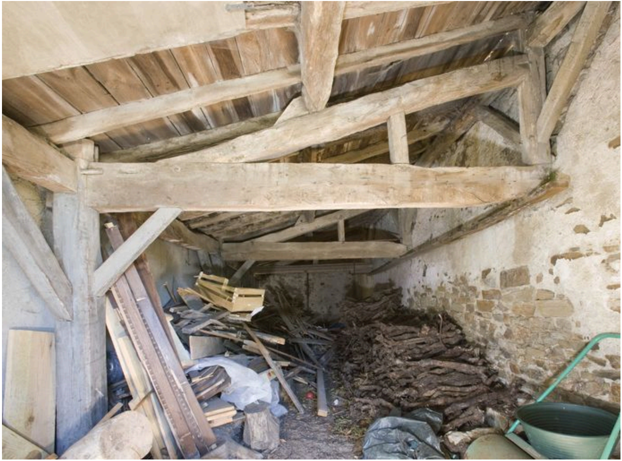
L'ancien préau muré : détail de la charpente.
