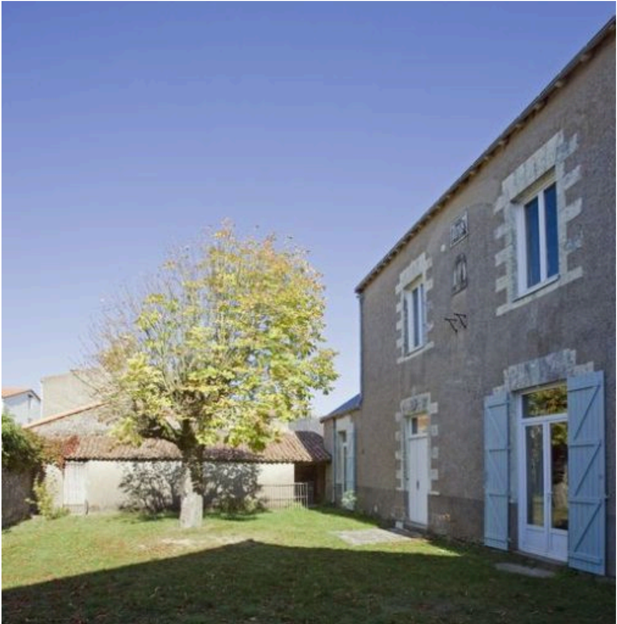
Façade ouest : la petite cour avec son tilleul, au fond, le préau muré.
