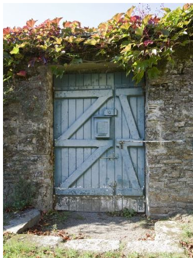
Ancien portail d'entrée vu de la cour. Phot. Yves Guillotin IVR52_20104402847NUCA
