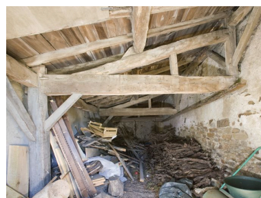
L'ancien préau muré : détail de la charpente. Phot. Yves Guillotin IVR52_20104402850NUCA
