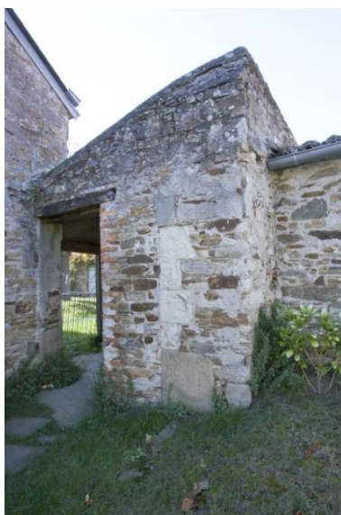
Porte de l'ancien préau permettant le passage du jardin à la petite cour. Phot. Yves Guillotin IVR52_20104402845NUCA
