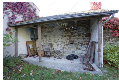
Anciennes latrines devenues préau. Phot. Yves Guillotin IVR52_20104402846NUCA
