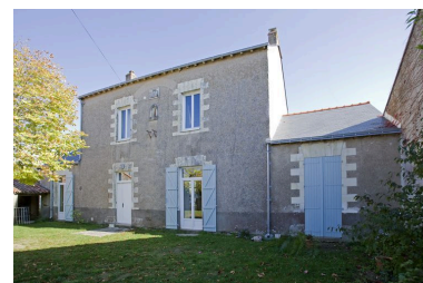
Façade ouest précédée de la petite cour d'origine. Phot. Yves Guillotin IVR52_20104402848NUCA
