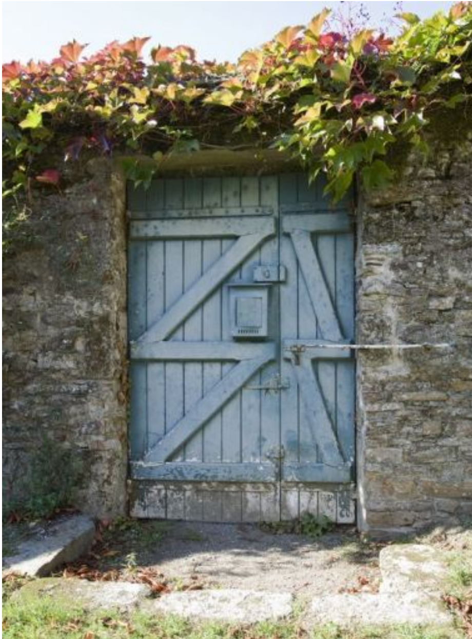
Ancien portail d'entrée vu de la cour.
