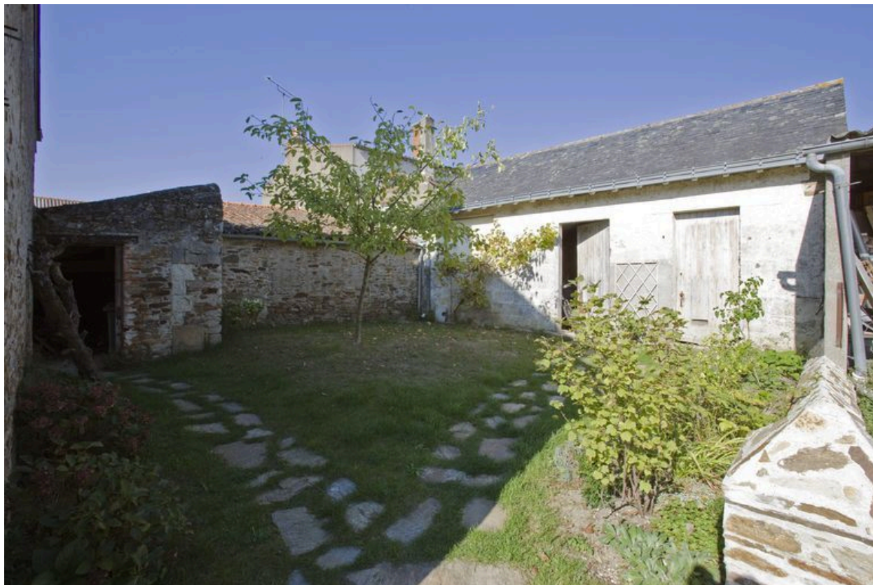
Jardin : la resserre datant des années 1930 et le pignon de l'ancien préau.
