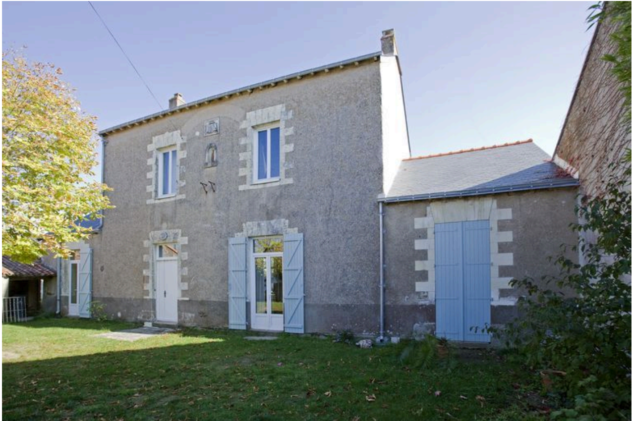
Façade ouest précédée de la petite cour d'origine.
