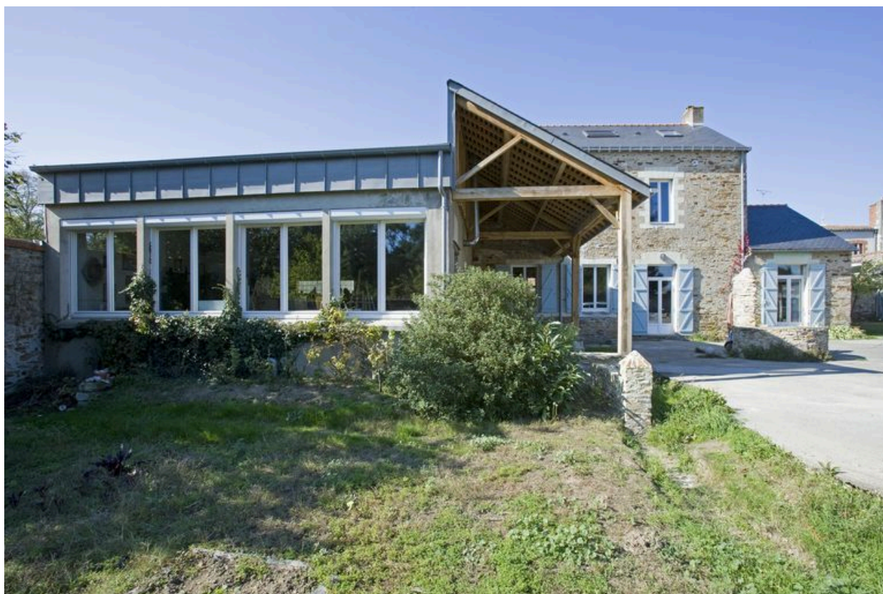
La classe construite en 1964 et son préau, adjoint vers 2008.
