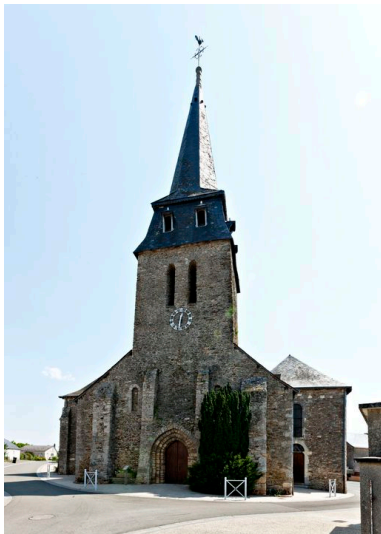
Vue d'ensemble depuis l'ouest. Phot. Yves Guillotin
