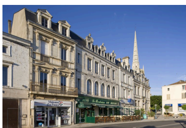
Ensemble de façades de la deuxième moitié du XIXe siècle, au sud de la place des Acacias (de gauche à droite : construction en 1878, 1862 et 1898).
