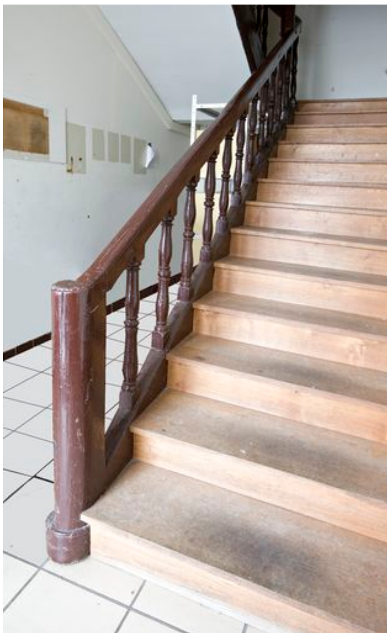
Escalier de la maison 65, rue du Port.
