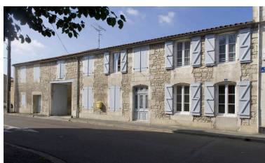
Façade sur rue de la maison 2-4, rue de la Clairaye, portant la date 1816 et appartenant alors à Jean Labbé. Phot. Patrice Giraud IVR52_20098500509NUCA
