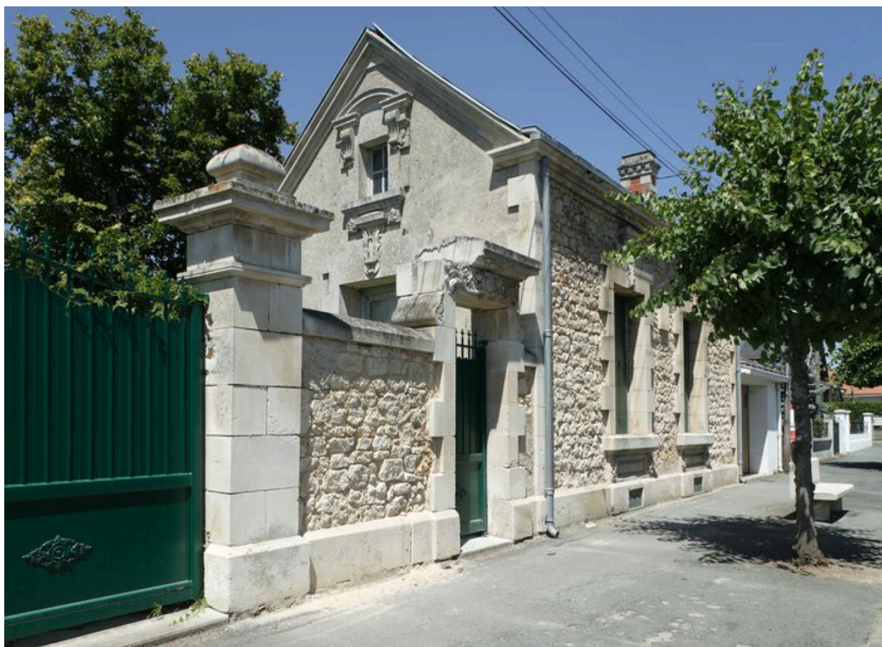
Maison 16, boulevard de l'Aumônerie (vers 1900).
