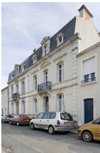
Maisons 10 et 12, rue de l'Hôtel- de-ville, reconstruites en 1892 par et pour l'entrepreneur René Prieur. Phot. Patrice Giraud IVR52_20108500449NUCA
