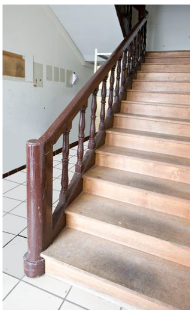
Escalier de la maison 65, rue du Port. Phot. Patrice Giraud IVR52_20118500241NUCA
