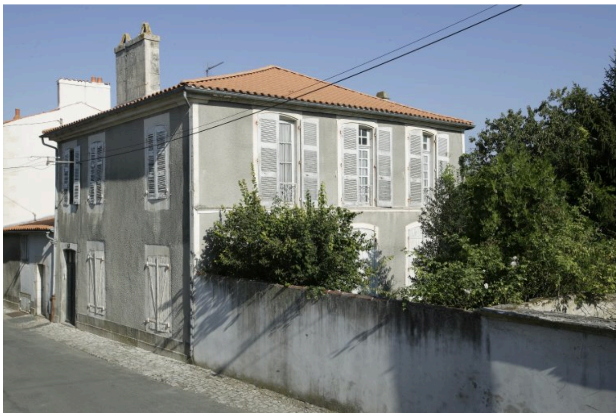
Maison appartenant au chapitre 4, rue du Grand-Carmel, reconstruite au XVIIIe siècle et reprise au XIXe.
