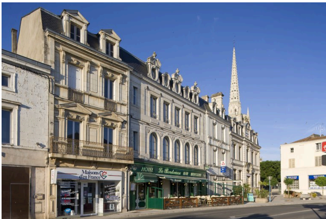
Ensemble de façades de la deuxième moitié du XIXe siècle, au sud de la place des Acacias (de gauche à droite : construction en 1878, 1862 et 1898).
