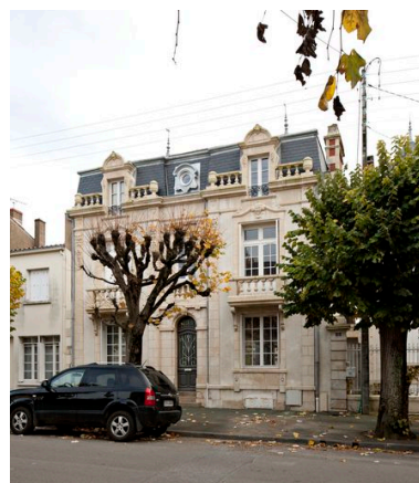
Maison 40, avenue Emile- Beaussire, datant du dernier quart du XIXe siècle. Phot. Patrice Giraud IVR52_20118500824NUCA
