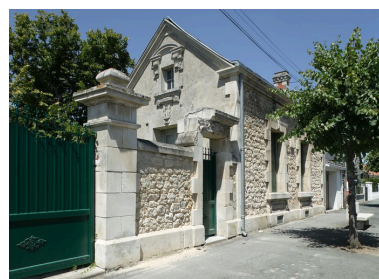
Maison 16, boulevard de l'Aumônerie (vers 1900). Phot. Patrice Giraud IVR52_20088501035NUCA
