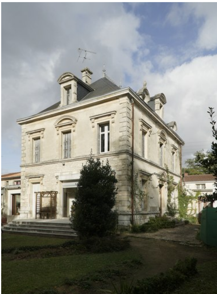
Maison 17, rue Neuve-des-Capucins : vue prise du jardin.
