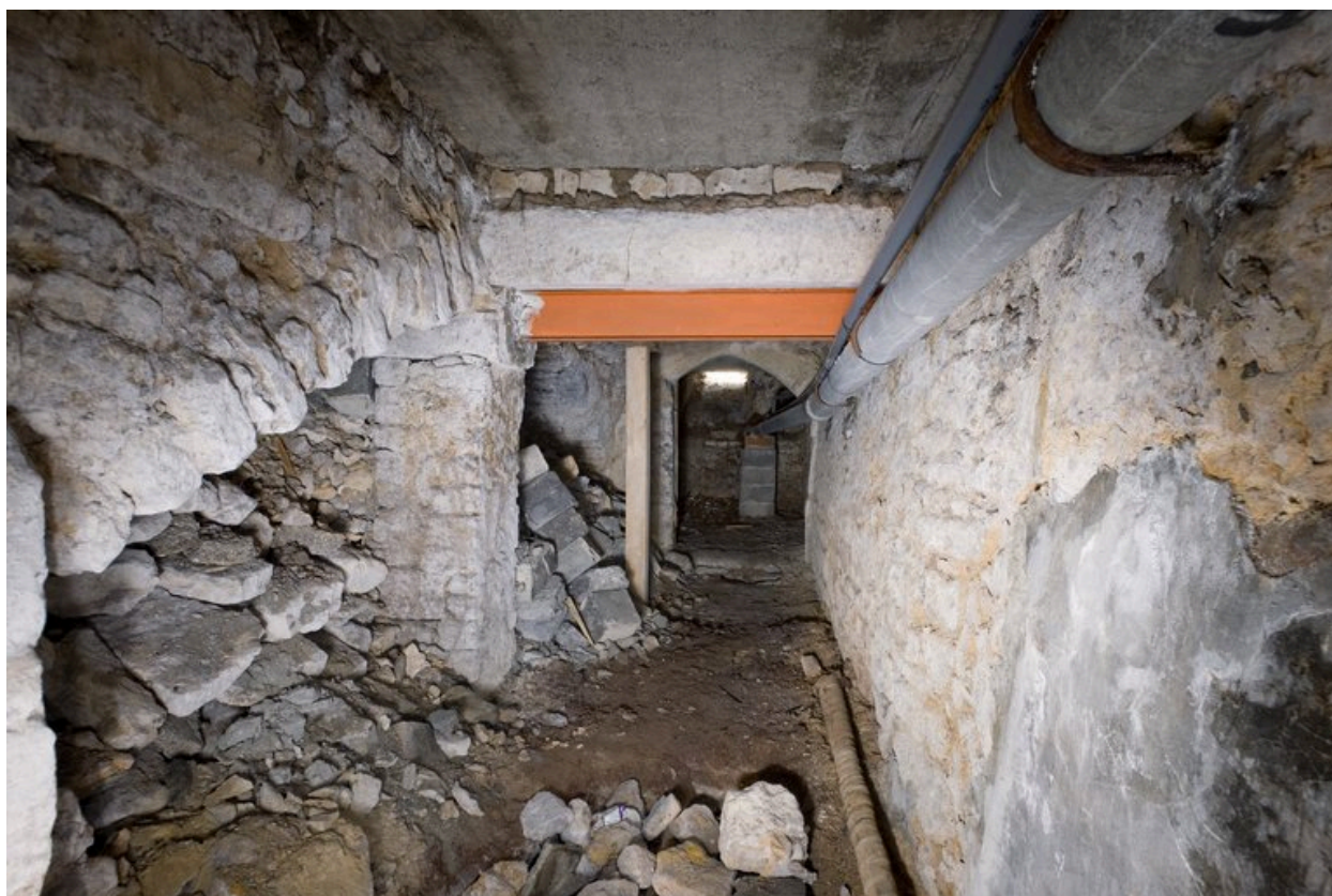
Sous-sol du XVe siècle, 15, place des Acacias : vue prise de l'est.
