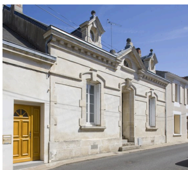
Façade de la maison 15, rue Emile- Zola (2e moitié du XIXe siècle). Phot. Patrice Giraud IVR52_20108500153NUCA
