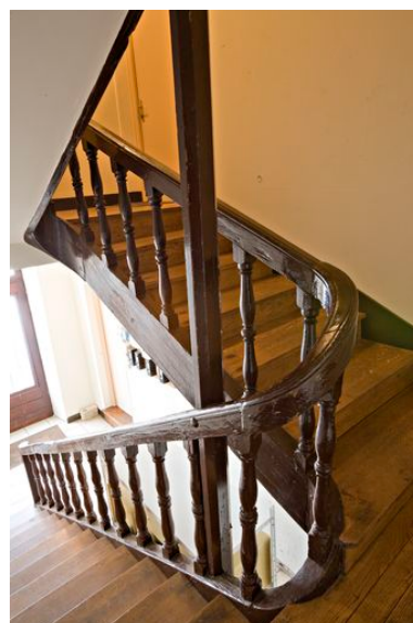
Escalier de la maison 65, rue du Port. Phot. Patrice Giraud IVR52_20118500242NUCA
