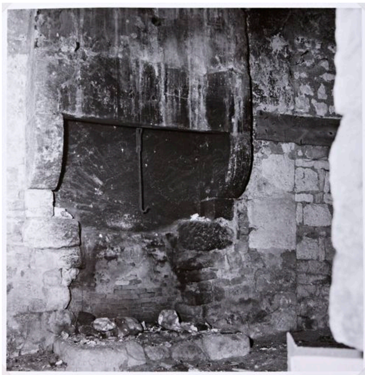
Maison ancienne 69-71, rue Victor-Hugo, détruite en 1971 : cheminée. Photo prise en 1970, lors du pré-inventaire.
