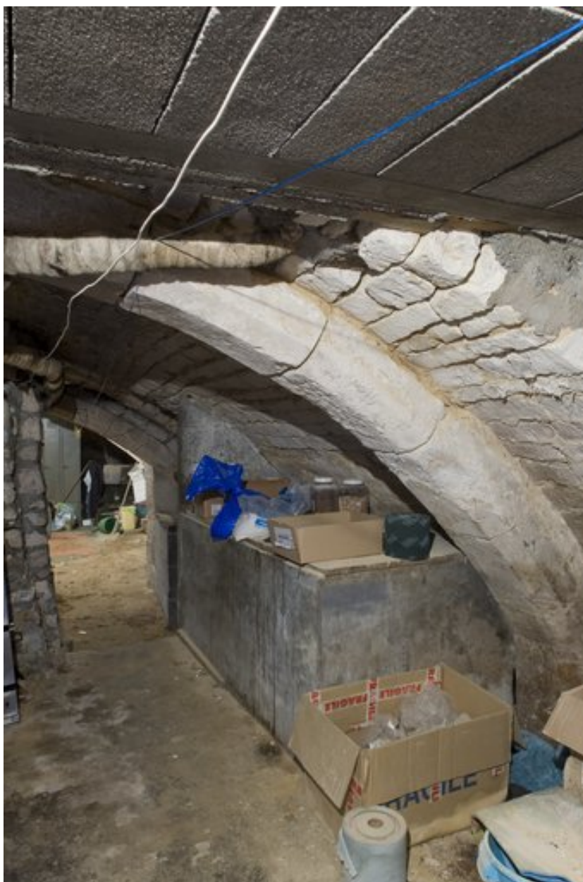
Sous-sol du XVe siècle de la maison 4, place du Commerce : vue prise du sud.
