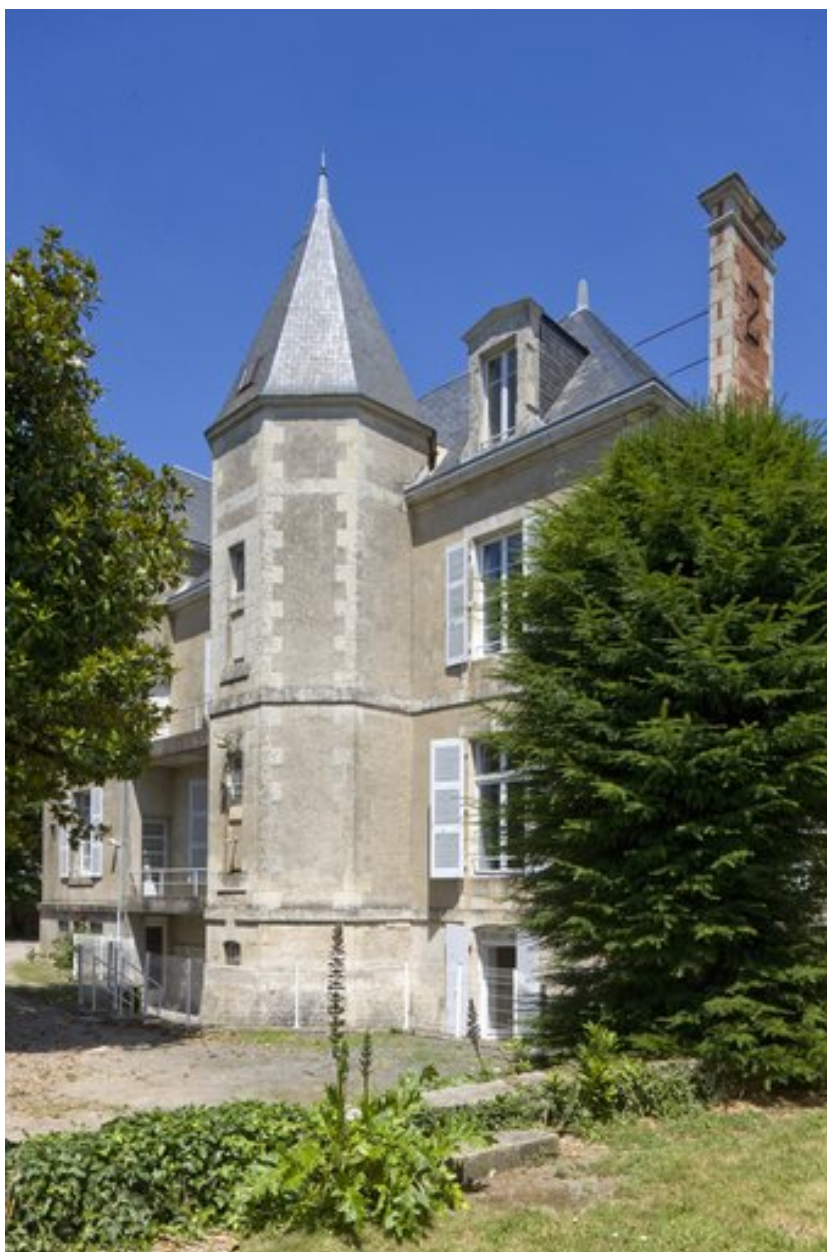
Maison 16, place Leclerc, construite en 1878 pour Eugène Sablereau (vue prise du sud).
