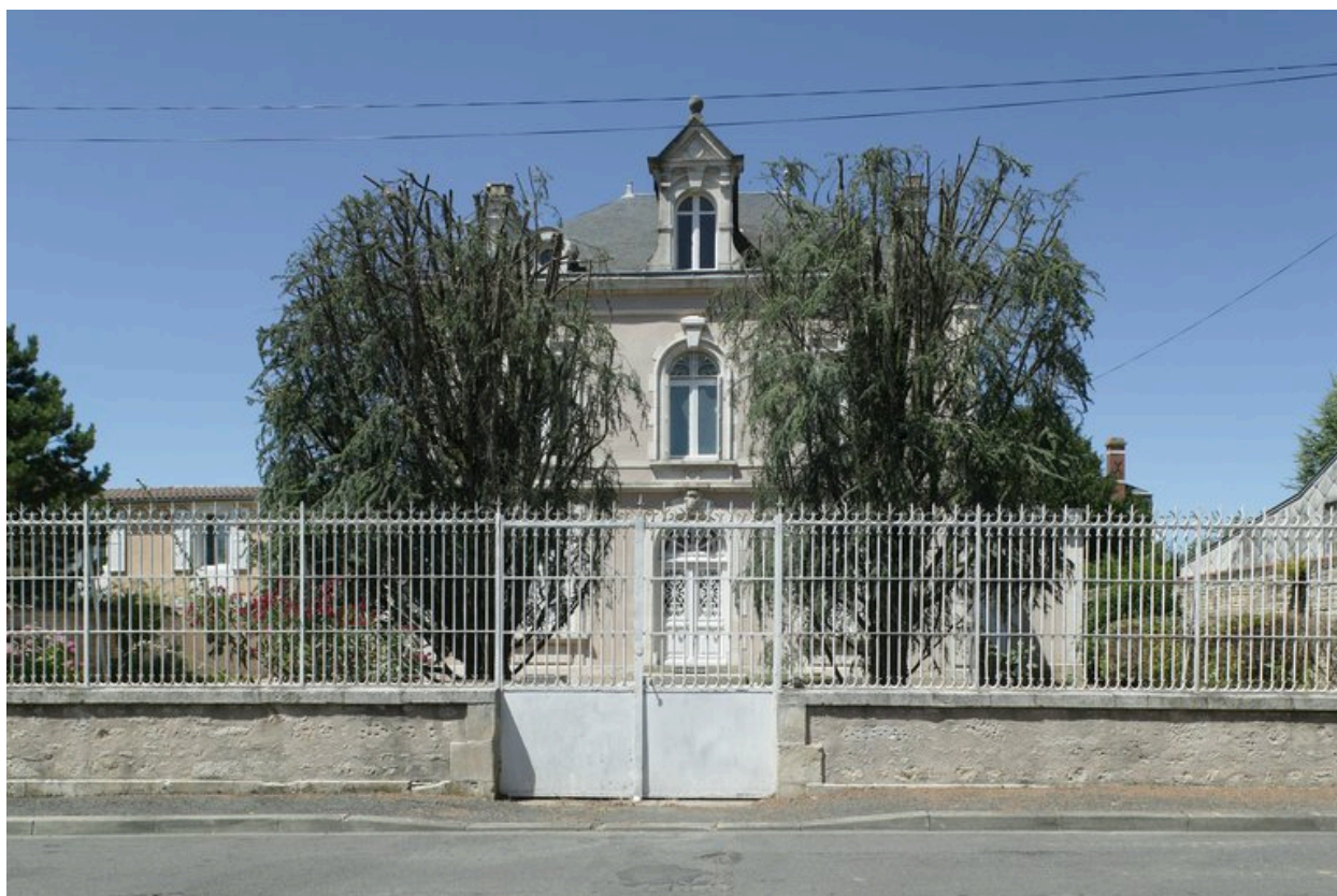
Maison 4, rue Henry-Renaud, construite en 1888 pour Mme veuve Grignon, née de Hillerin.
