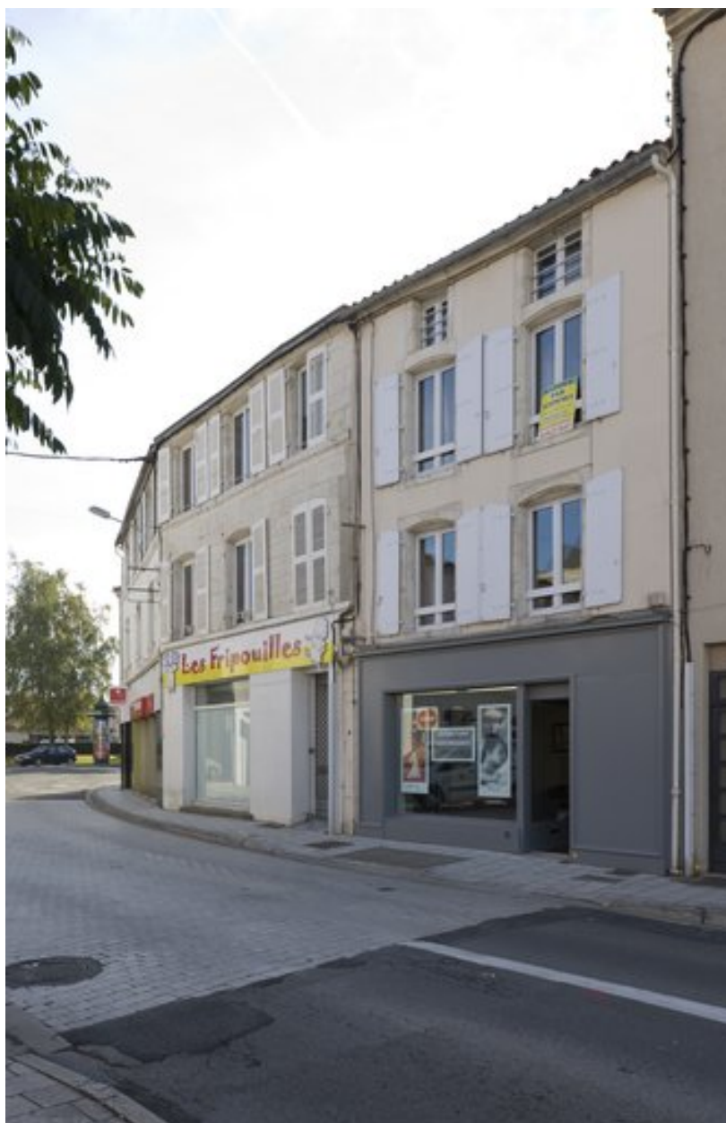
Façades des maisons 28 et 26, place des Acacias.
