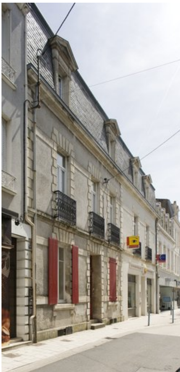
Façades des maisons 34-36, rue Georges-Clemenceau (2e moitié du XIXe siècle).
