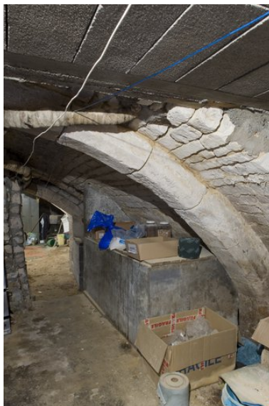
Sous-sol du XVe siècle de la maison 4, place du Commerce : vue prise du sud. Phot. Patrice Giraud IVR52_20108500174NUCA
