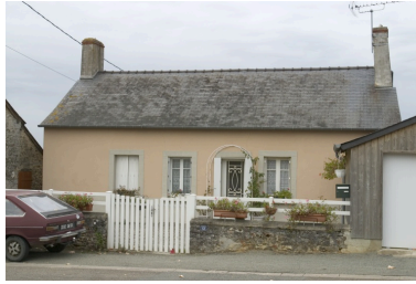
Vue depuis la route. Phot. François Lasa IVR52_20045303306NUCA
