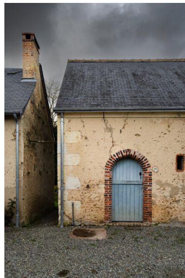
Grange-étable : porte et chaîne d'angle. Phot. Thierry Seldubuisson IVR52_20247200485NUCA
