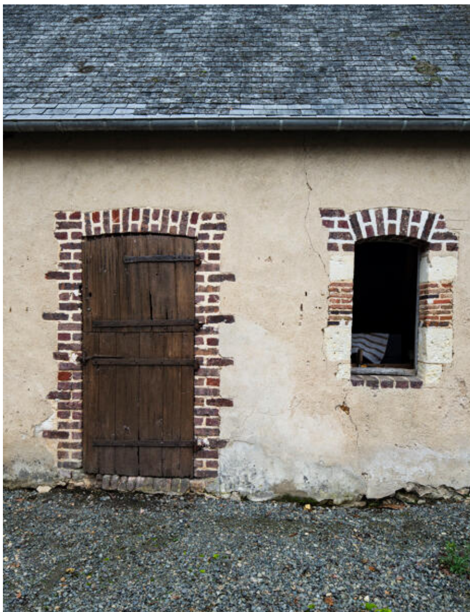
Logement : porte et fenêtre.
