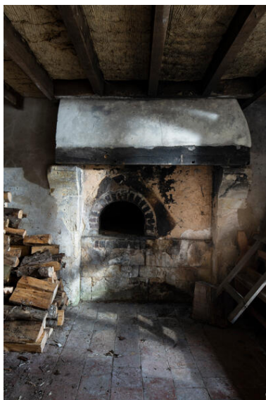
Logement : cheminée. Phot. Thierry Seldubuisson IVR52_20247200488NUCA
