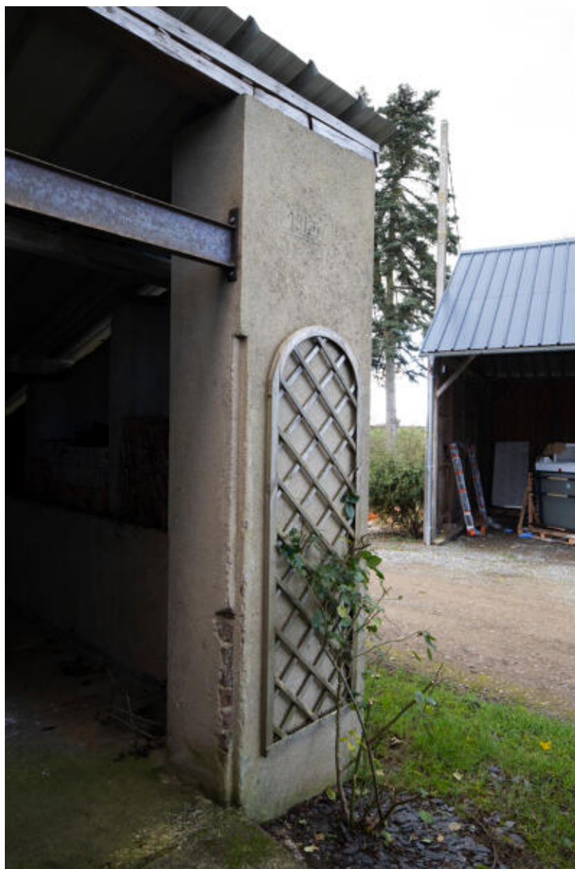
Hangar : pilier avec date portée.
