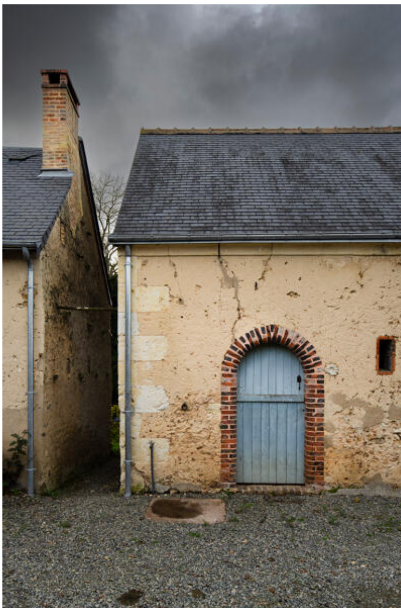
Grange-étable : porte et chaîne d'angle.
