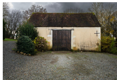
Grange-étable. Phot. Thierry Seldubuisson IVR52_20247200483NUCA
