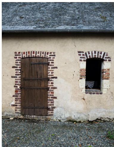
Logement : porte et fenêtre. Phot. Thierry Seldubuisson IVR52_20247200487NUCA
