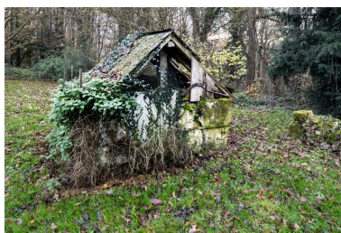
Puits. Phot. Thierry Seldubuisson IVR52_20247200490NUCA
