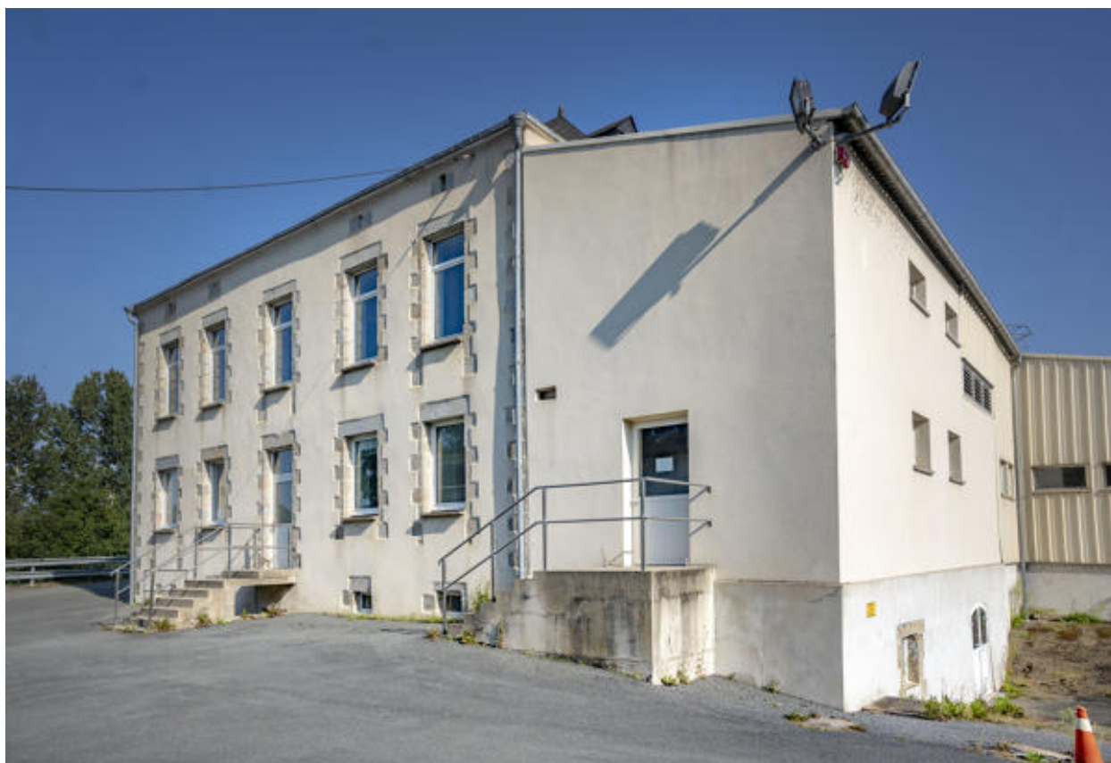
La façade postérieure de la maison.
