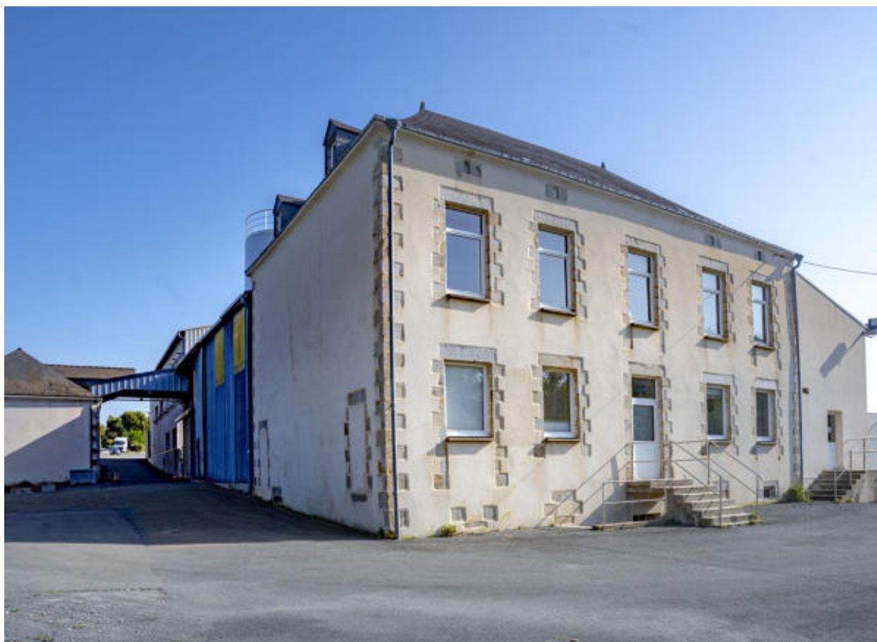
La façade postérieure de la maison.
