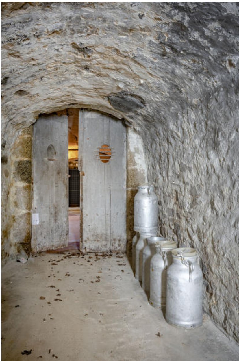
La porte des caves sous la maison.
