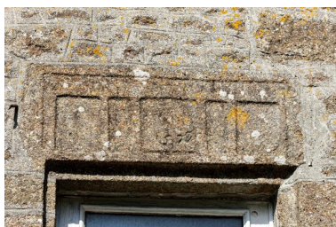
Hameau de l'Aubergement, lindeau de porte du logis principale, portant la date 1579. Phot. Yves Guillotin IVR52_20215301499NUCA
