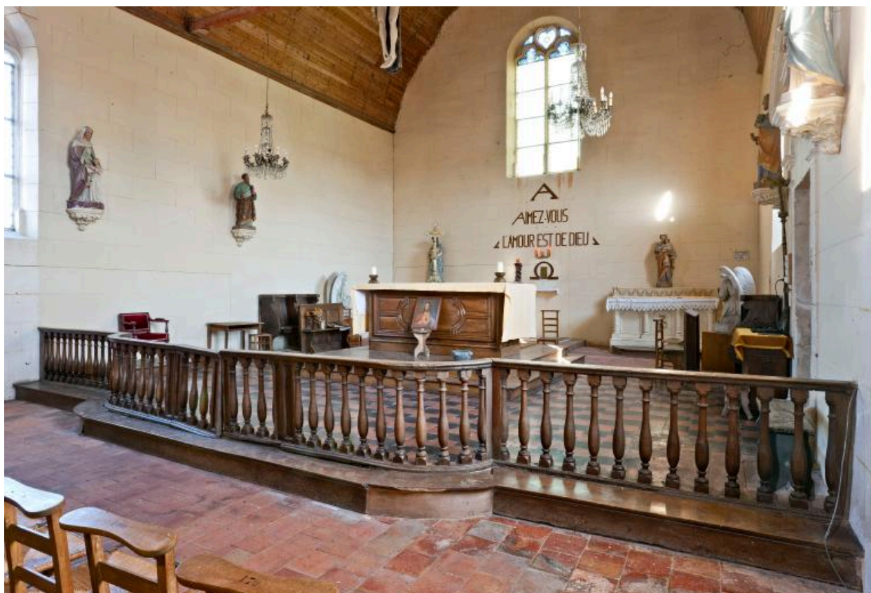
Clôture de chœur : vue générale.
