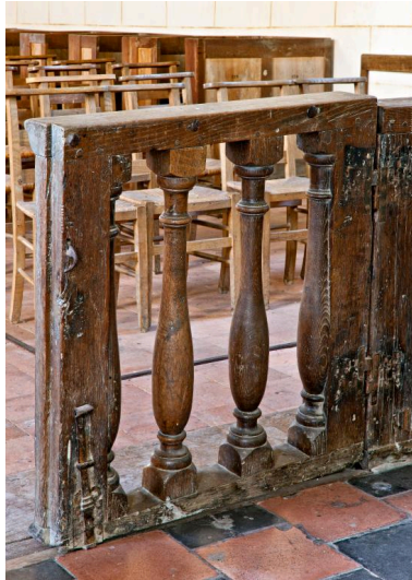
Clôture de chœur, détail. Phot. Jean-Baptiste Darrasse IVR52_20117201535NUCA
