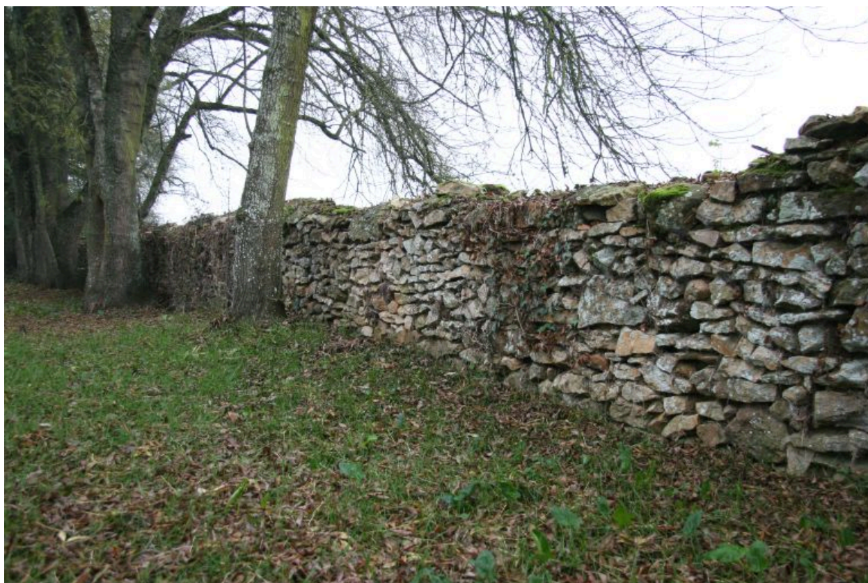
Mur de clôture en pierre sèche.
