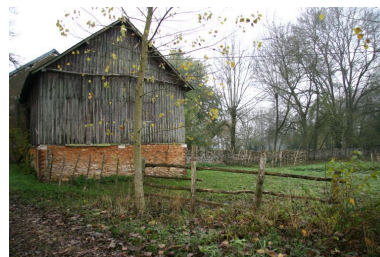
Pignon du hangar : base en moellon enduit et chaînages de brique. Mur de clôture en pierre sèche. Phot. Jean-Baptiste Darrasse IVR52_20047204250XA
