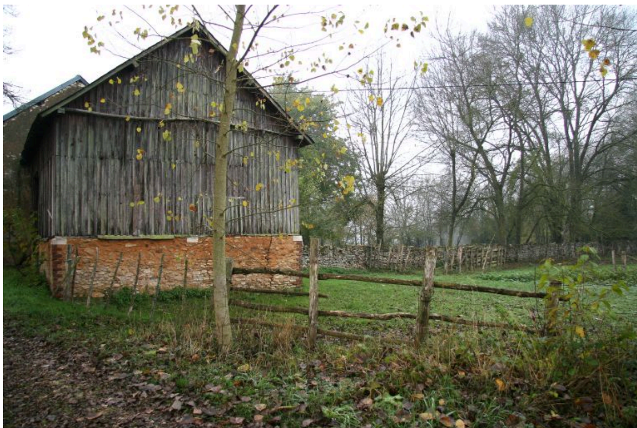
Pignon du hangar : base en moellon enduit et chaînages de brique. Mur de clôture en pierre sèche.
