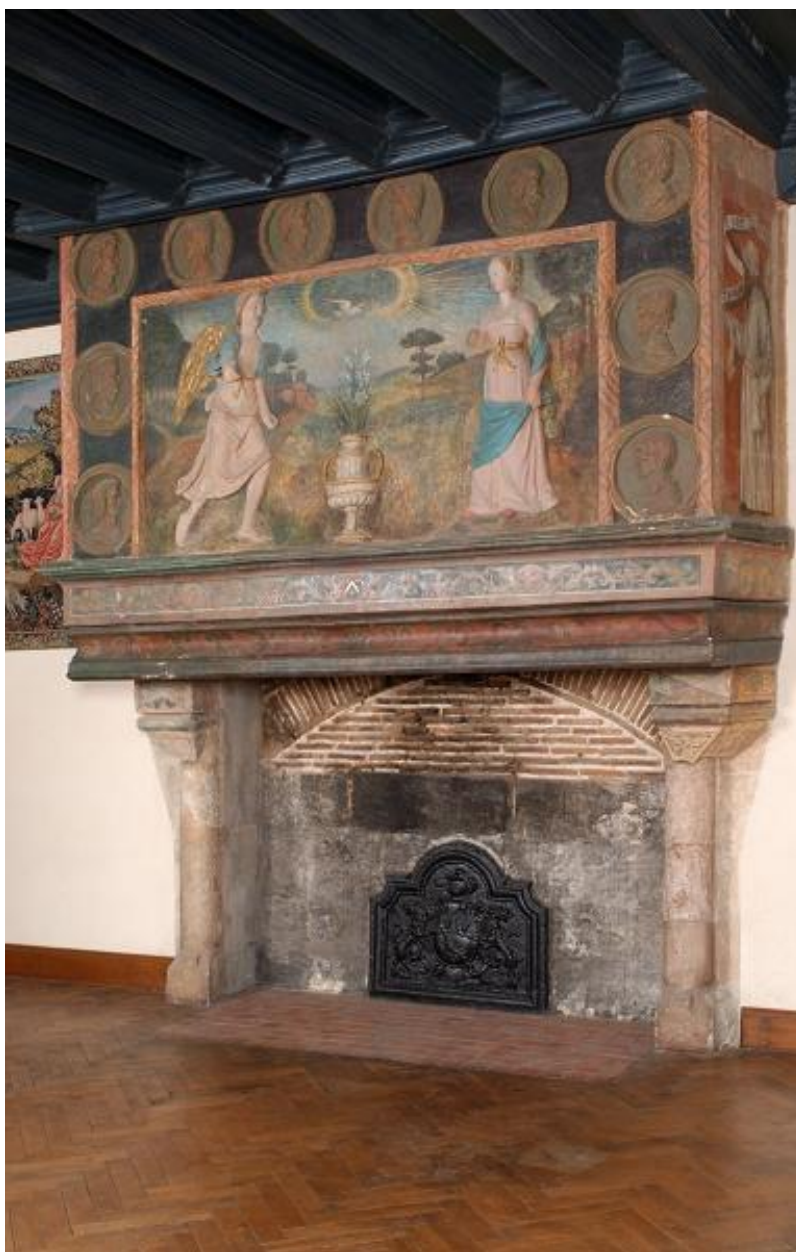
Rez-de-chaussée, pièce principale : vue d'ensemble de la cheminée.
