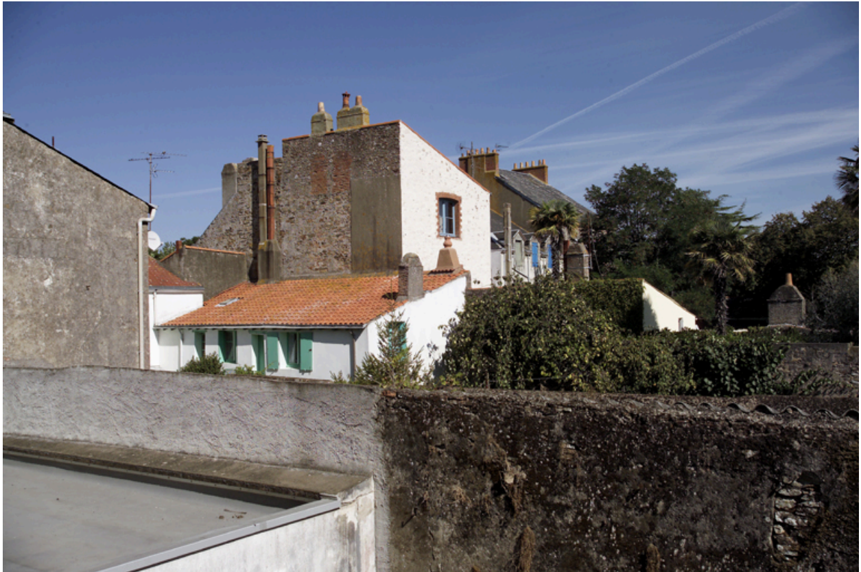
En arrière-plan de gauche à droite, le pignon du corps principal, la façade postérieure et le pignon du corps secondaire vus depuis le jardin de la maison n° 24 quai Eole.
