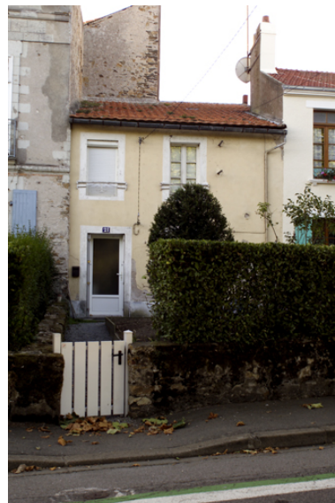
A droite du corps principal en arrière-plan, le pignon nord du corps secondaire partiellement masqué par la maison n° 21 quai Eole. Phot. Denis Pillet IVR52_20034401334NUCA
