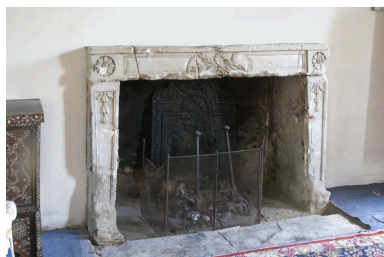
La pièce située au rez-de-chaussée à l'ouest, détail de la cheminée. Phot. François Lasa IVR52_20074401110NUCA
