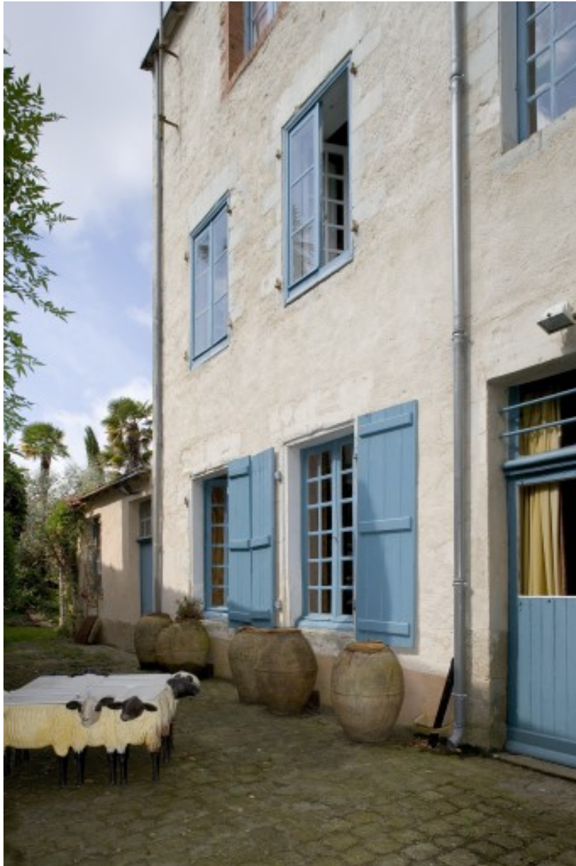
Le corps secondaire, à droite, la porte d'accès à l'escalier.
