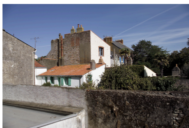
En arrière-plan de gauche à droite, le pignon du corps principal, la façade postérieure et le pignon du corps secondaire vus depuis le jardin de la maison n° 24 quai Eole. Phot. Denis Pillet IVR52_20034401100NUCA
