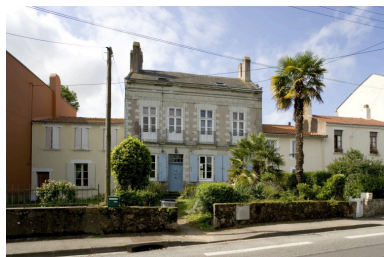
La façade sur le quai. Phot. François Lasa IVR52_20074401106NUCA
