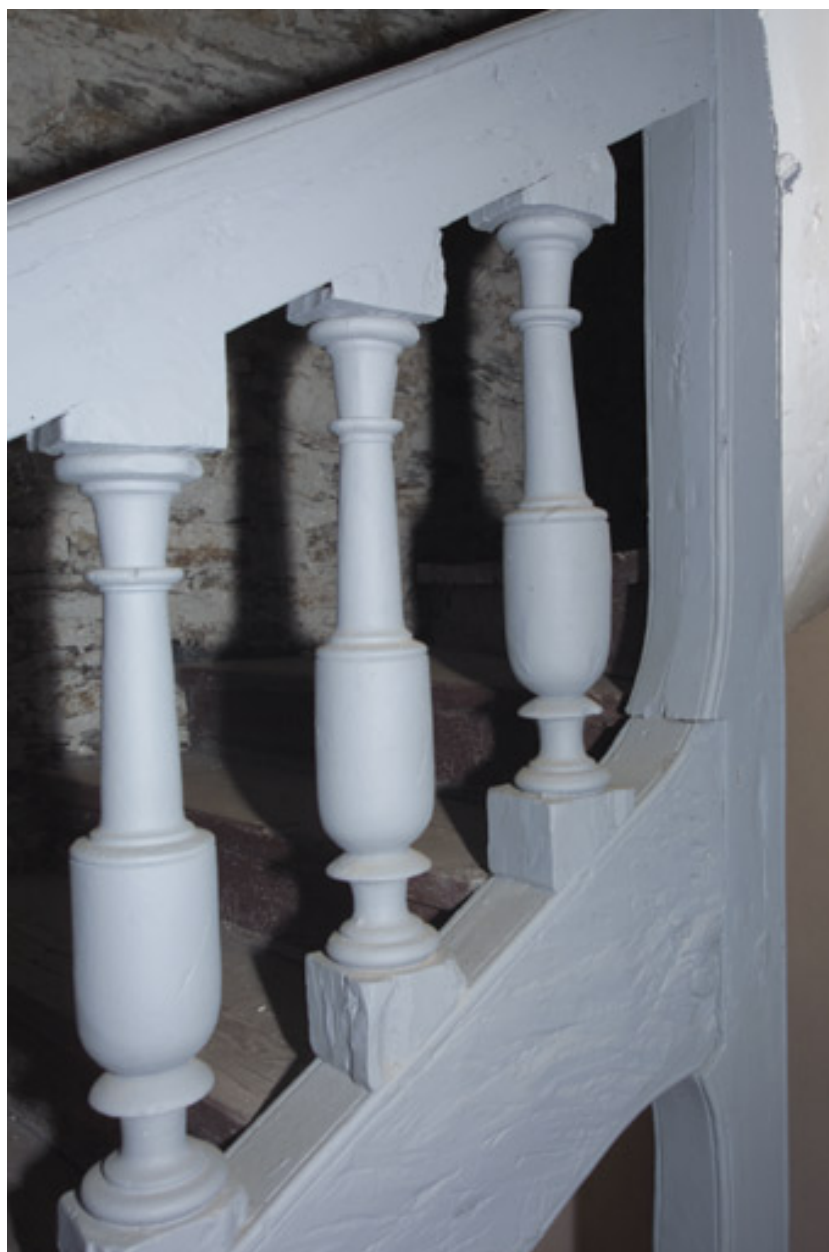
L'escalier, détail des balustres.
