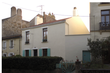
En arrière-plan, de gauche à droite, le pignon ouest du corps principal, les façades postérieures du corps d'escalier et du corps secondaire en appentis. Phot. Denis Pillet IVR52_20034401335NUCA
