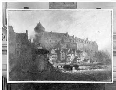
Le vieux château et le palais de Justice avec, au premier plan, les Trois moulins : vue d'ensemble depuis la rive gauche. Repro. François Lasa IVR52_19815300335X
