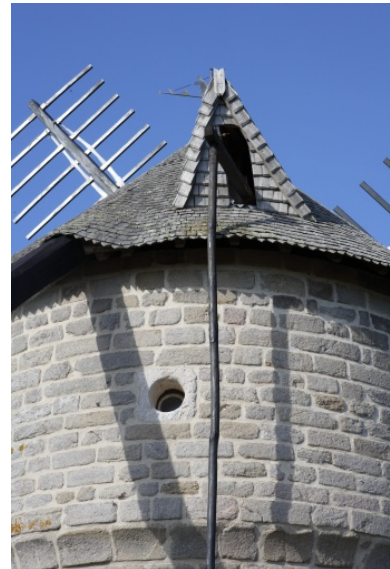
Cage et coiffe, côté sud-est. Houteau de sortie du levier de frein, et perche du frein. Phot. Denis Pillet IVR52_20074401510NUCA
