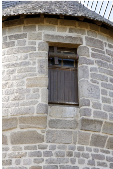
Cage, côté est. Détail de l'une des deux portes haute et du treuil. Phot. Denis Pillet IVR52_20074401509NUCA
