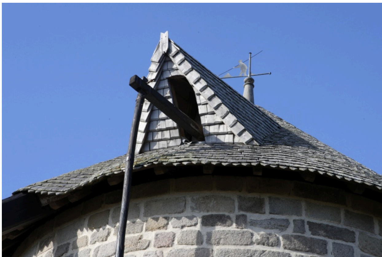
Coiffe ; détail du houteau de sortie du levier de frein et perche du frein.
