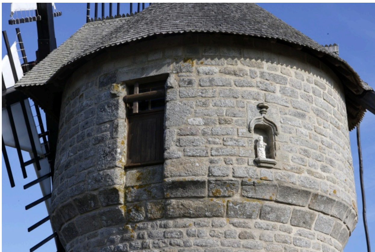
Détail de la cage, côté ouest.
