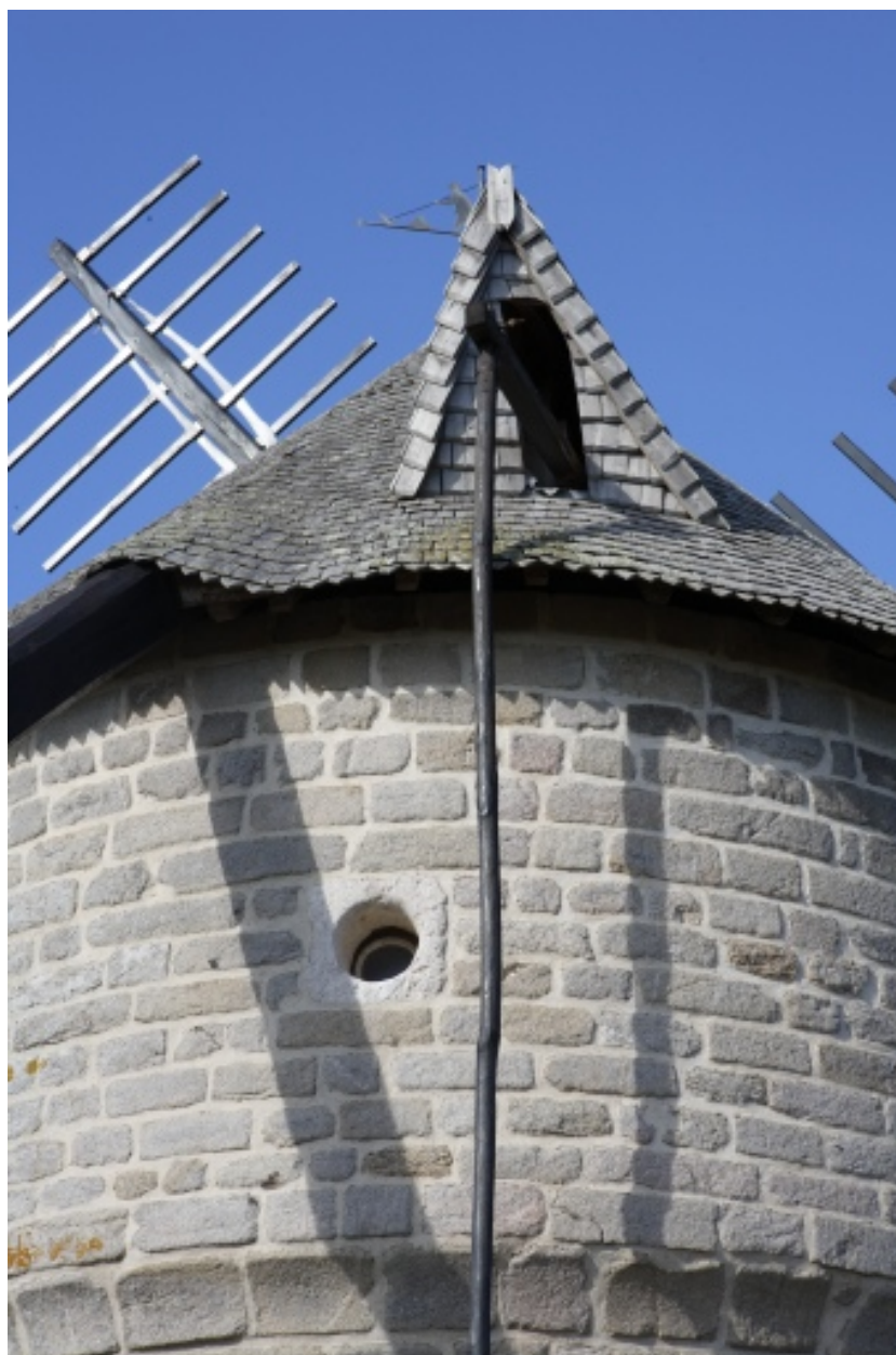
Cage et coiffe, côté sud-est. Houteau de sortie du levier de frein, et perche du frein.
