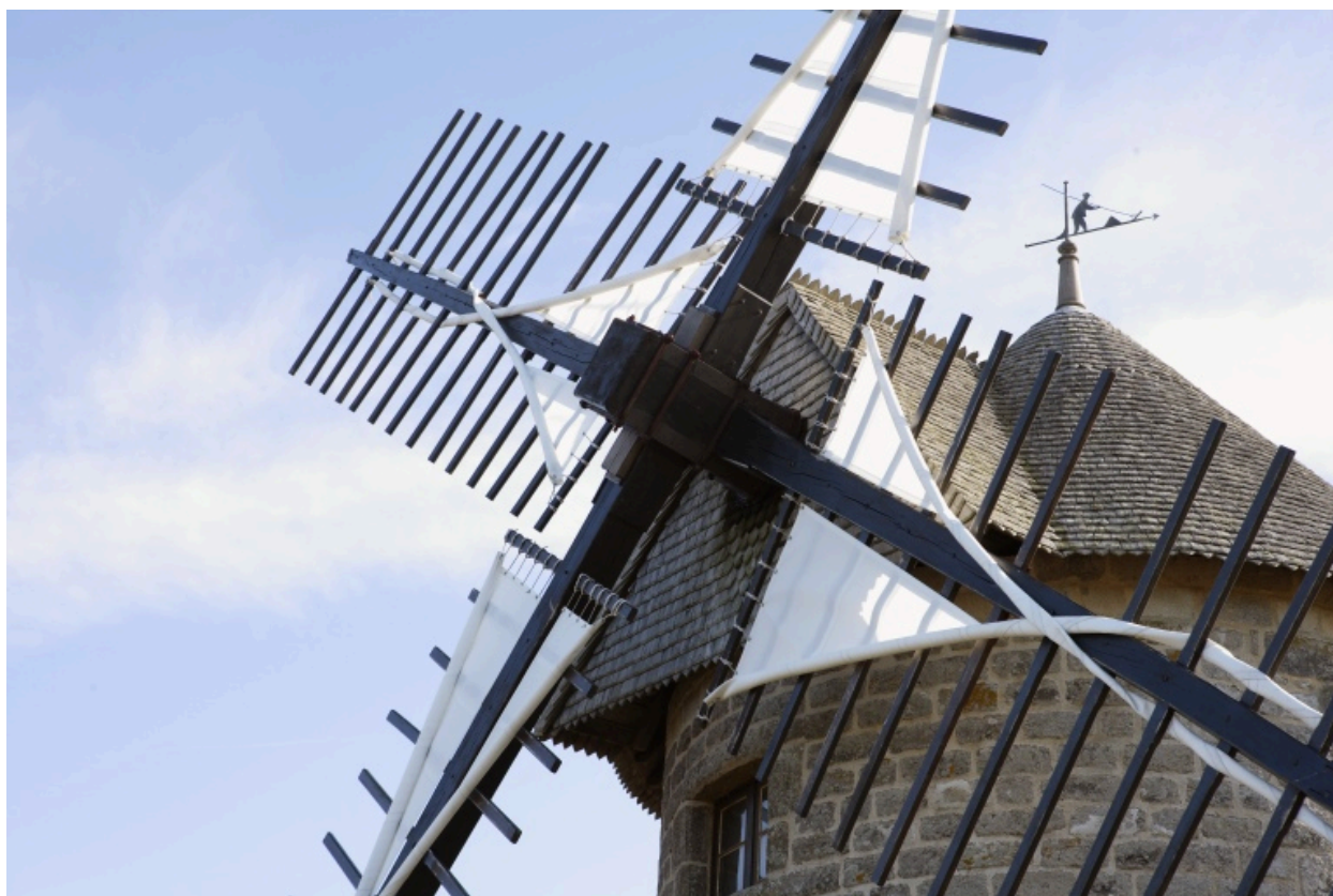
Détail des ailes : verges, verrons et voiles.
