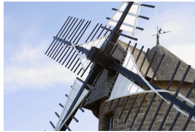
Détail des ailes : verges, verrens et voiles. Phot. Denis Pillet IVR52_20074401503NUCA
