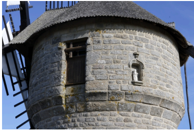
Détail de la cage, côté ouest. Phot. Denis Pillet IVR52_20074401504NUCA
