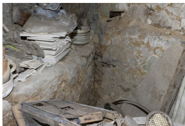
Vue prise du sous-sol de la maison 7, rue des Chanoines, montrant le parement extérieur de la glacière.
