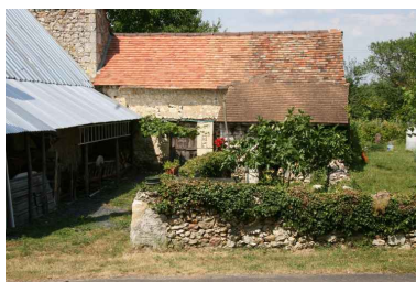
Maison 3 : toits à porcs. Phot. Jean-Baptiste Darrasse IVR52_20067206105NUCA
