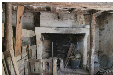
Maison 1 : chambre à feu. Phot. Jean-Baptiste Darrasse IVR52_20067206077NUCA
