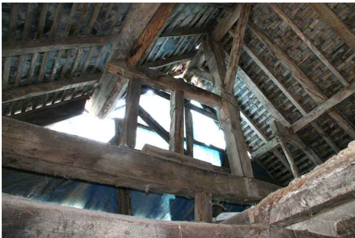
Maison 1 : la charpente.
