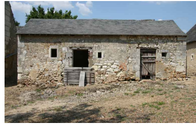
Maison 6, dépendances ajoutées. Phot. Jean-Baptiste Darrasse IVR52_20067206101NUCA
