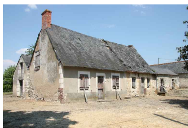
Maison 4 : façade antérieure sur le chemin. Phot. Jean-Baptiste Darrasse IVR52_20067206092NUCA
