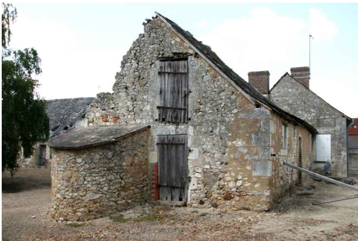
Maison 5, dépendances : pignon avec four.
