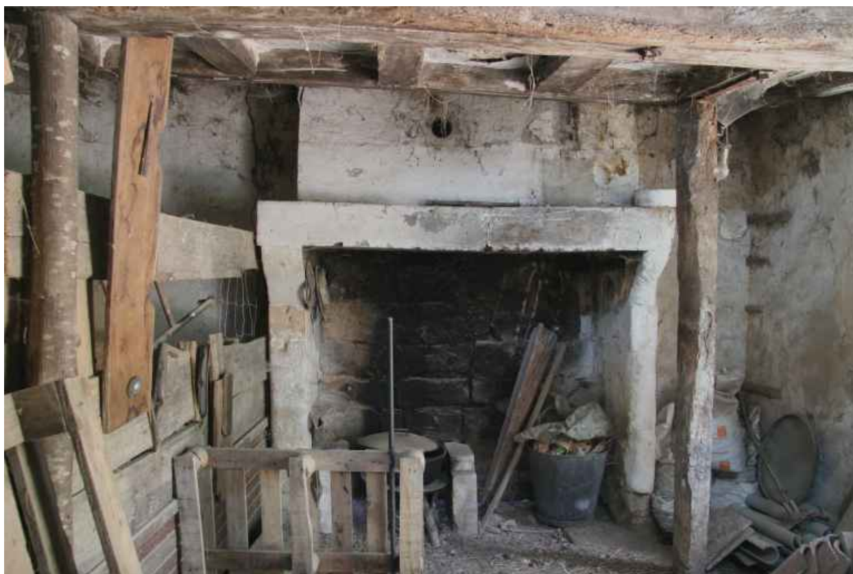
Maison 1 : chambre à feu.
