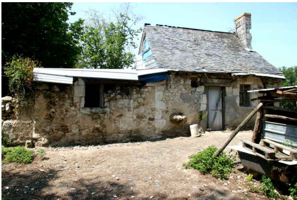
maison 1 : façade antérieure.
