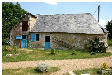
Maison 3 : façade antérieure. Phot. Jean-Baptiste Darrasse IVR52_20067206088NUCA
