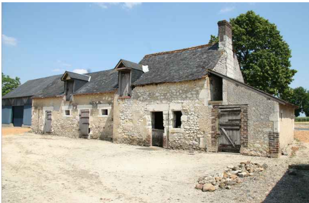
Maison 6 : vue d'ensemble.
