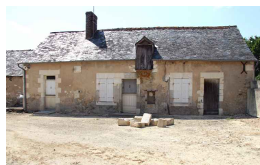
Maison 5 : façade antérieure sur cour. Phot. Jean-Baptiste Darrasse IVR52_20067206095NUCA
