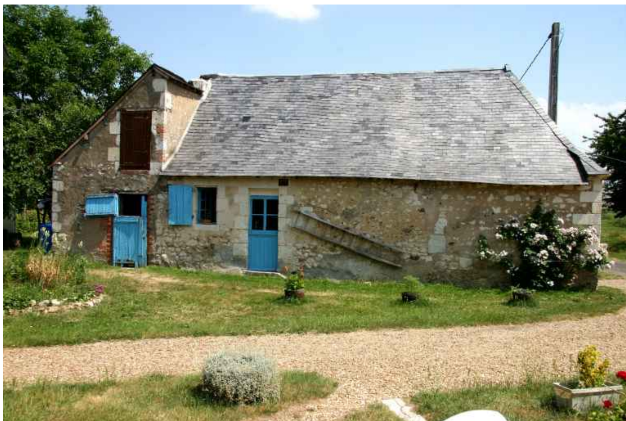
Maison 3 : façade antérieure.
