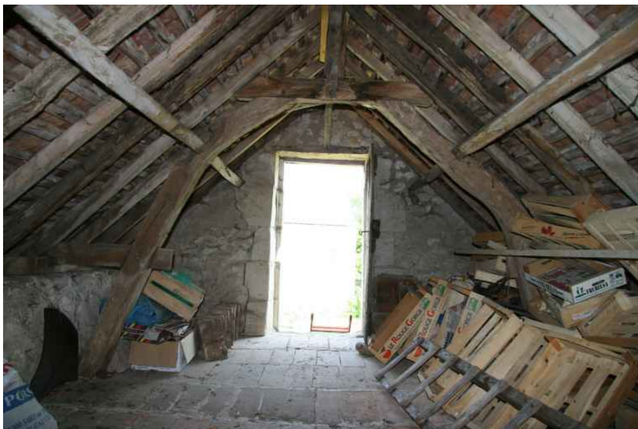
Maison 4, dépendances : charpente de comble à surcroît.
