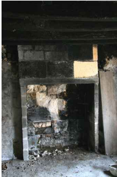
Maison 6 : la cheminée. Phot. Jean-Baptiste Darrasse IVR52_20067206099NUCA
