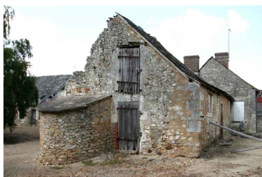
Maison 5, dépendances : pignon avec four. Phot. Jean-Baptiste Darrasse IVR52_20067206100NUCA
