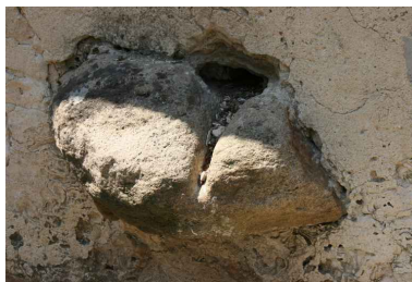
Maison 1 : écoulement de l'évier. Phot. Jean-Baptiste Darrasse IVR52_20067206076NUCA
