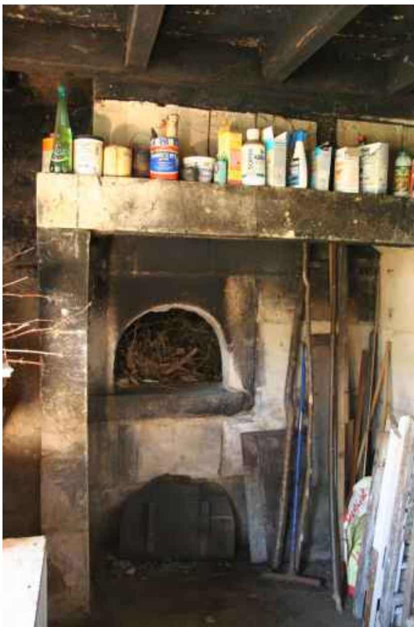
Maison 2, la boulangerie : la cheminée.
