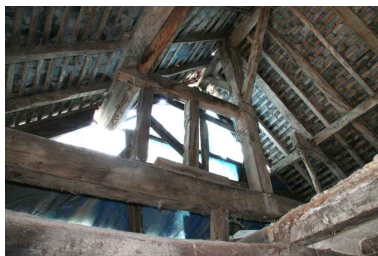
Maison 1 : la charpente. Phot. Jean-Baptiste Darrasse IVR52_20067206078NUCA
