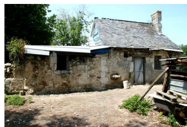
maison 1 : façade antérieure. Phot. Jean-Baptiste Darrasse IVR52_20067206072NUCA
