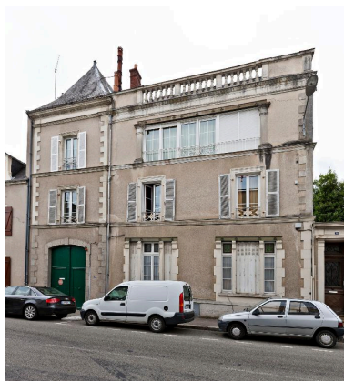
Elévation sur rue : vue d'ensemble. Phot. Yves Guillotin IVR52_20135300502NUCA
