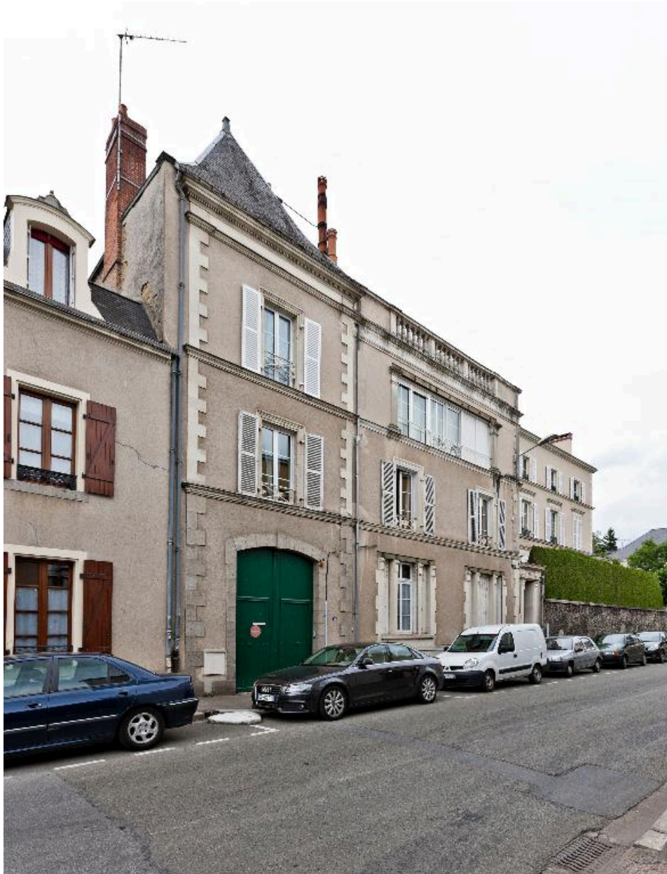
Elévation sur rue : vue d'ensemble.
