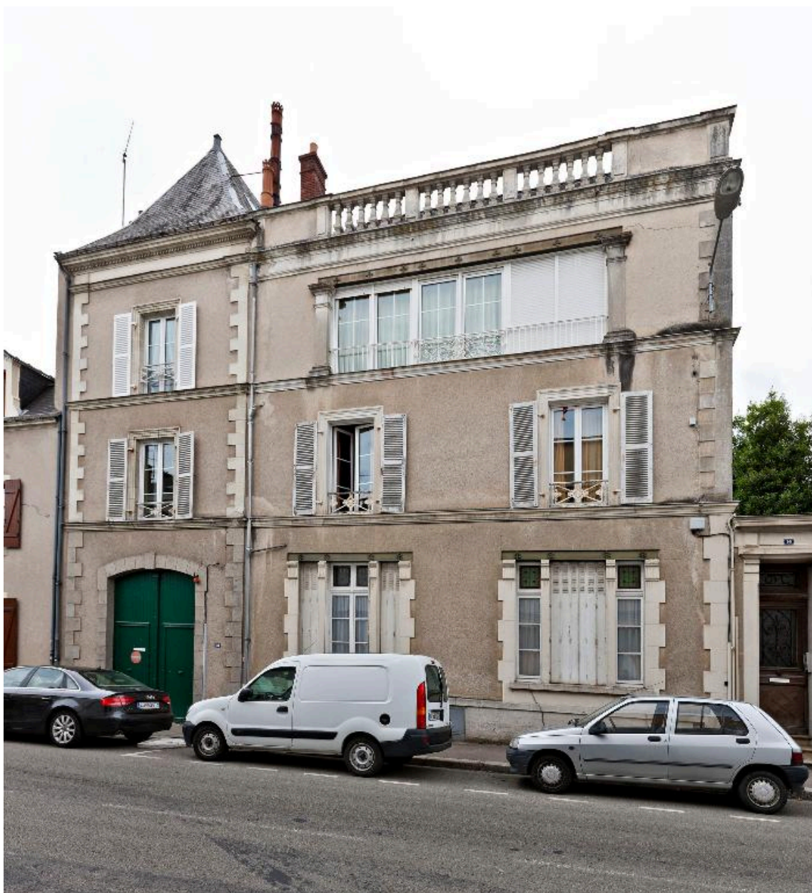
Elévation sur rue : vue d'ensemble.
