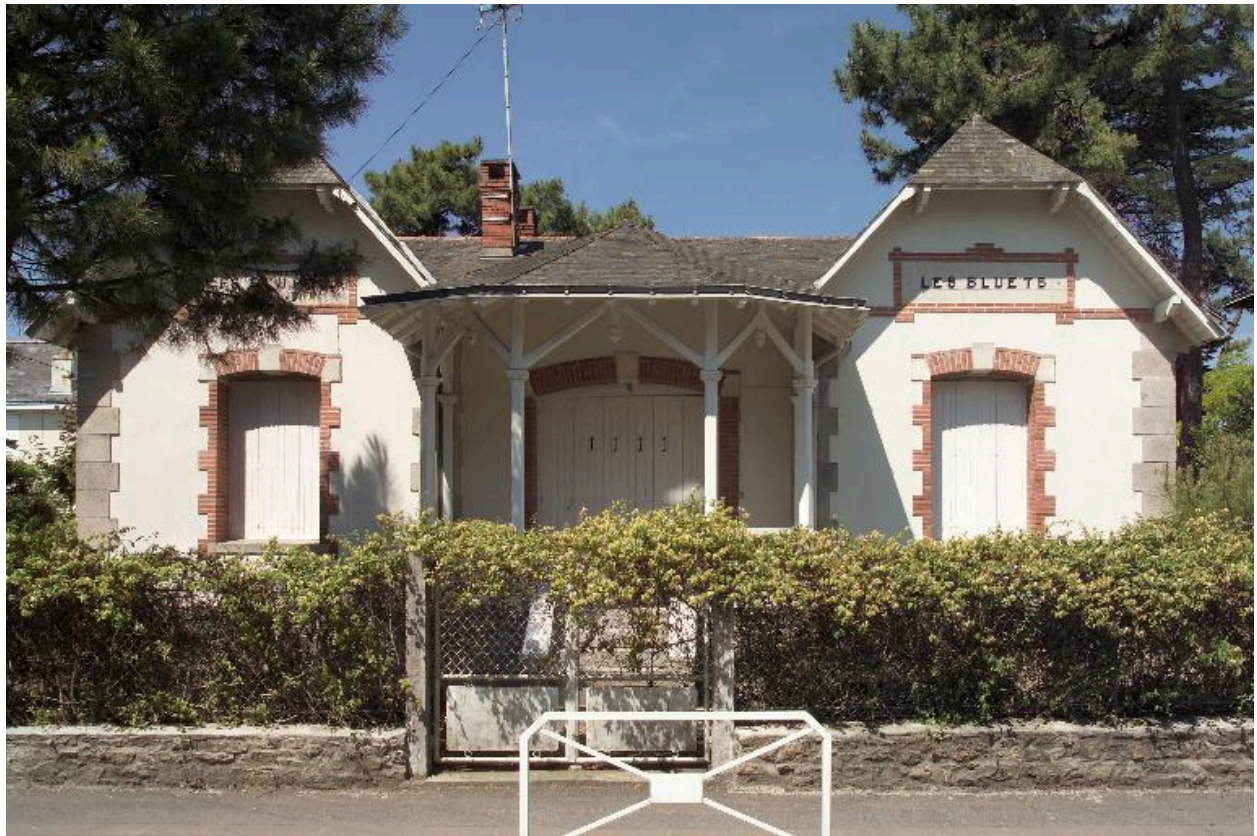
Vue d'ensemble de la villa Les Bleuets.
