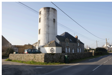
Vue d'ensemble du moulin et de la maison de meunier depuis le nord-ouest. Phot. Denis Pillet IVR52_20084400206NUCA
