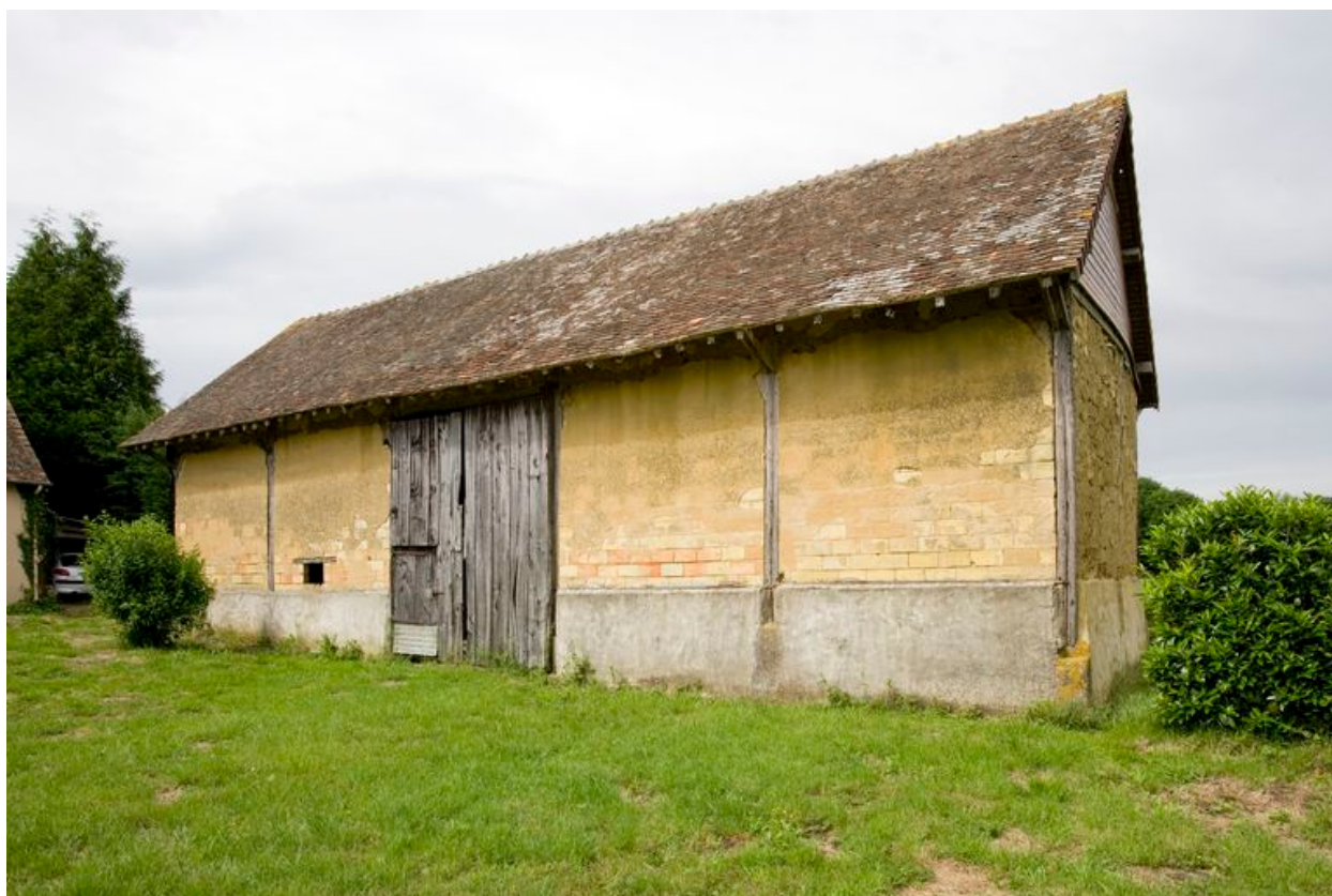
Grange, élévation sur cour.
