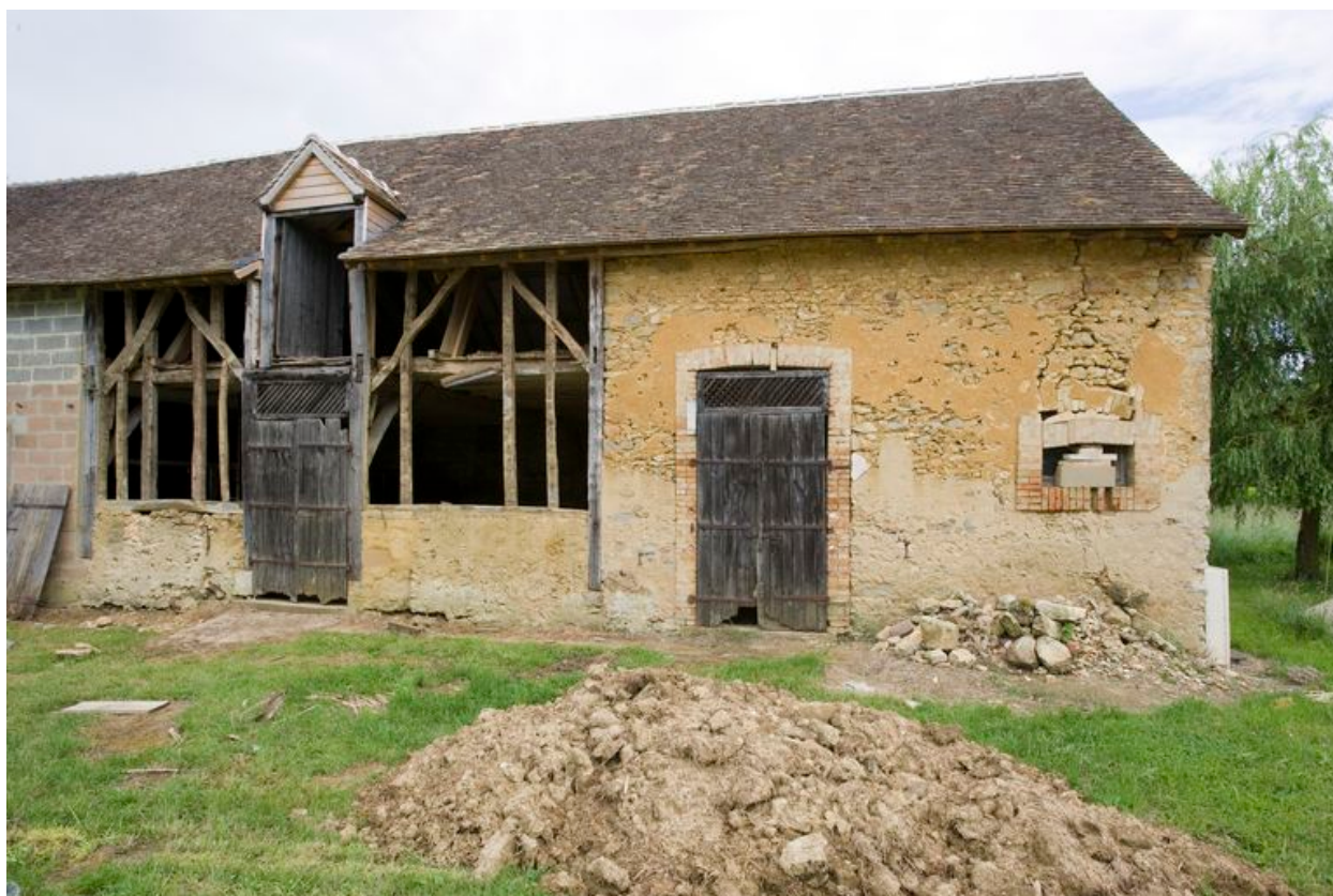
Étables, élévation sur cour.
