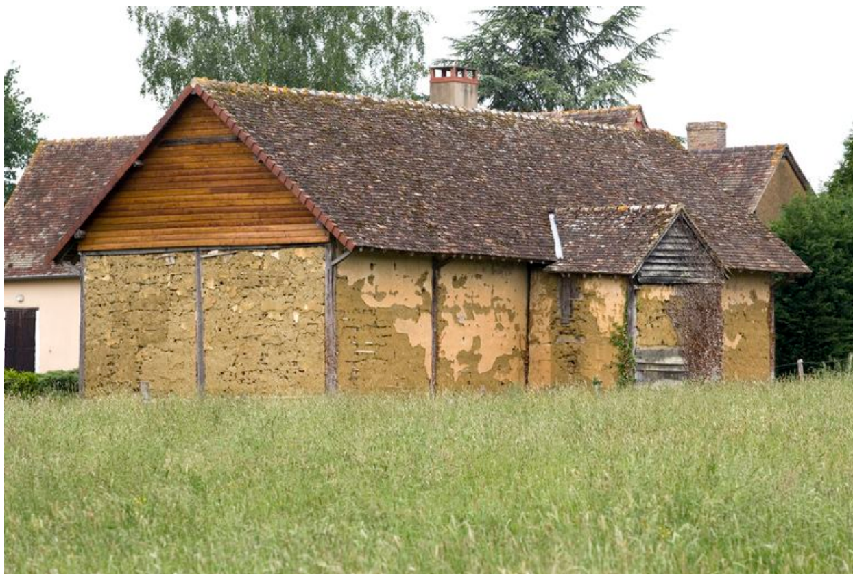
Grange, élévation postérieure.
