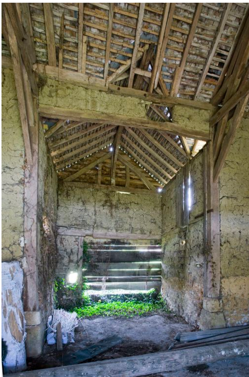
Vue intérieure du bâtiment flanquant l'arrière de la grange.
