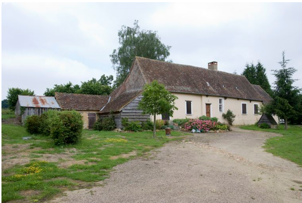
Logis vu depuis la cour.
