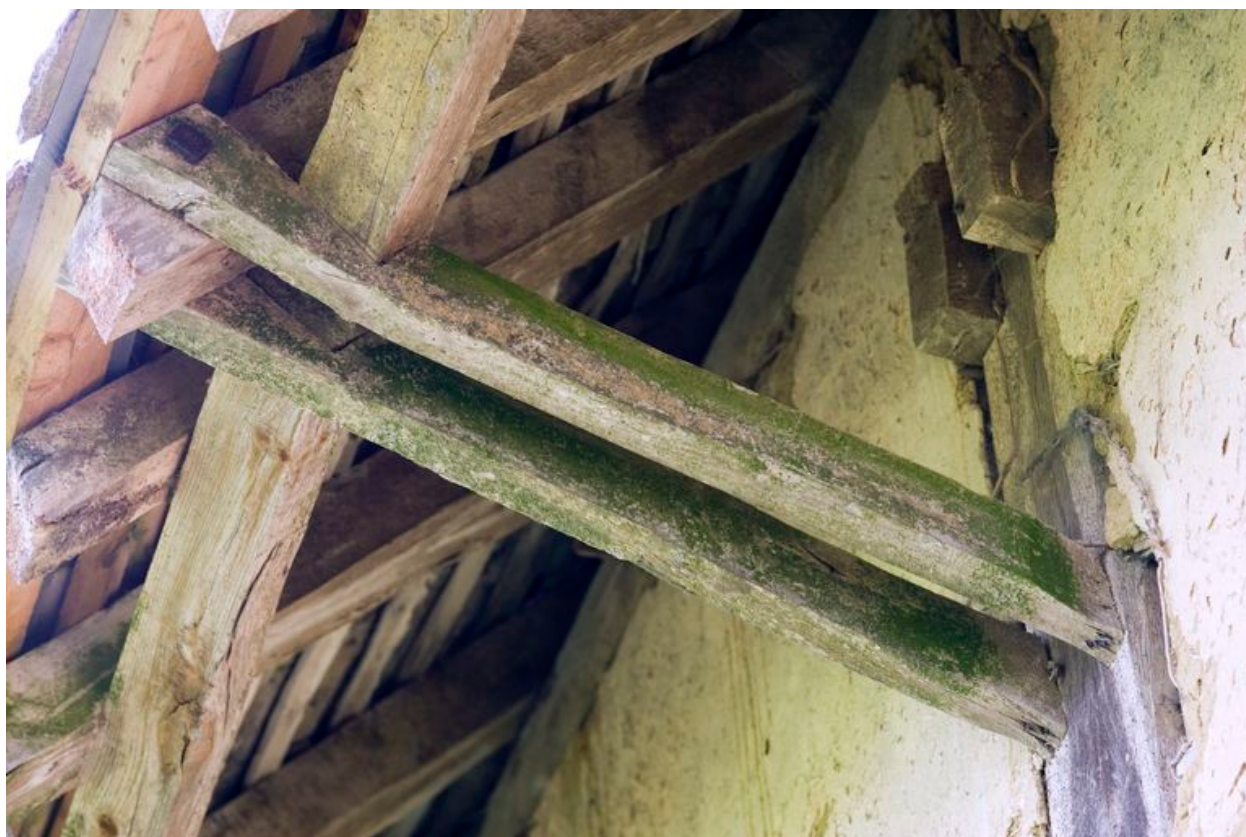
Détail d'une jambette soutenant le débord de toiture de la grange.
