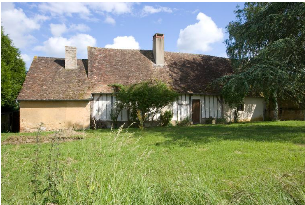
Élévation postérieure du logis.
