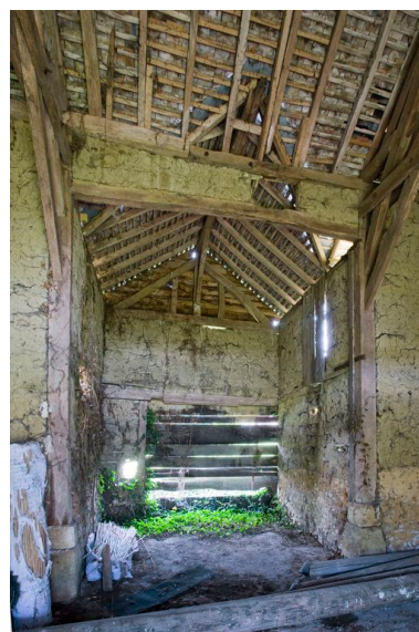
Vue intérieure du bâtiment flanquant l'arrière de la grange. Phot. Yves Guillotin IVR52_20107202406NUCA
