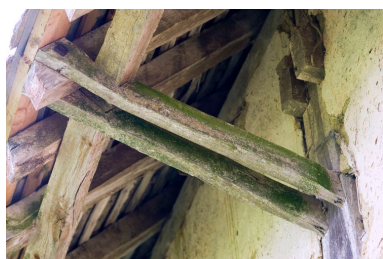
Détail d'une jambette soutenant le débord de toiture de la grange. Phot. Yves Guillotin IVR52_20107202404NUCA
