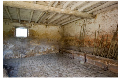
Étables, vue intérieure de l'étable de droite. Phot. Yves Guillotin IVR52_20107202407NUCA
