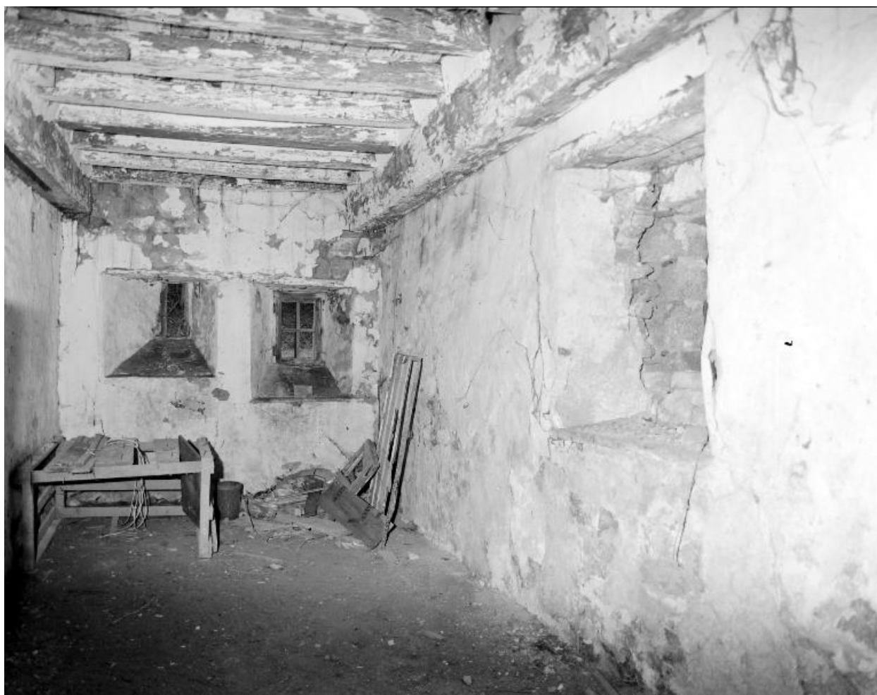
La seconde pièce du rez-de-chaussée, au sud.
