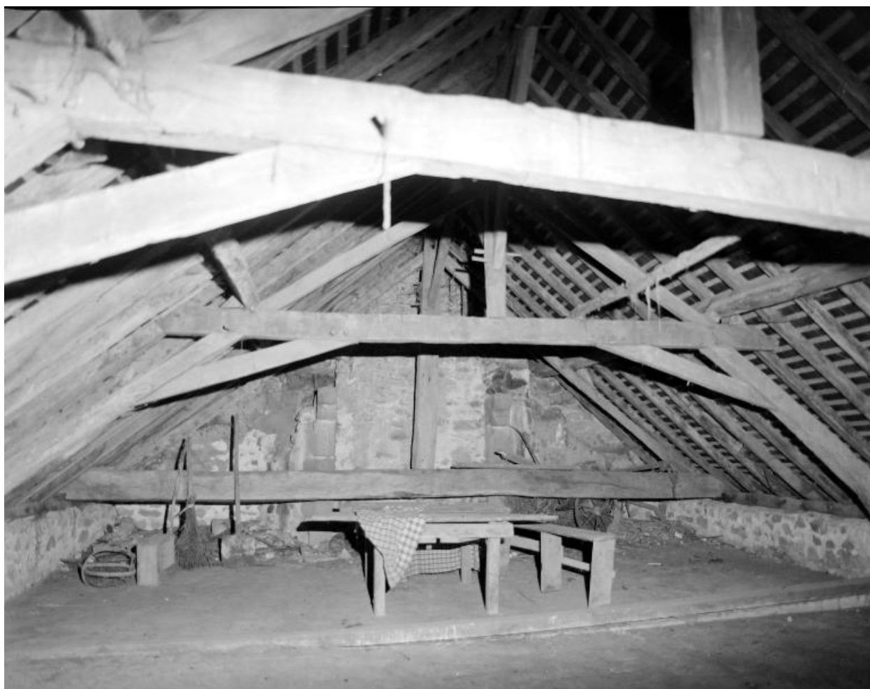
Le comble vu du sud.
