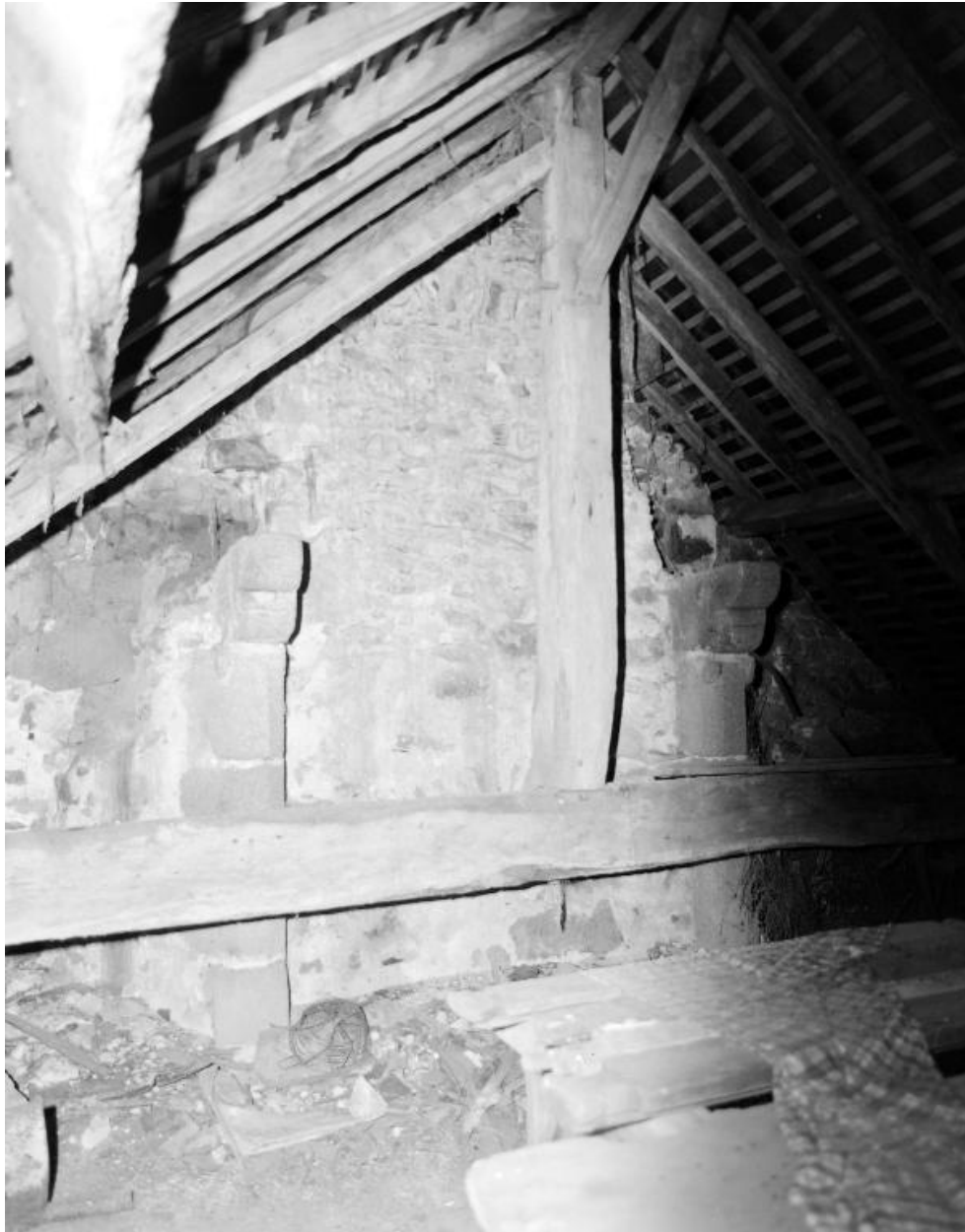
Le mur nord du comble : vestiges de la cheminée.
