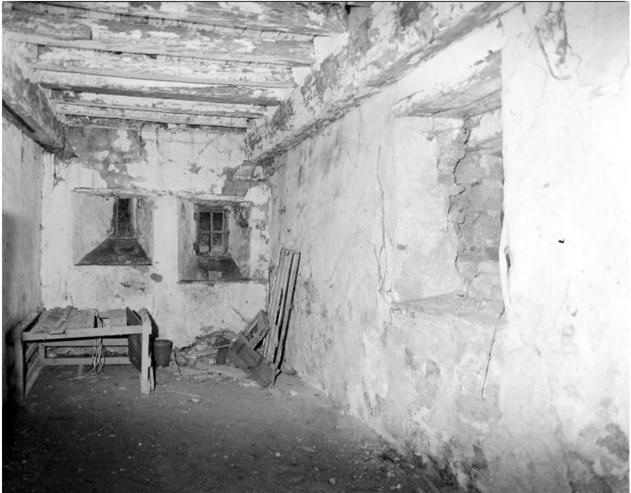
La seconde pièce du rez-de-chaussée, au sud.
