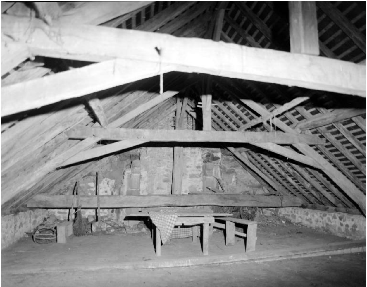
Le comble vu du sud.
