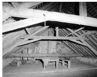
Le comble vu du sud. Phot. François Lasa IVR52_20025300496X
