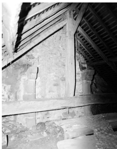
Le mur nord du comble : vestiges de la cheminée. Phot. François Lasa IVR52_20025300497X
