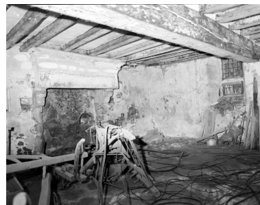
La principale pièce du rez- de-chaussée vue du sud-ouest. Phot. François Lasa IVR52_20025300499X
