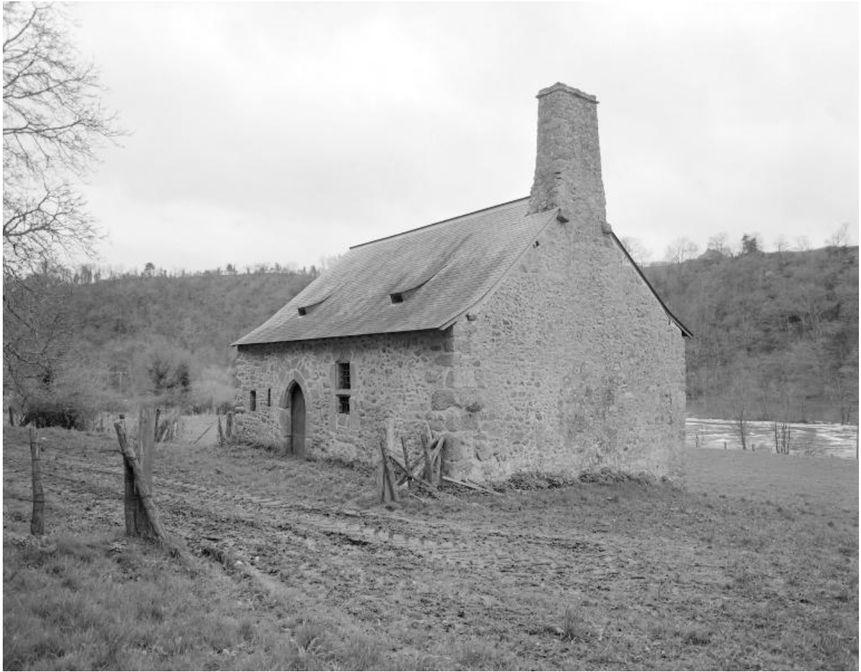
La façade principale (est) et le pignon nord.
