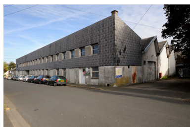
Vue générale de l'usine de chaussures Pasquier. Phot. Bruno Rousseau, Phot. Youenn Communeau IVR52_20114901080NUCA
