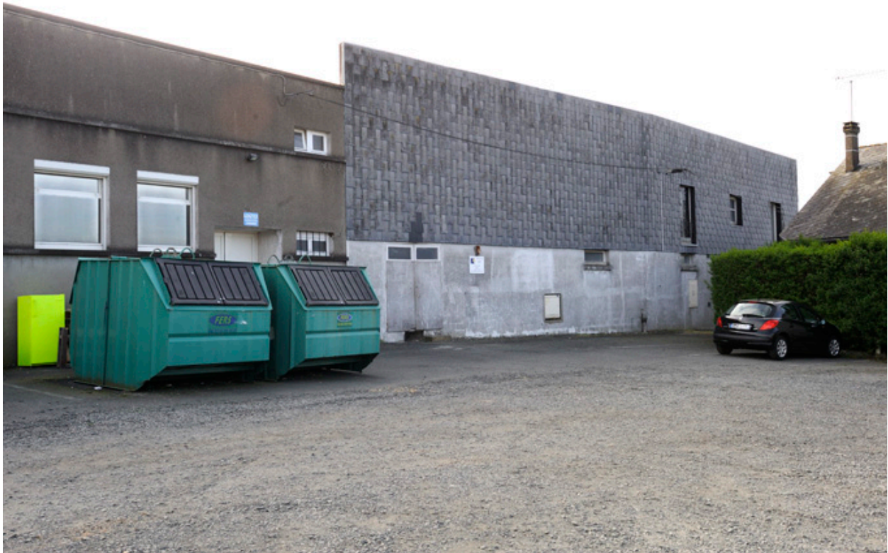
Vue de la façade ouest de l'usine Pasquier et d'un bâtiment de la Société Anonyme de Chaussures (SAC).
