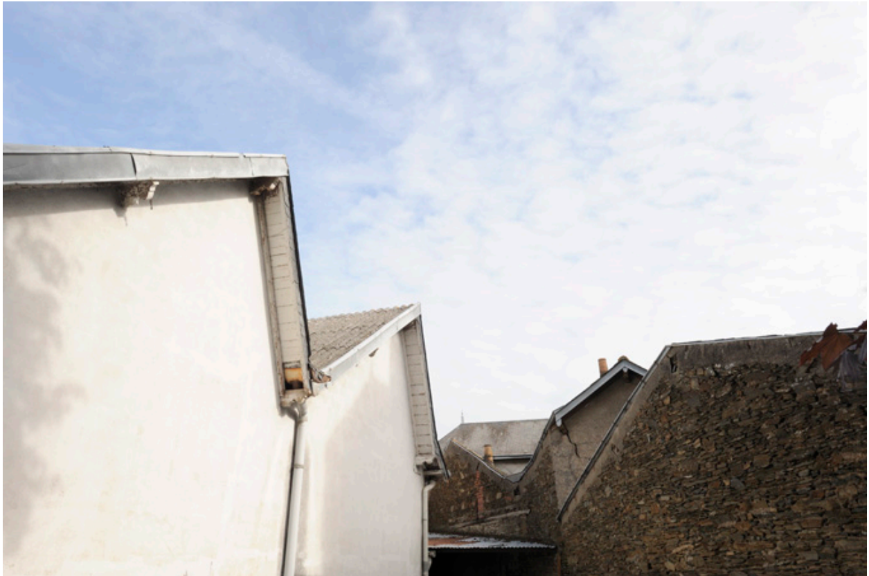
Vue de la façade est de l'usine Pasquier.
