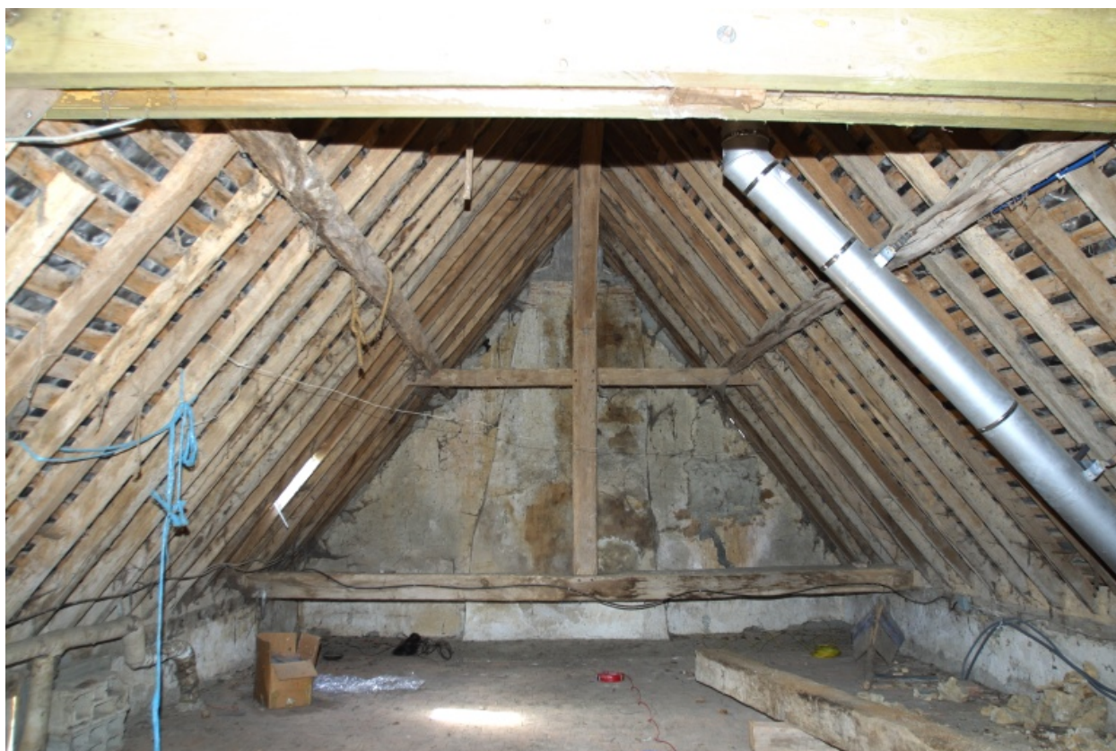
La charpente de la partie ouest du logis vue depuis l'est.
