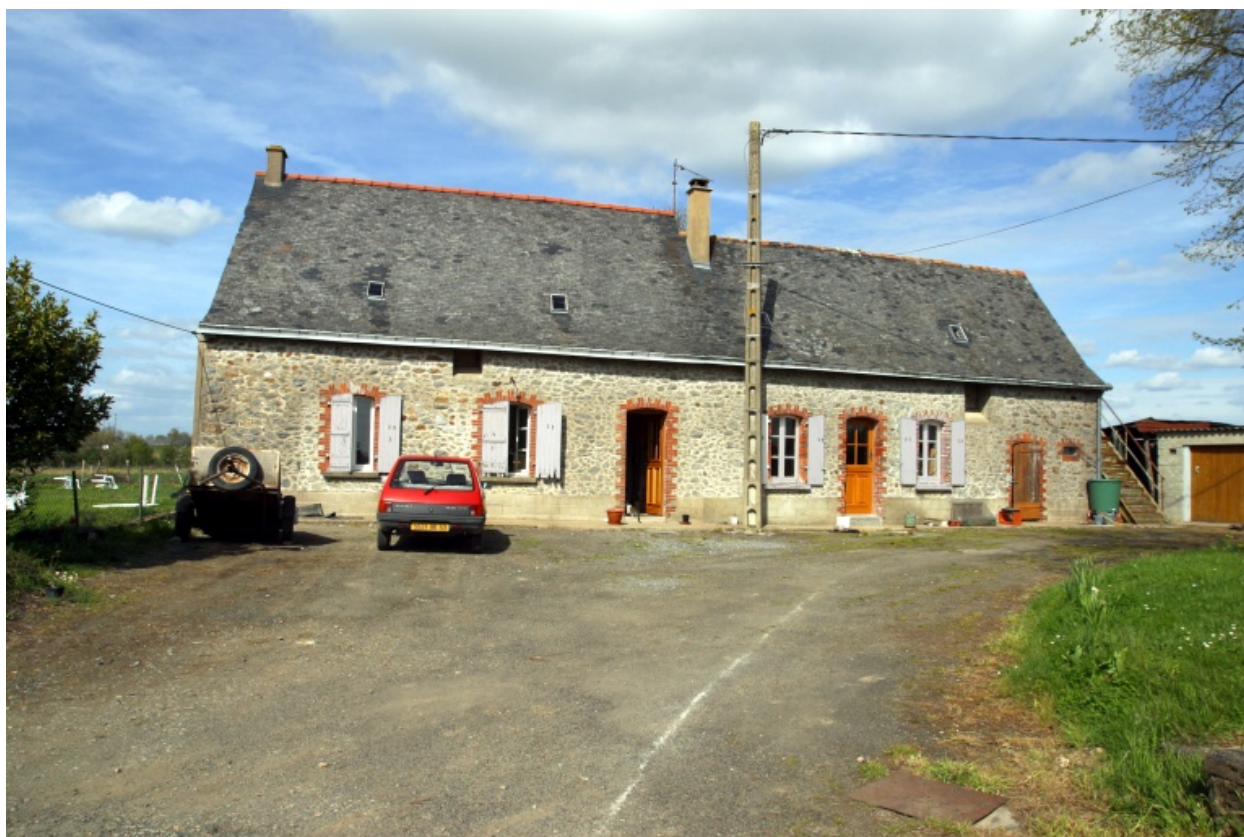
Le logis : façade principale.
