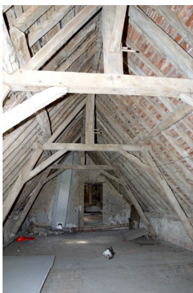
La charpente de la partie est du logis vue depuis l'est. Phot. François Lasa IVR52_20045301526NUCA
