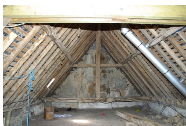
La charpente de la partie ouest du logis vue depuis l'est. Phot. François Lasa IVR52_20045301525NUCA
