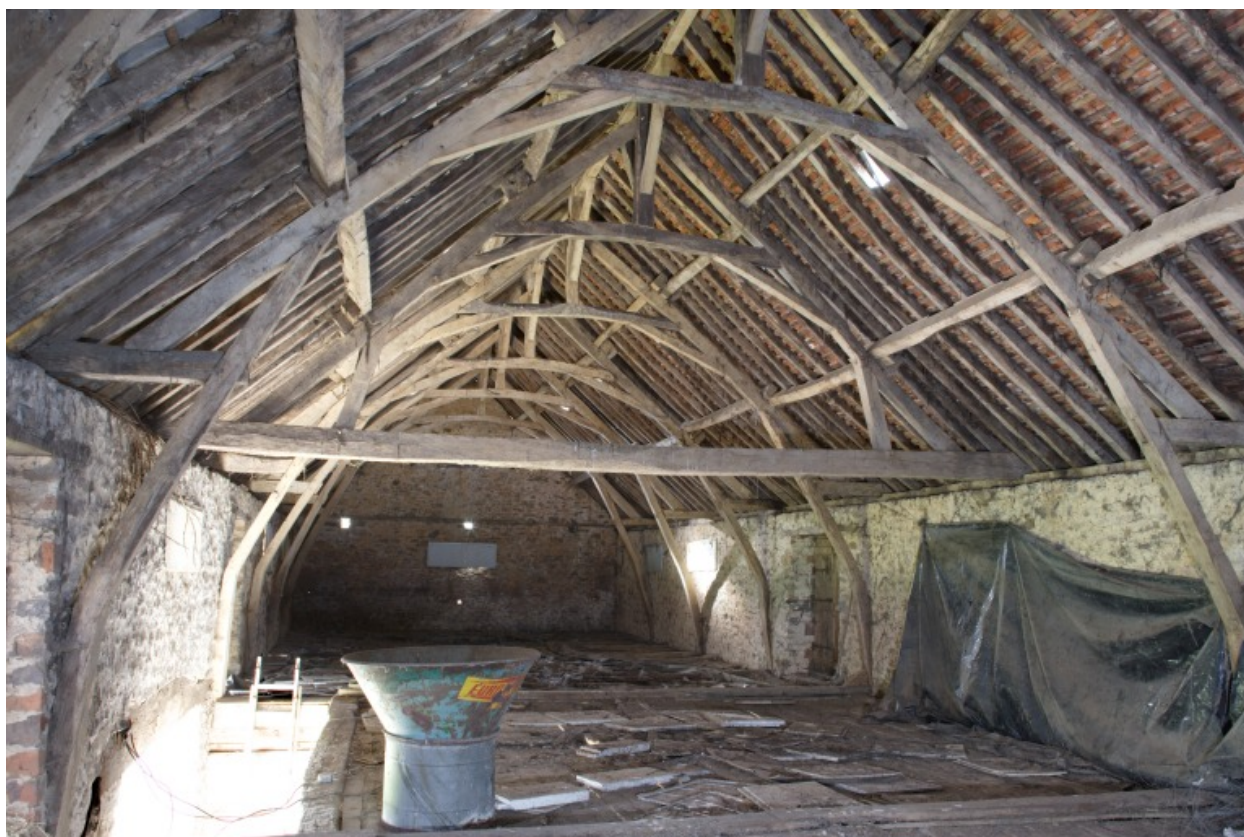
La charpente de l'étable-grange.
