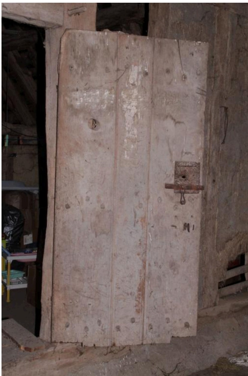
Cloison du comble : menuiserie de porte.
