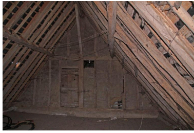
Comble : charpente à pannes dans des encoches et cloison à pan de bois. Phot. Jean-Baptiste Darrasse IVR52_20097201676NUCA
