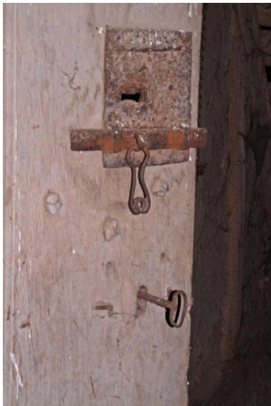
Porte de la cloison du comble : serrures différentes. Phot. Jean-Baptiste Darrasse IVR52_20097201678NUCA
