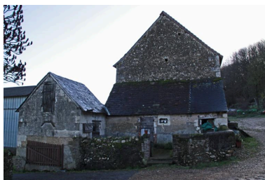
Toits à porcs. Phot. Jean-Baptiste Darrasse IVR52_20097201687NUCA
