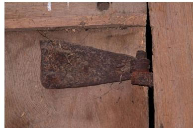
Porte de la cloison du comble : gond et penture supérieurs. Phot. Jean-Baptiste Darrasse IVR52_20097201680NUCA
