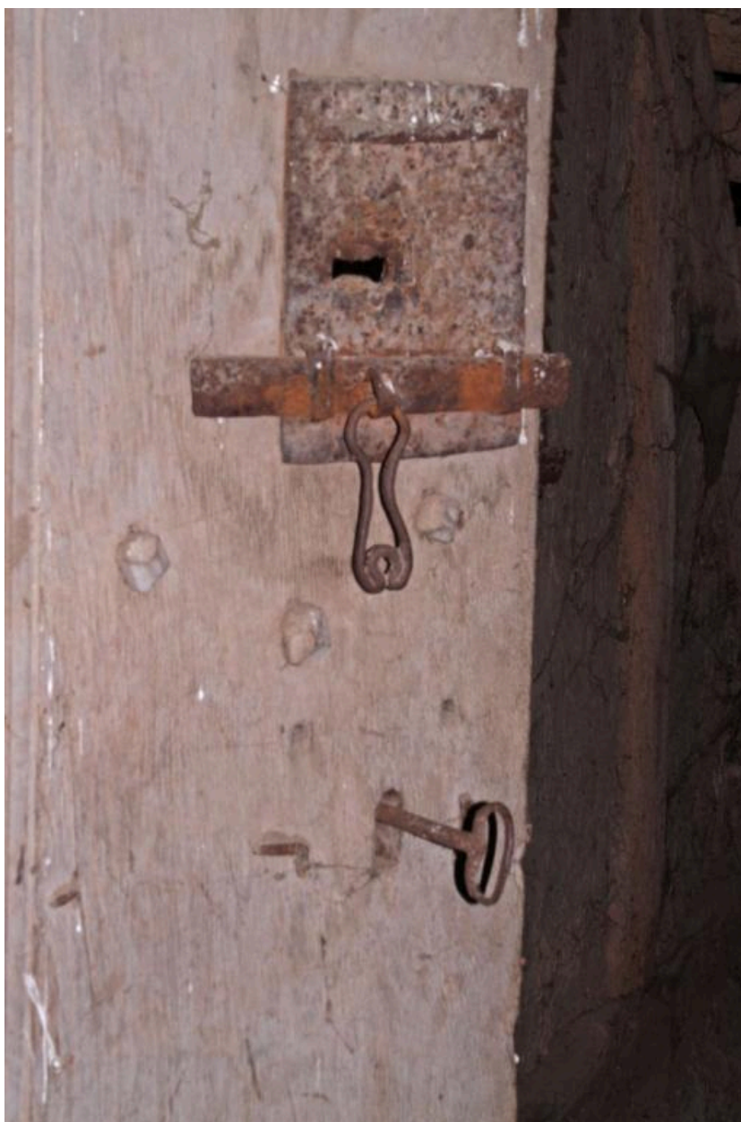
Porte de la cloison du comble : serrures différentes.
