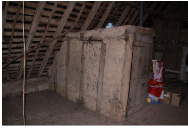
Façtage de la cage d'escalier en pan de bois. Phot. Jean-Baptiste Darrasse IVR52_20097201675NUCA
