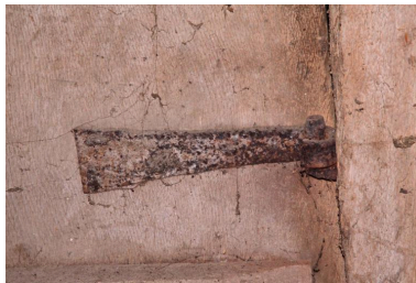
Porte de la cloison du comble : porte de la cloison, gond et penture inférieurs. Phot. Jean-Baptiste Darrasse IVR52_20097201679NUCA
