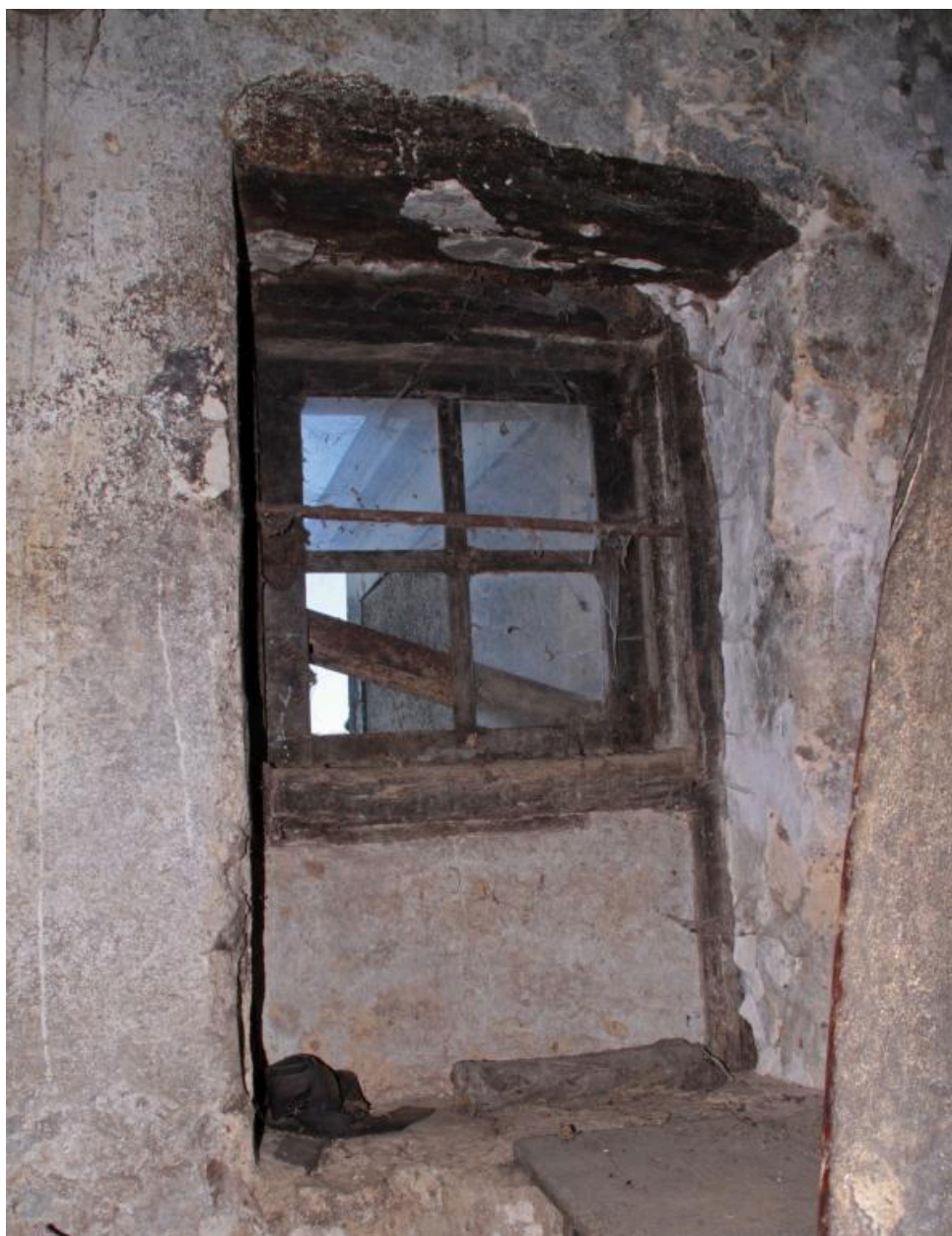
Buanderie : petite baie sur la façade postérieure.
