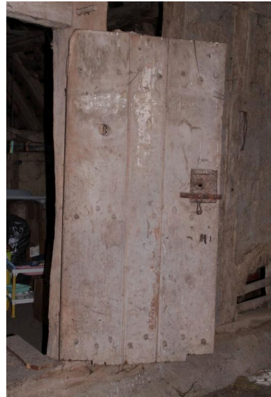
Cloison du comble : menuiserie de porte. Phot. Jean-Baptiste Darrasse IVR52_20097201677NUCA
