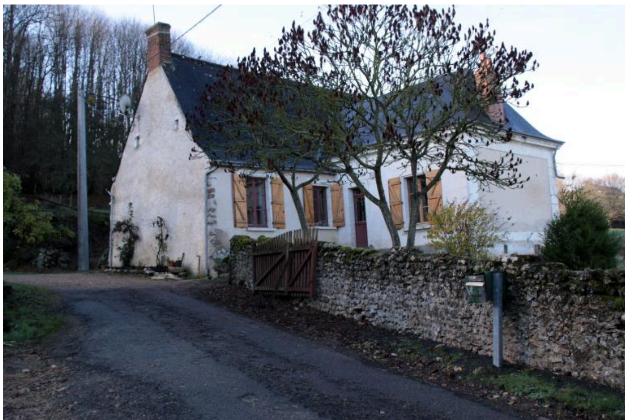
Maison, vue d'ensemble prise du nord-est.
