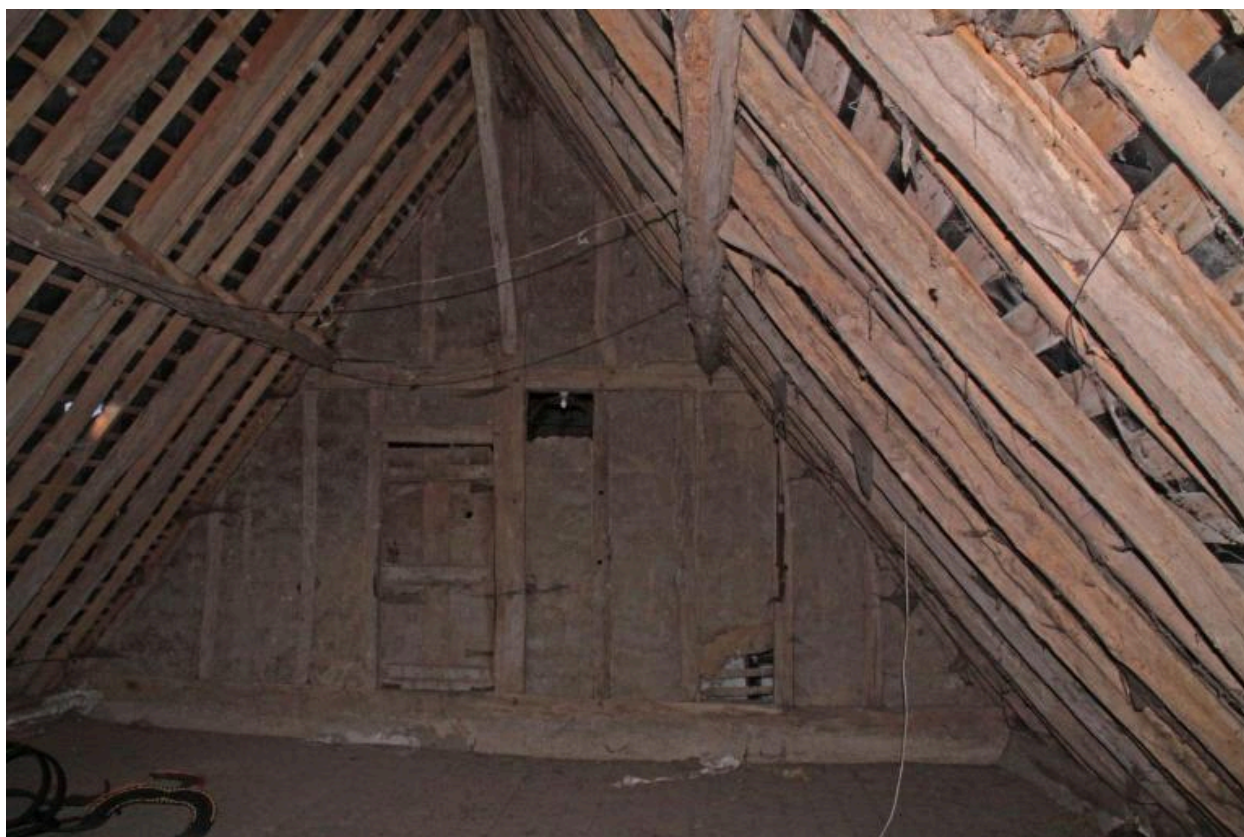
Comble : charpente à pannes dans des encoches et cloison à pan de bois.
