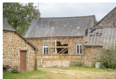
Le logis en cours de transformation. Phot. Pierre-Bernard Fourny IVR52_20215301035NUCA
