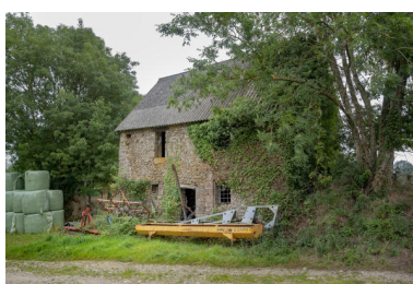
Le bâtiment en fond de cour. Phot. Pierre-Bernard Fourny IVR52_20215301037NUCA
