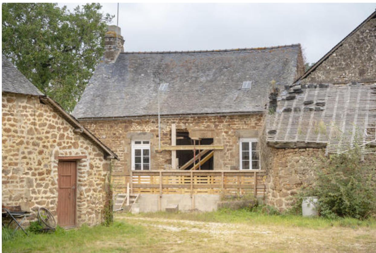
Le logis en cours de transformation.
