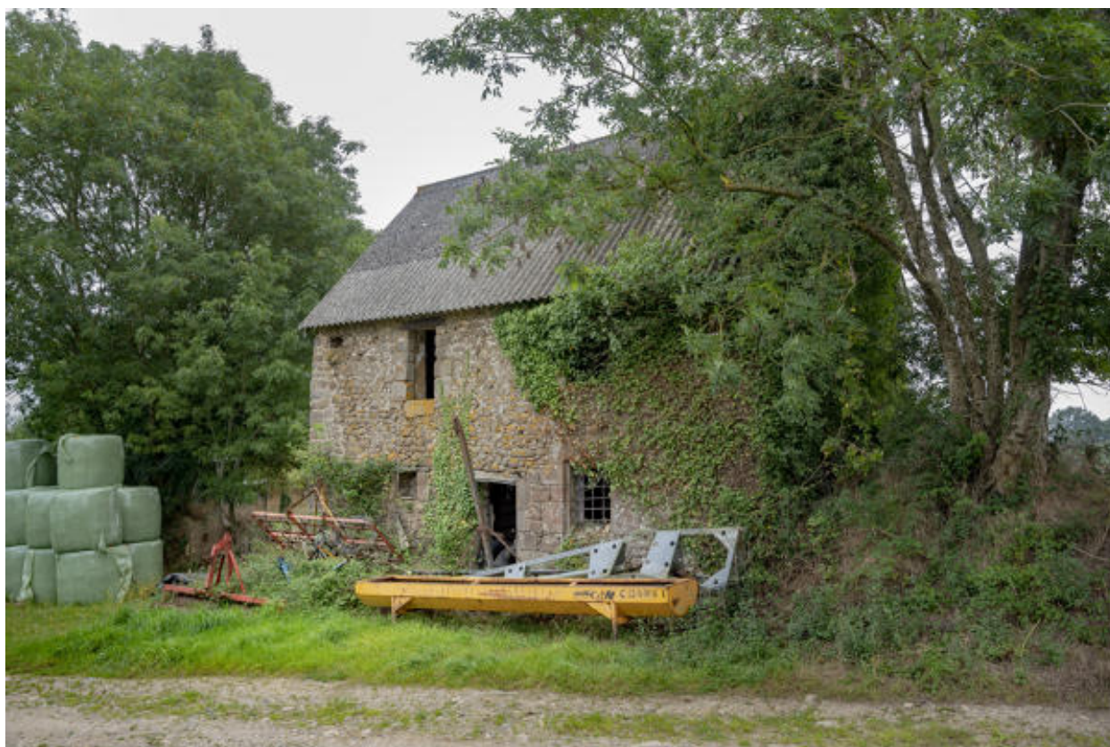
Le bâtiment en fond de cour.
