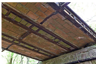
Détail du tablier Phot. Yves Guillotin IVR52_20127201230NUCA
