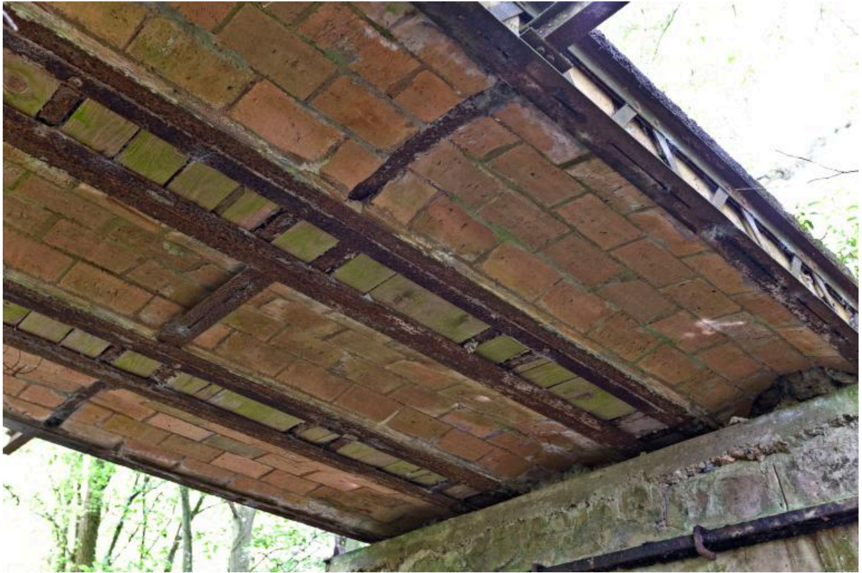
Détail du tablier
