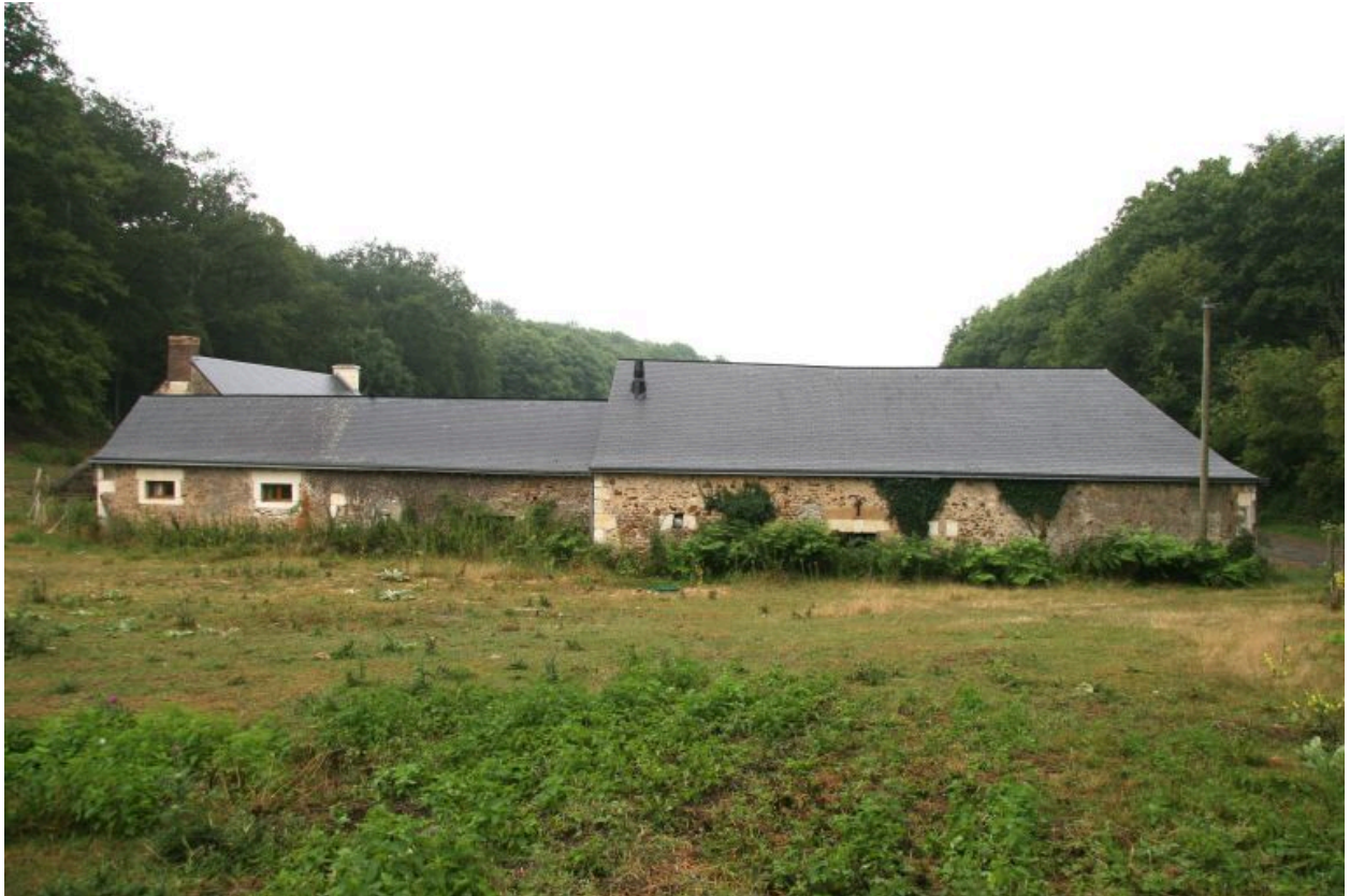
La grange et les étables : façade postérieure.
