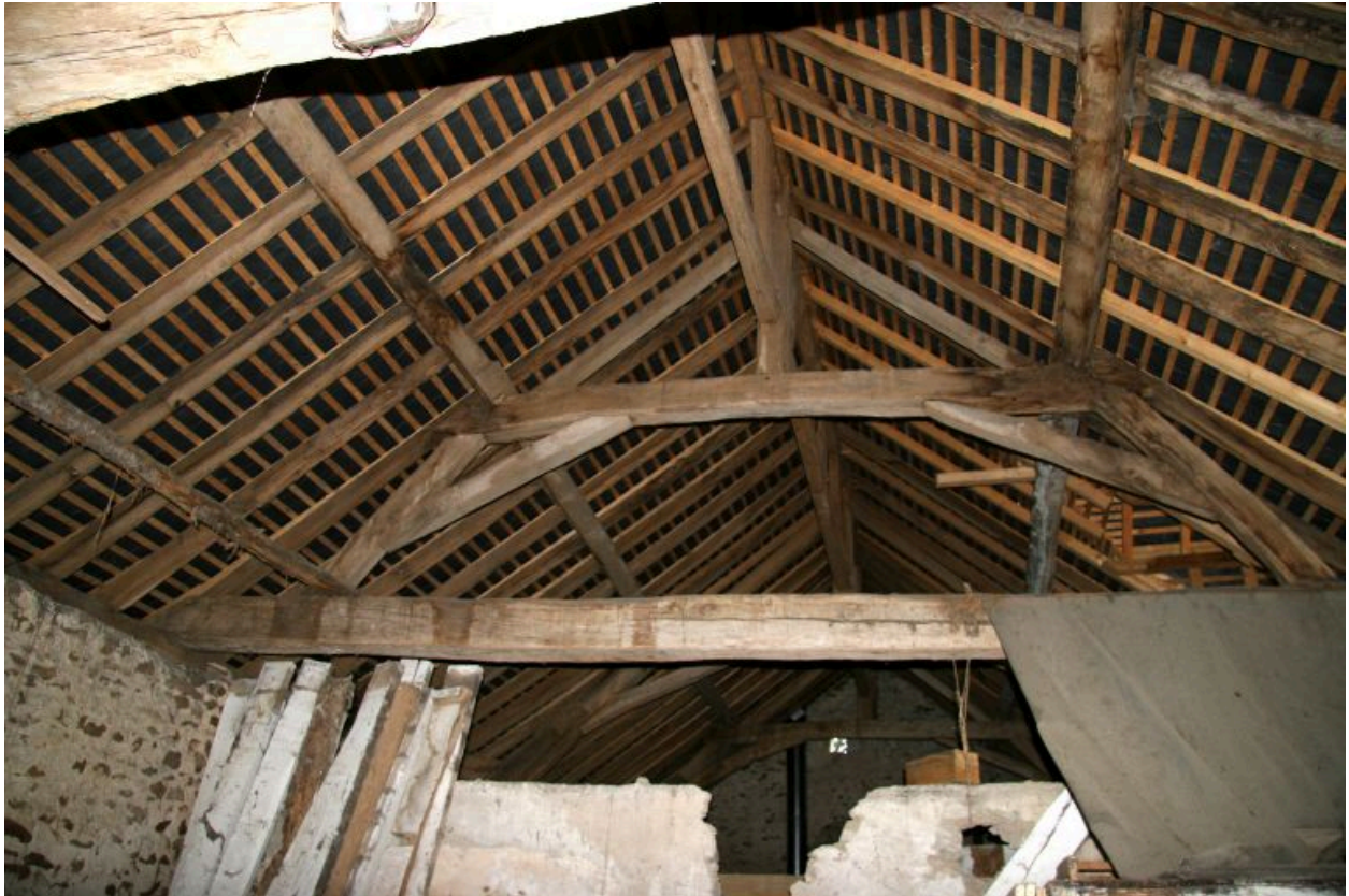
La grange : la charpente.
