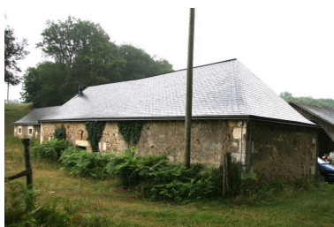
La grange : toit à croupe. Phot. Jean-Baptiste Darrasse IVR52_20057202485NUCA
