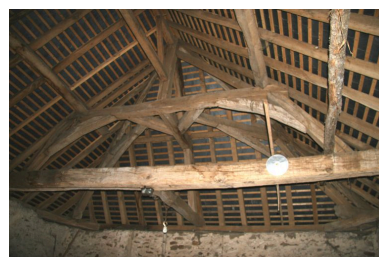
La grange : charpente. Phot. Jean-Baptiste Darrasse IVR52_20057202484NUCA
