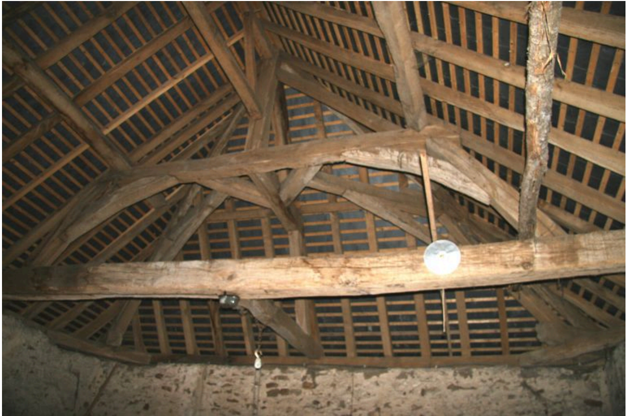
La grange : charpente.
