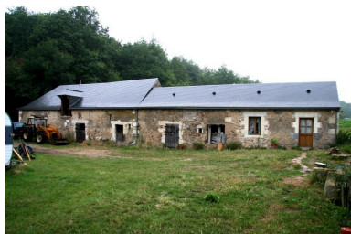
Les dépendances : la grange, la bergerie, l'étable. Phot. Jean-Baptiste Darrasse IVR52_20057202480NUCA
