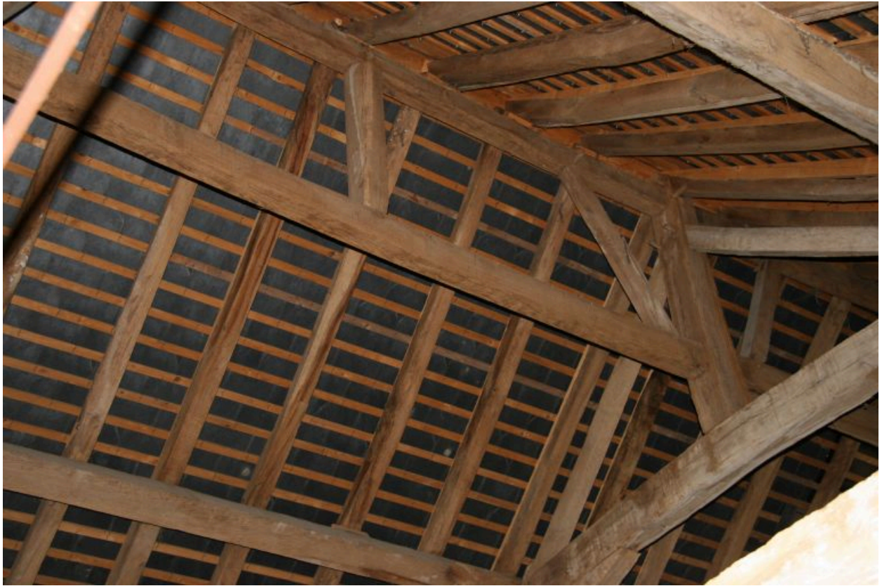
La grange : charpente à double sous-faîtage.
