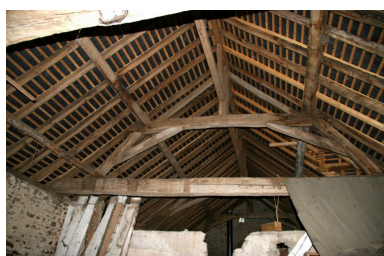
La grange : la charpente. Phot. Jean-Baptiste Darrasse IVR52_20057202483NUCA
