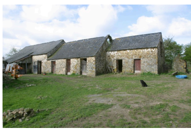
Les dépendances situées à l'ouest de la cour : remise et porcheries-bergeries. Phot. François Lasa
