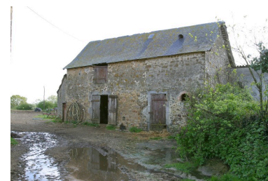
L'étable à chevaux. Phot. François Lasa IVR52_20035301373NUCA
