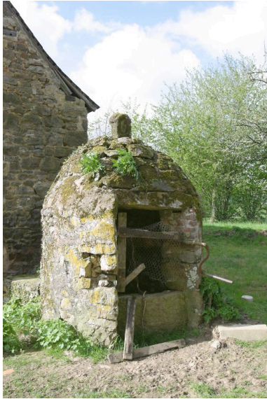
Le puits. Phot. François Lasa IVR52_20035301374NUCA
