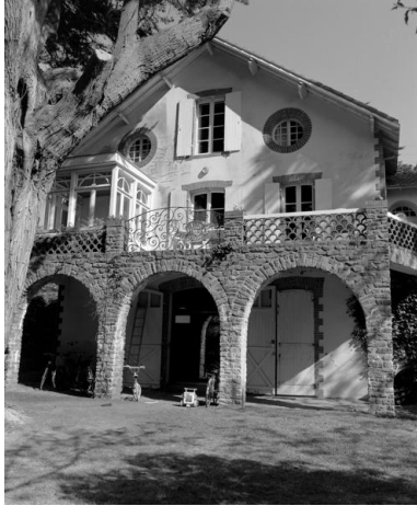
Villa Bonne Source, élévation principale. Phot. Denis Pillet IVR52_19974401066X
